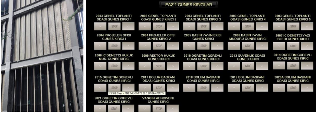
Görsel 4.29. Güneş Kırıcılar ve Otomasyon Sistemi (Kişisel ve YİDB Arşivi)
