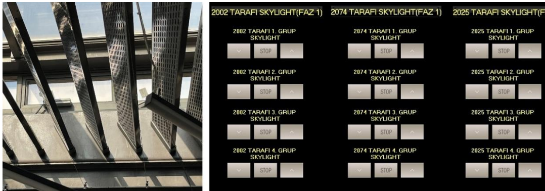
Görsel 4.37. Freecooling Havalandırma ve Otomasyon Sistemi (Kişisel ve YİDB Arşivi)
