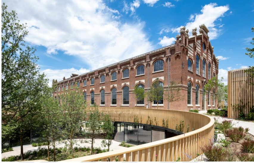
Görsel 3.17. Ombu Office Building Genel Görünüş ( http-25 )
