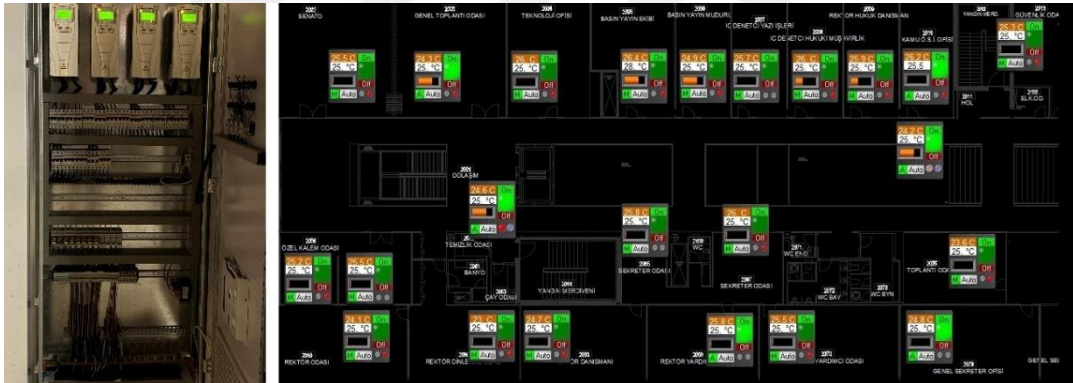
Görsel 4.27. HVAC Otomasyon Sistemi (Kişisel ve YİDB Arşivi)
