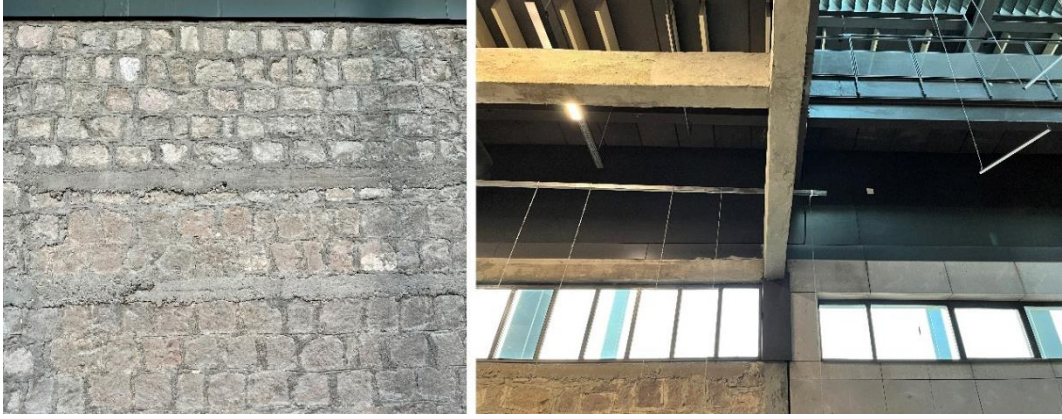
Görsel 4.34. Onarım Sırasında Yerel Kayseri Taşı Kullanımı (Kişisel Arşiv)
