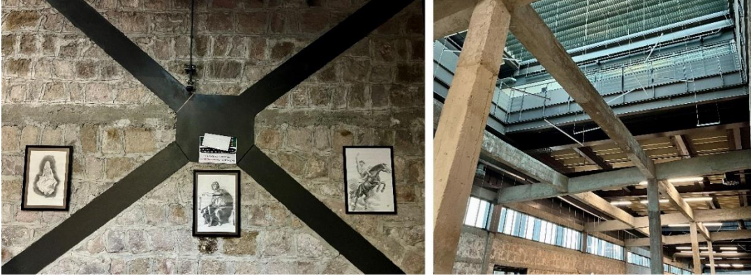
Görsel 4.33. Pamuk Ambarı Binası Yapısal Güçlendirme ve Korunan Strüktür (Kişisel Arşiv)
