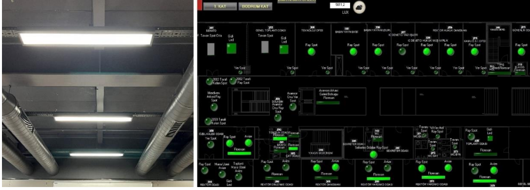
Görsel 4.28. Led Aydınlatma ve Otomasyon Sistemi (Kişisel ve YİDB Arşivi)
