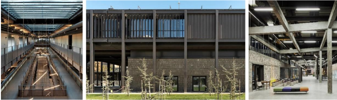
Görsel 4.7. Uyarlanabilir Yeniden Kullanım Sonrası İdari ve Derslik Binası ( http-31 )
