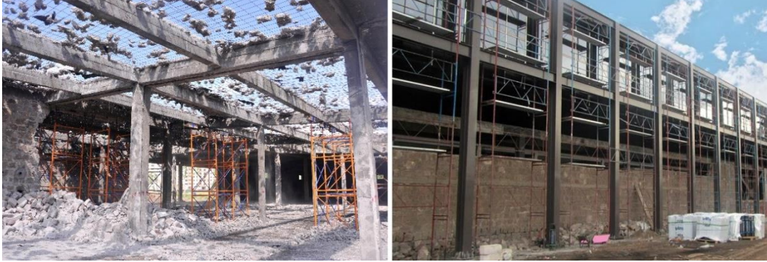
Görsel 4.4. Pamuk Ambarı Binası'nın Dönüşüm Sürecindeki Yapım Çalışmaları (YİDB Arşivi)
