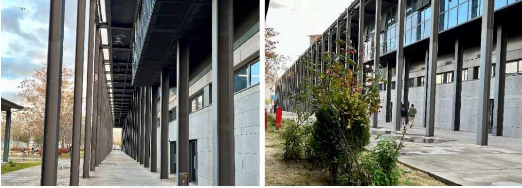
Görsel 4.19. İdari ve Derslik Bina Cephesindeki Pergola Sistemi (Kişisel Arşiv)
