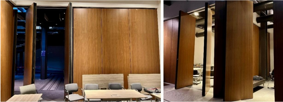
Görsel 4.42. İç Mekandaki Modüler Hareketli Duvar Panelleri (Kişisel Arşiv)
