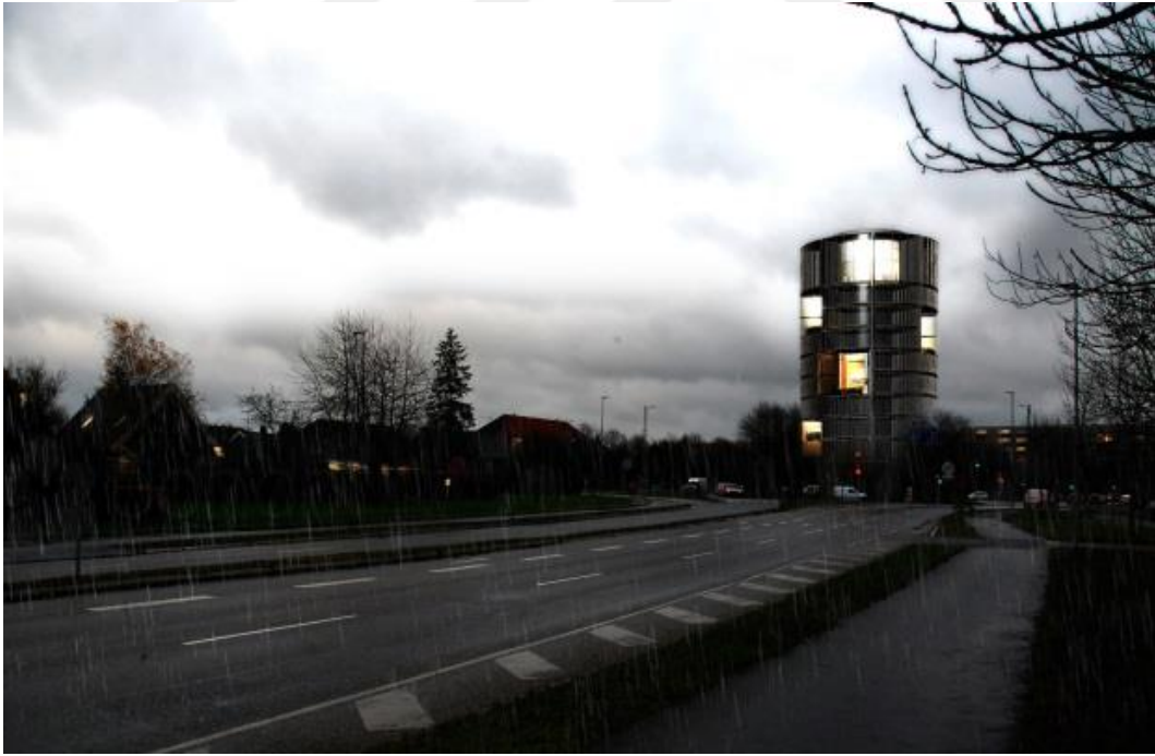
Şekil 3.37 Dönüşüm sonrası Tårnby Water Tower (Schires, 2019)
