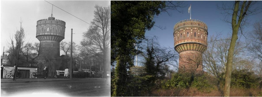
Şekil 3.47 Su kulesinin dönüşüm öncesi ve sonrası
