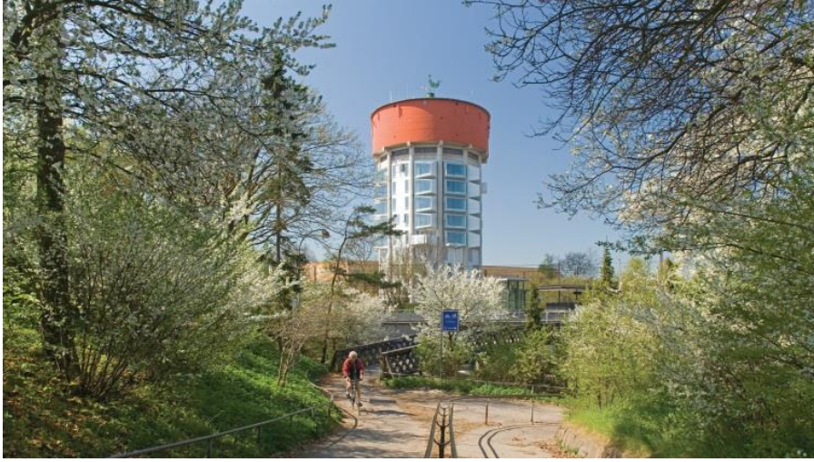
Şekil 3.43 Jaegersborg Water Tower – Dönüşüm sonrası (Archdaily, 2008)
