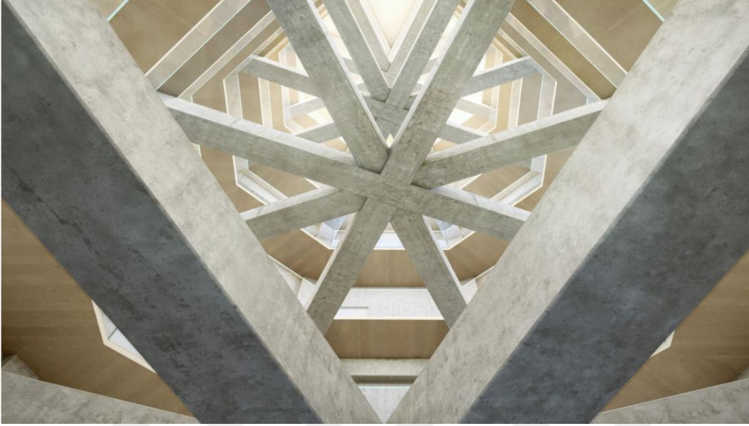
Şekil 3.35 Tårnby Water Tower / İç kiriş yapısı
