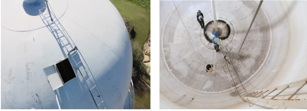
Şekil 2.17 Bir su kulesinin temizlenmesi (DMAX Türkiye, 2024)
