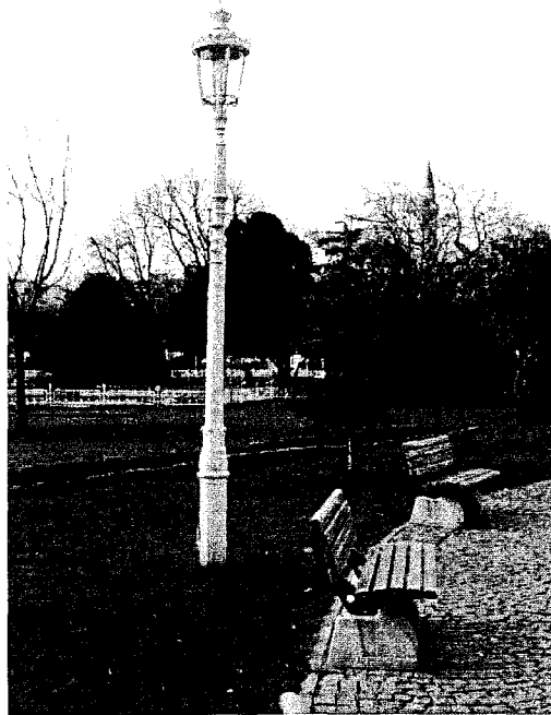
Resim 4. 16. Dökme demirden beyaza boyanmış cam armatürlü aydınlatma elemanları.
