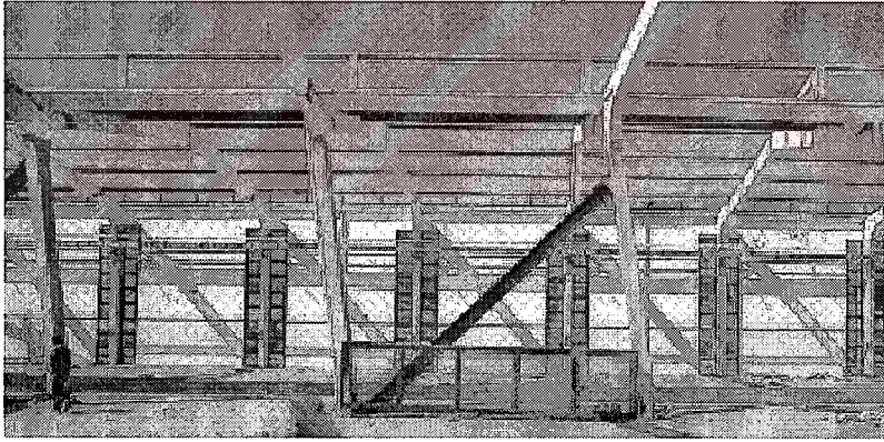
Şekil 3.3: Kolonlarda büyük yatay ötelenme hasarı.
