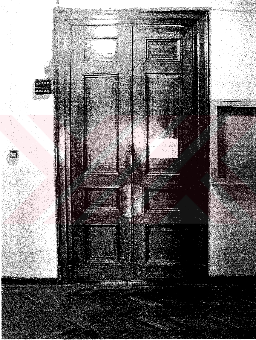
Resim 4.76 Düz atkılı kapı tipi örneği
