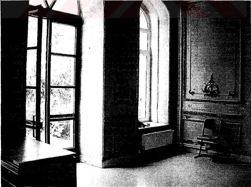
Resim 4.25 Zemin kat Z 0' nolu mekanın D duvarı ( Şekil 4.8)
