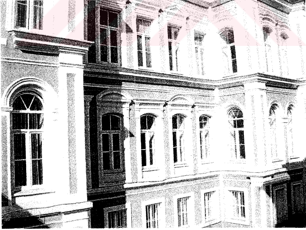
Resim 4.12 Doğu cephesindeki pencere düzeni
