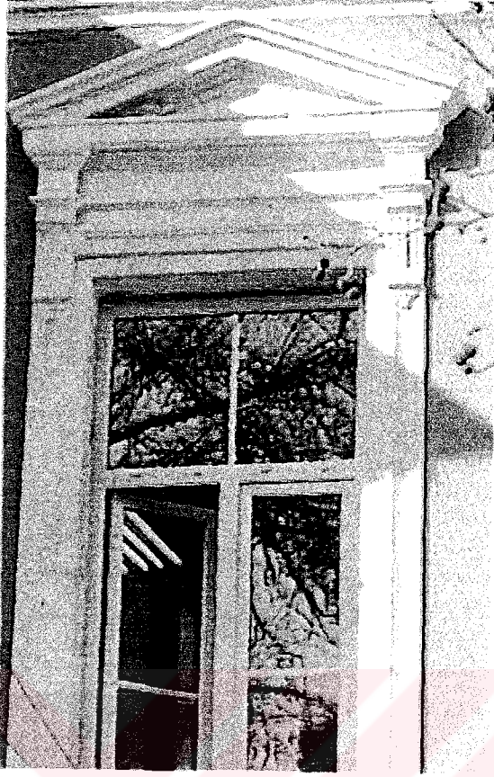
Resim 4.80 Düz atkılı pencere Tipi 1-3 (Şekil 4.52)
