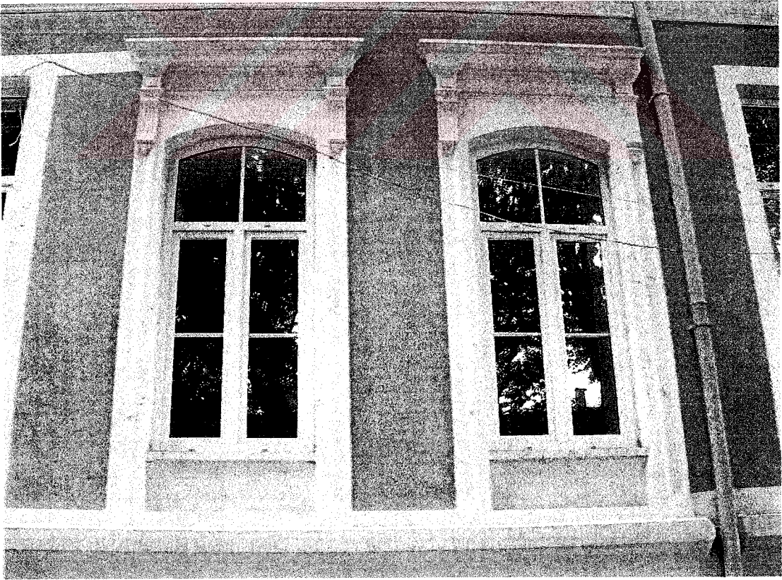
Resim 4.18 Çukur Saray batı cephesinde özgün kalan zemin kat pencere yan ve üst elemanları
