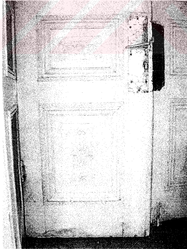
Resim 4.97 Zemin kat K Z-19' nolu kapının B görünüşü ( Şekil 4.60)
