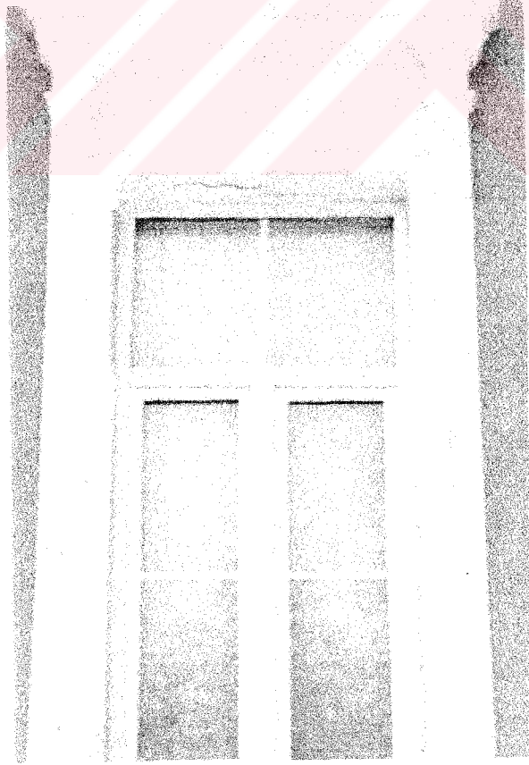
Resim 4.79 Düz atkılı pencere Tipi 1-2 (Şekil 4.52)
