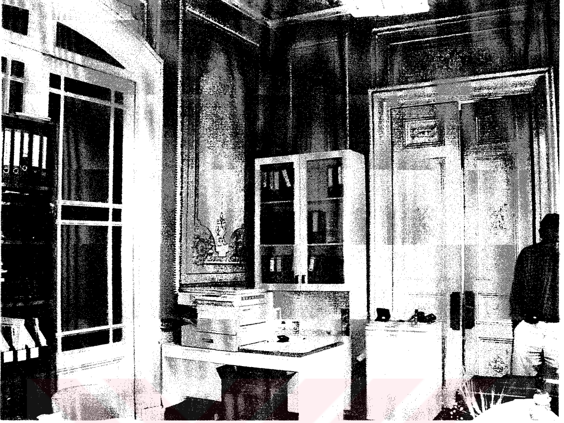
Resim 4.57 Birinci kat 1-0' nolu mekanın A duvarı (Şekil 4.30)
