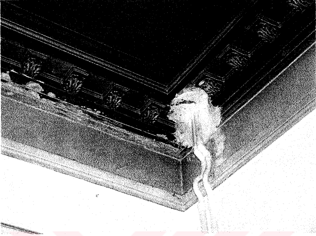
Resim 4.130 Mekanlarda mevcut tesisattan dolayı oluşan malzeme kayıpları (Zemin kat Z-13' nolu mekan)
