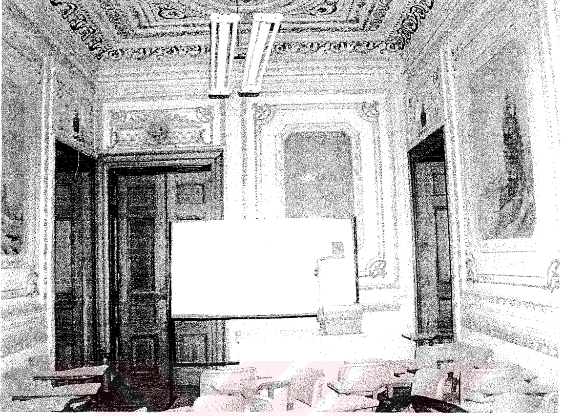
Resim 4.45 Zemin kat Z 9' nolu mekanın A duvarı (Şekil 4.17)
