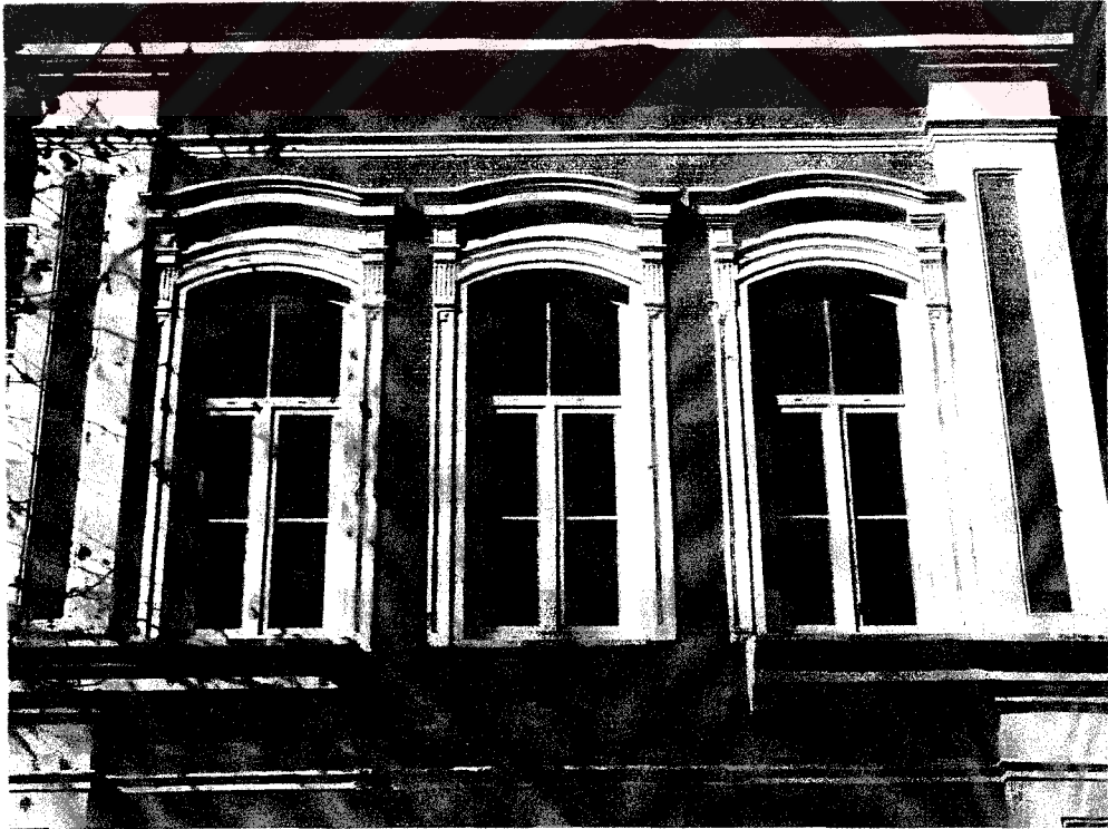
Resim 4.14 Birinci katta kesilen denizlik silmesi
