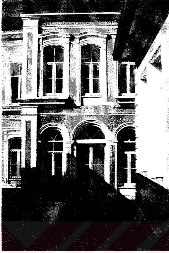
Resim 4.13 Doğu cephesinde sonradan kapatılarak pencere yapılan P Z-46 ve P 1-25' nolu pencereler
