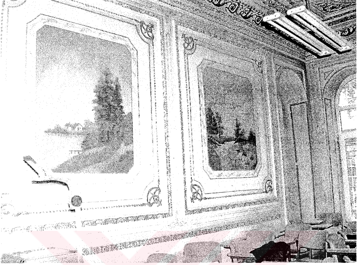
Resim 4.49 Zemin kat Z 9' nolu mekanın D duvarı (Şekil 4.17)
