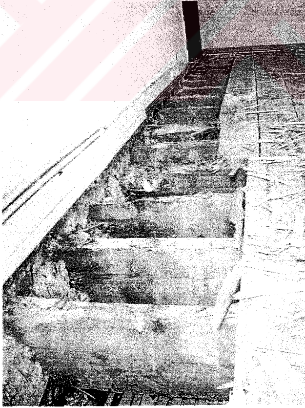
Resim 4.41 Z 5' nolu mekanın çürüyen ahşap kirişleri
