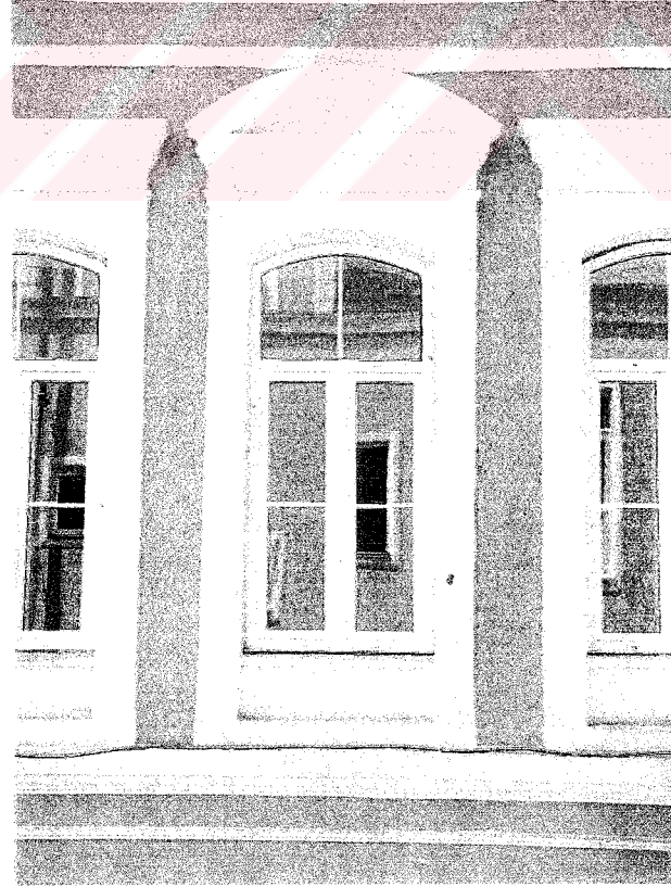
Resim 4.83 Basık kemerli pencere Tipi 2-3 (Şekil 4.52)
