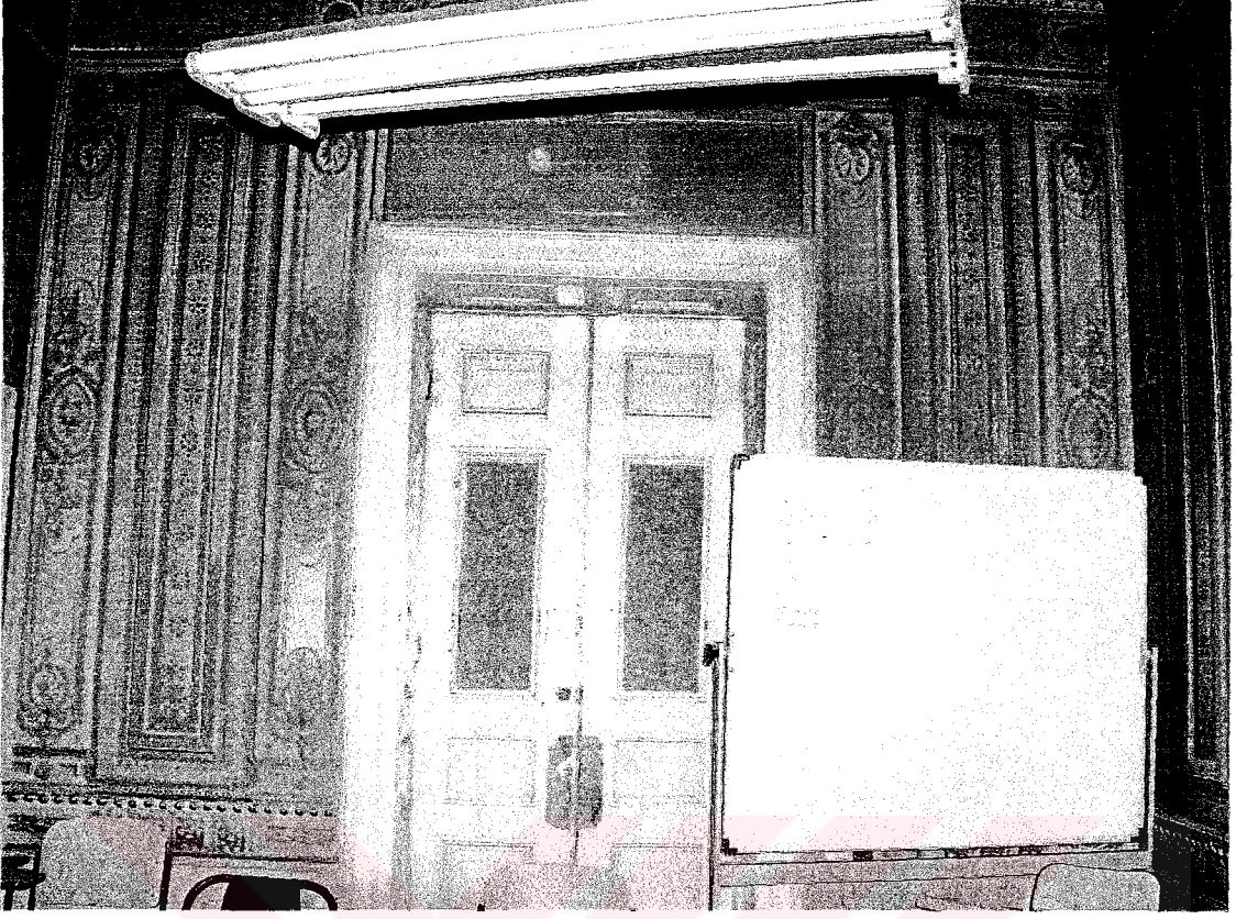
Resim 4.30 Zemin kat Z 2' nolu mekanın A duvarı (Şekil 4.12)
