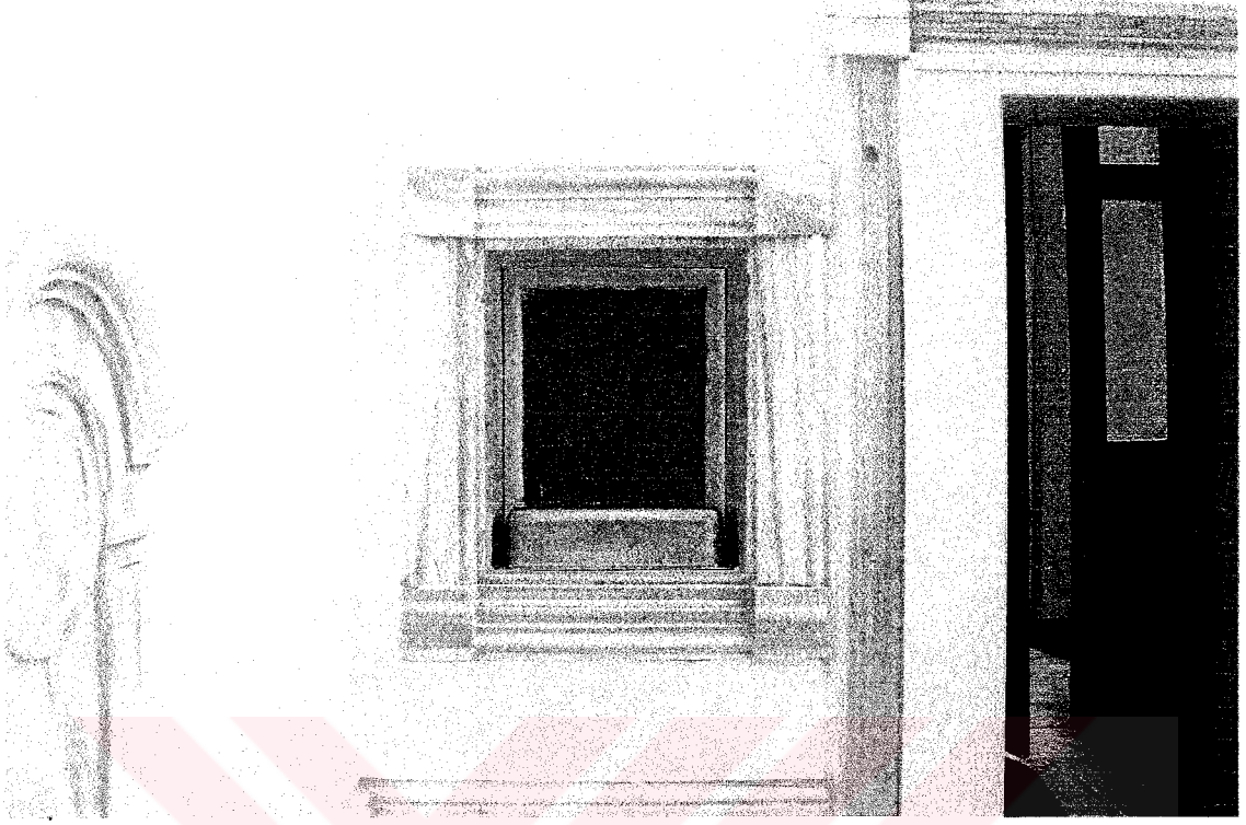
Resim 4.4 Birinci katta bulunan hamamın (1-29'nolu mekan) mermer söveli penceresi
