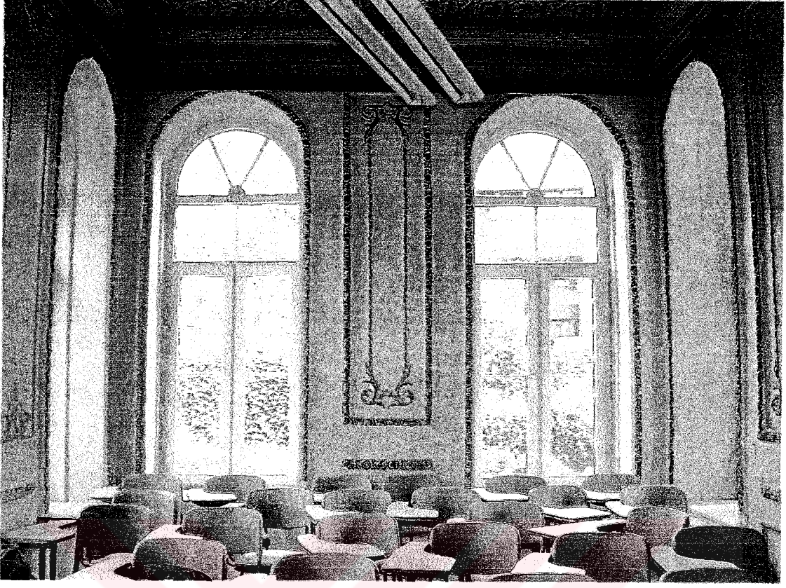
Resim 4.28 Zemin kat Z 1' nolu mekanın C duvarı (Şekil 4.10)
