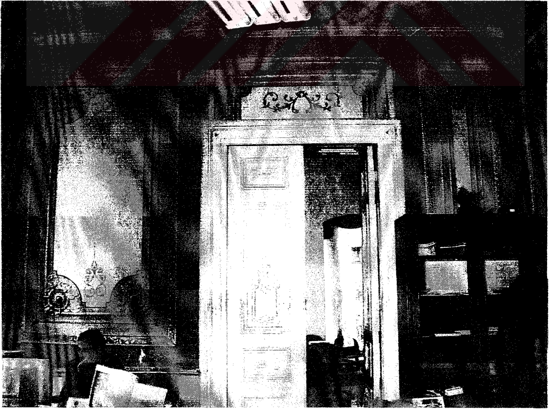
Resim 4.58 Birinci kat 1-0' nolu mekanın C duvarı (Şekil 4.30)
