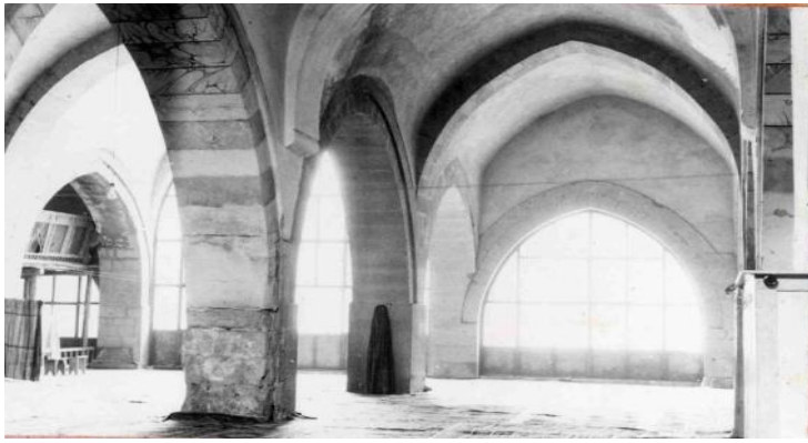
Şekil 67: Cami harim, üçlü kemer düzenlemesi, eski, güneydoğudan bakış (V. G. M. Arş.)
