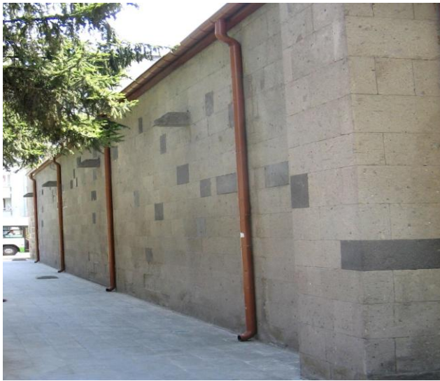
Şekil 55: Hacı Kılıç Medresesi, kuzey cephe, genel görünüş
