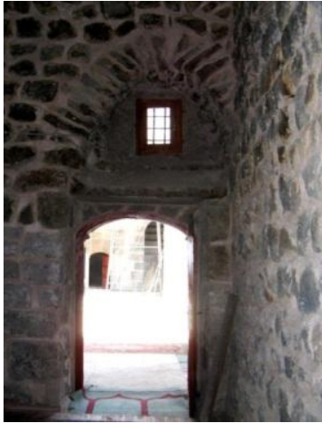
Şekil 97: Medrese, büyük oda/kışlık dershane, kapı üzerindeki pencere
