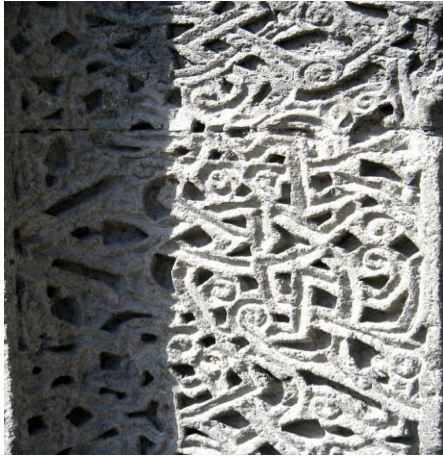
Şekil 108: Cami taçkapısı, güney cephe, ikinci bordür düzenlemesi, ayrıntı
