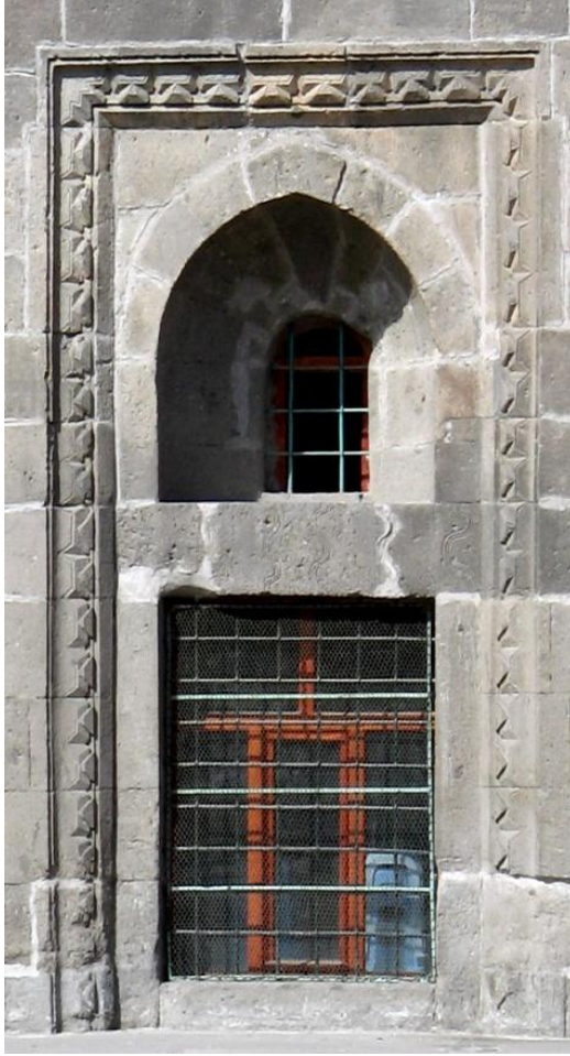
Şekil 151: Cami doğu cephe, dikdörtgen pencere, ayrıntı
