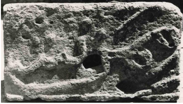
Şekil 21: Cami güney cephe, mihrap payandası üzerindeki kitabe parçası 5, onarımdan önce (V. G. M. Arş.)
