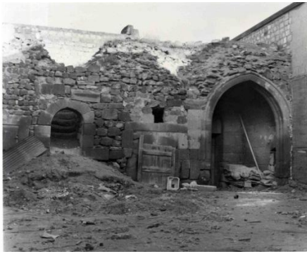
Şekil 85: Medrese, doğu kanat; giriş eyvanı, merdiven, onarımdan önce (V. G. M. Arş.)
