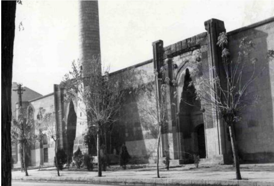
Şekil 31: Kayseri Hacı Kılıç Camii ve Medresesi, doğu cephe, onarımdan önce (V. G. M. Arş.)
