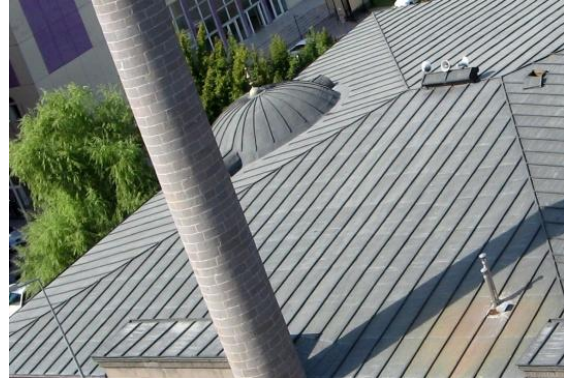
Şekil 23: Çatı, üstten görünüm, Ağustos 2010
