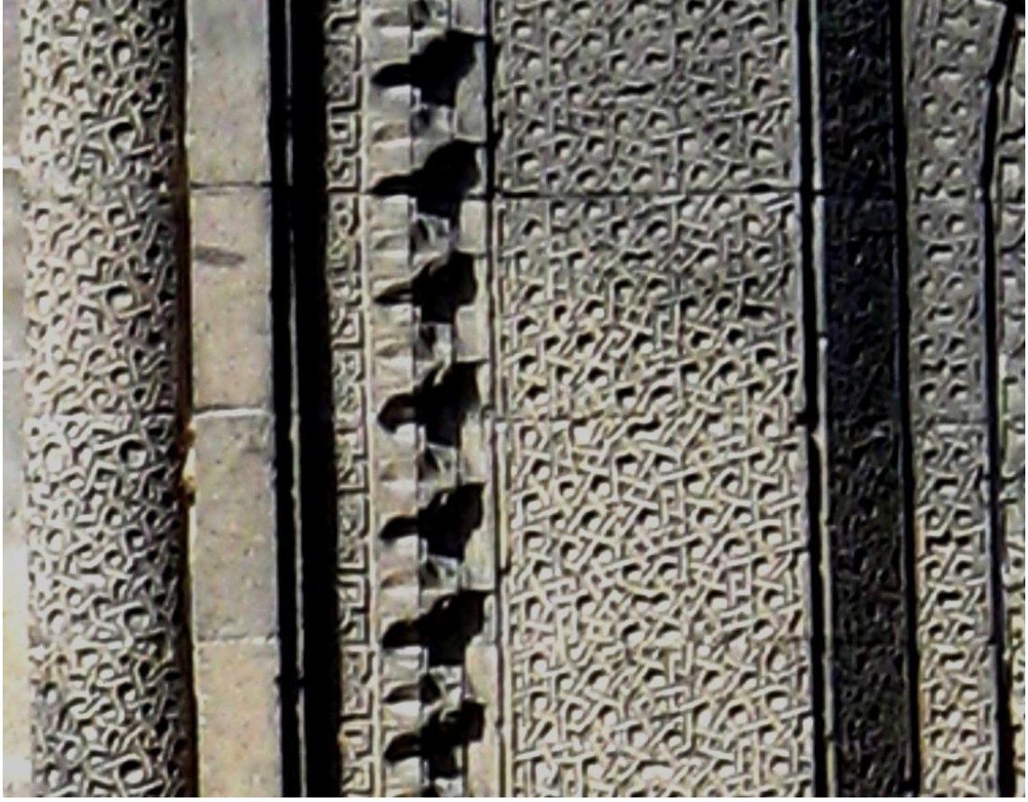
Şekil 133: Medrese taçkapısı, güney cephe, ayrıntı
