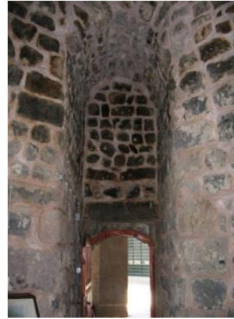
Şekil 98: Medrese, kuzeydoğu ve batı odaları, giriş koridoru
