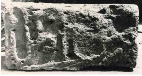
Şekil 19: Cami güney cephe, mihrap payandası üzerindeki kitabe parçası 3, onarımdan önce (V. G. M. Arş.)
