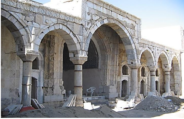
Şekil 181: Sivas Gök Medrese, avlu revak, devşirme sütun (Ağustos, 2010)
