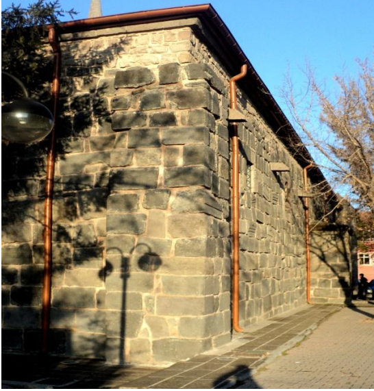
Şekil 46: Cami, güneybatı köşede yer alan kare kesitli payanda
