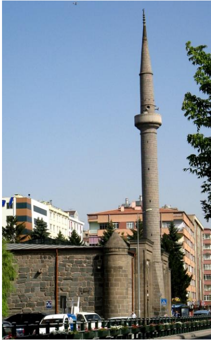
Şekil 37: Cami, güney cephe, güneydoğu köşe kulesi ve minare, Ağustos 2010
