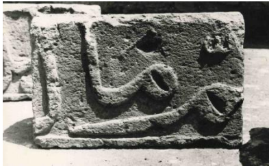
Şekil 17: Cami güney cephe, mihrap payandası üzerindeki kitabe parçası 1, onarımdan önce (V. G. M. Arş.)
