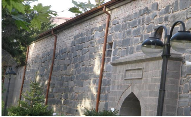
Şekil 51: Cami ve medrese batı cephe, ayrıntı
