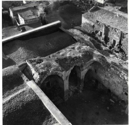
Şekil 84: Medrese, kuzey batı köşe, üstten görünüm, onarımdan önce (V. G. M. Arş.)
