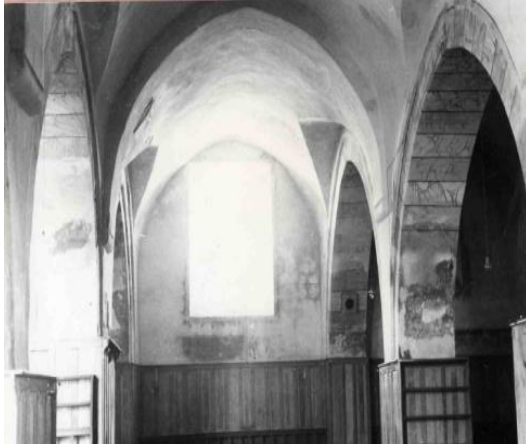
Şekil 70: Cami, harim, güney duvardaki mazgal pencere, kuzeyden bakış (V. G. M. Arş.)
