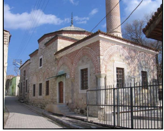
Şekil 6.14 Kapan (Hacı Turan) Camii
