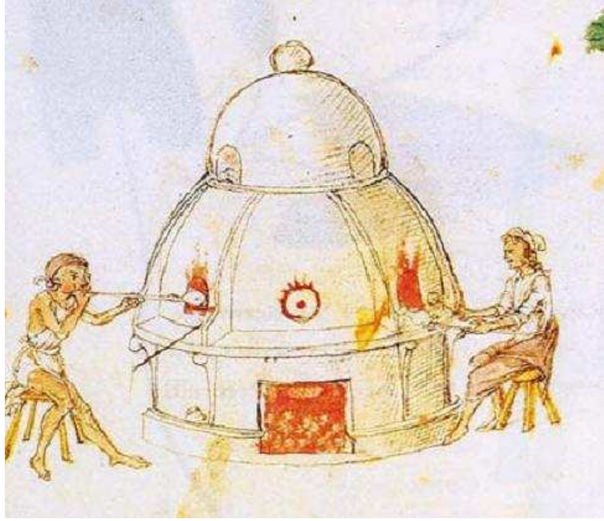
Çizim 15: Vatikan Müzesindeki M. Ö. XV. Yüzyıl Sonlarındaki Cam Fırını Tipini Gösteren Bir Çizim (Charleston'dan)
