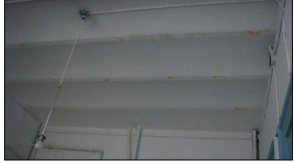
Resim 3.58. Volta döşeme
