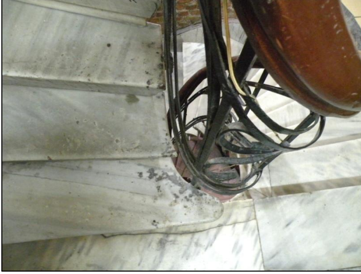
Resim 3.81. Kat sahanlıklarındaki başlangıç basamaklarının küpeşte eğimine uydurulmasına örnek (1. kattan)
