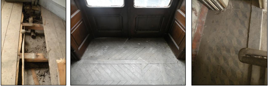
Resim 3.24. Döşemeler; sol: koridor ve oda döşemelerinin yapım tekniği; orta: salondaki masif ahşap balıksırtı döşeme; sağ: servis koridoru karo döşemesi
