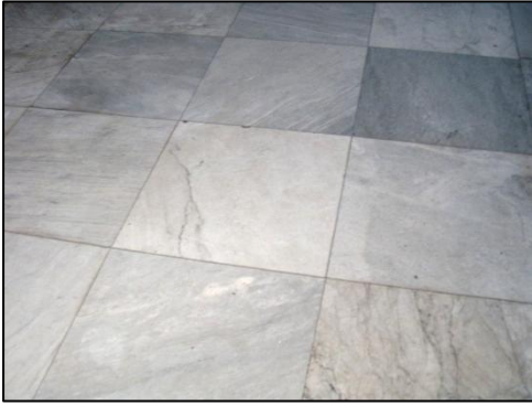
Resim 3.56. Giriş holü ve kat döşemeleri
