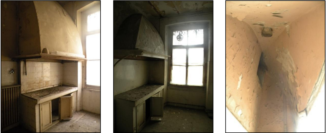
Resim 3.32. Mutfaktan görünüm ve baca içi detayı (ilk resim 2.kattan diğer resimler 5.kattan çekilmiştir)
