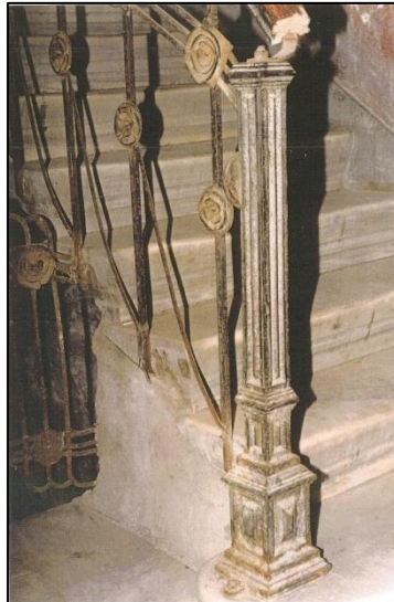
Resim 3.85. Vernudakis Apartmanı merdiven holü ve döşemedeki mermer kaplama
