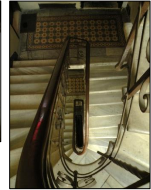
Resim 3.74. Merdivenden detaylar; sahanlıklar, basamak kenarları ve merdiven evi-kat sahanlıkları birleşimi
