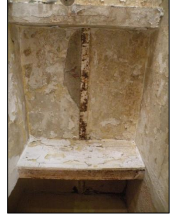
Resim 3.27. Muhtelif yerlerdeki açıklıklardan döşemelerin volta tekniği görülmektedir.
