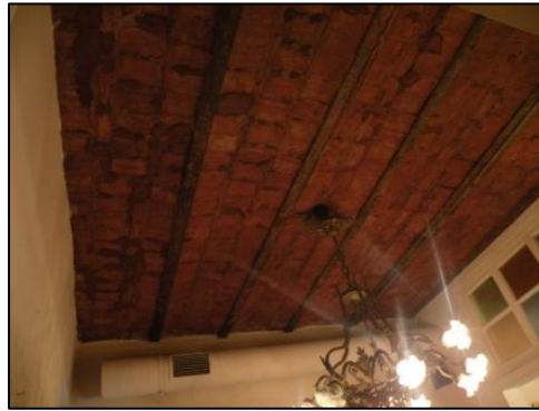
Resim 3.43. Koridor (1.kat) ve arka odadan (giriş kat) görülebilen volta döşeme.
