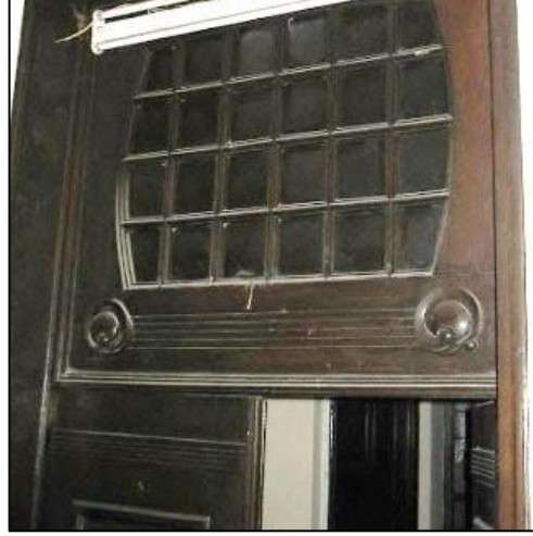
Resim 3.22. 1.kat daire kapısı ve kapıdan detay
