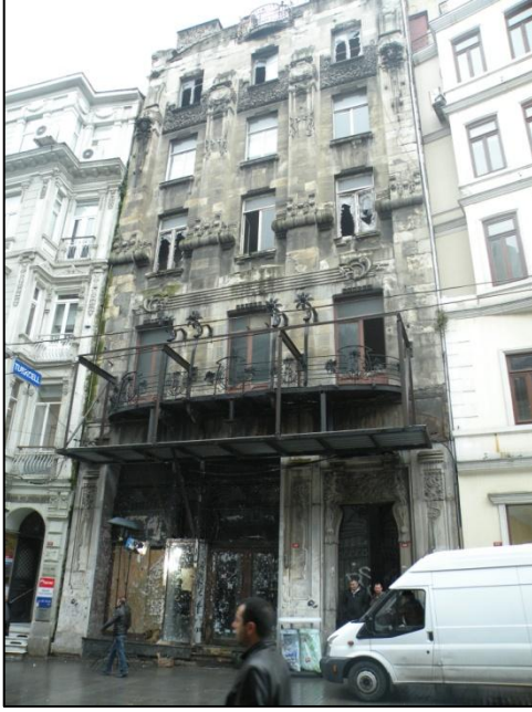
Resim 3.1. Botter Apartmanı Cephesi
