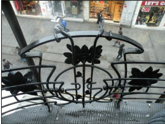
Resim 3.4. Birinci kat balkon demir işçiliği
