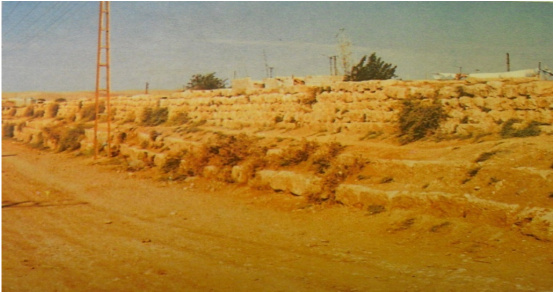
Şekil 3.91. Jüstinyen Su Bendi Eski Görünümleri
