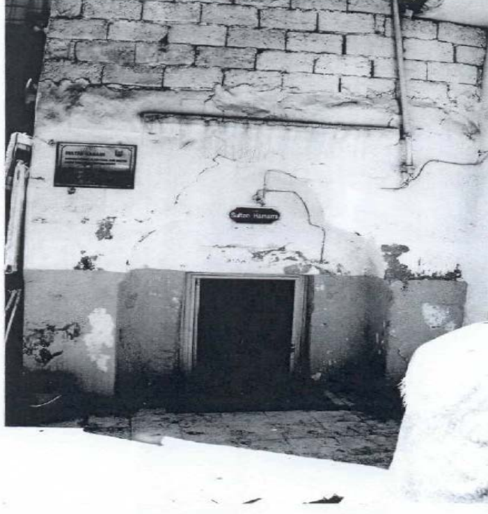
Şekil 3.45. Sultan Hamamı Girişi
