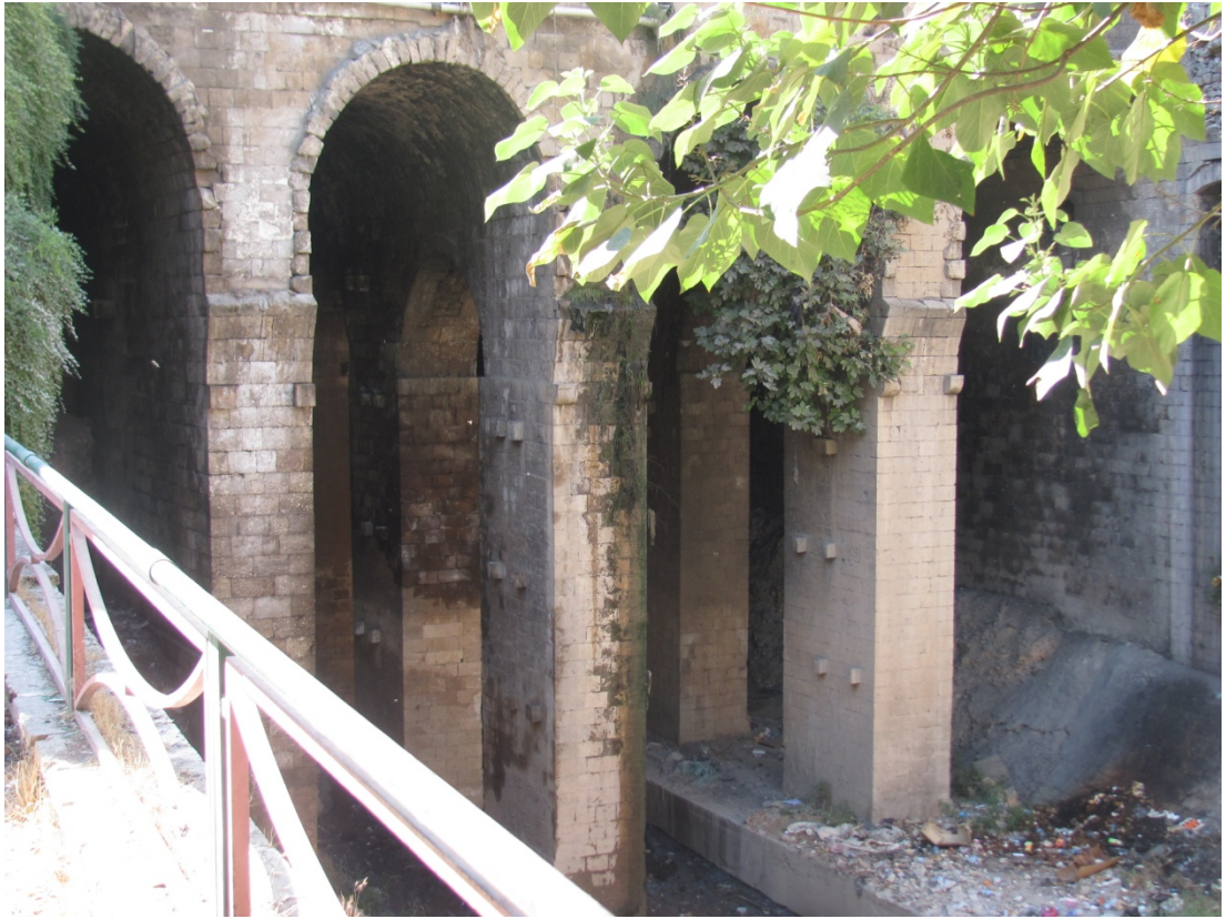
Şekil 3.79. Hacı Kamil Köprüsü İç Görünüm ve Kemer Detay Görünümleri
