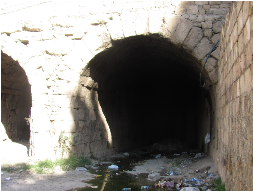
Şekil 3.75. Samsat Köprüsü İç Detay Görünümleri
