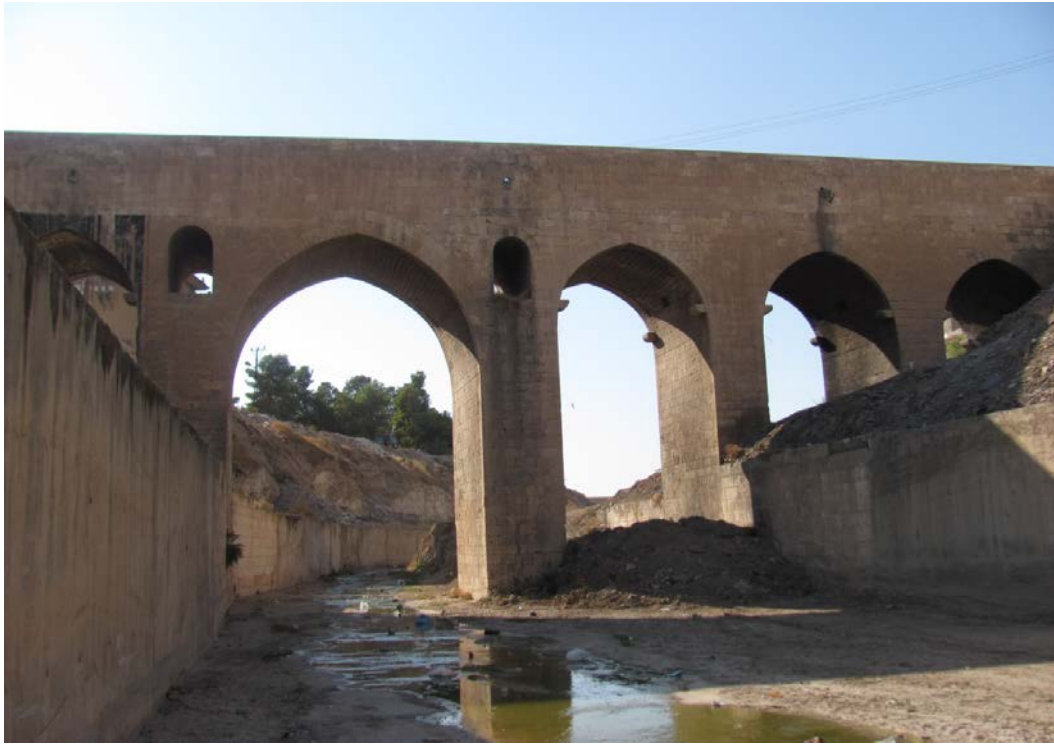
Şekil 3.68. Millet Köprüsü Arka Cephe Görünümü
