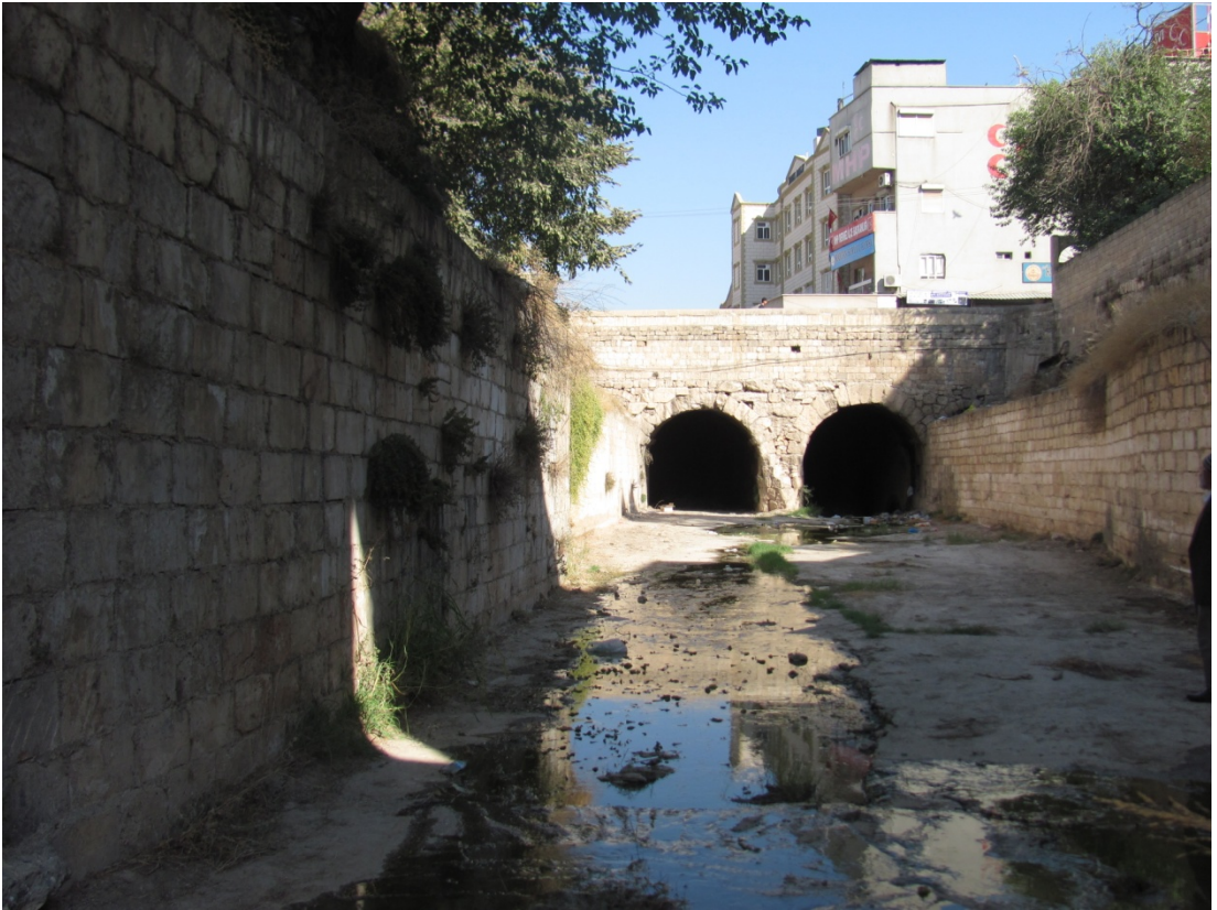
Şekil 3.74. Samsat Köprüsü Yeni Görünümleri
