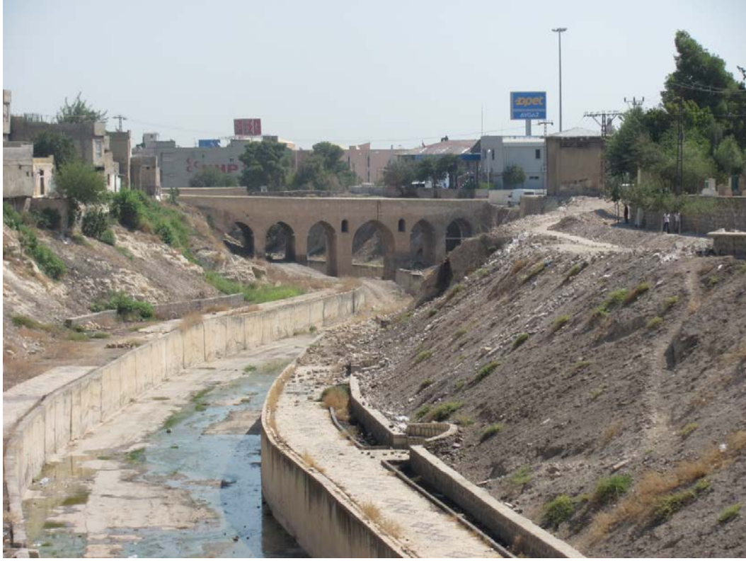
Şekil 3.67. Millet Köprüsü Ön Cephe Görünümü
