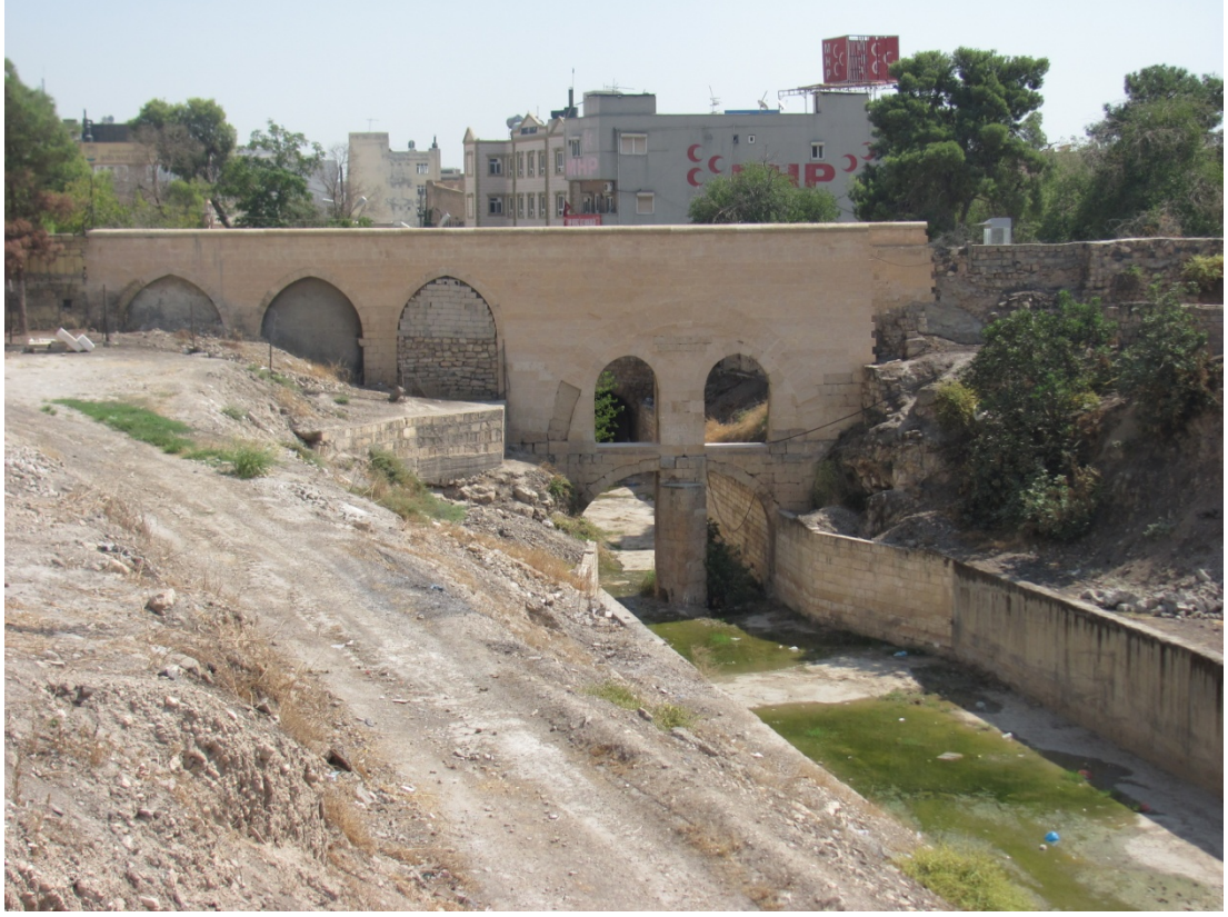
Şekil 3.84. Karakoyun Su Kemerı Ön Cephe Görünümü
