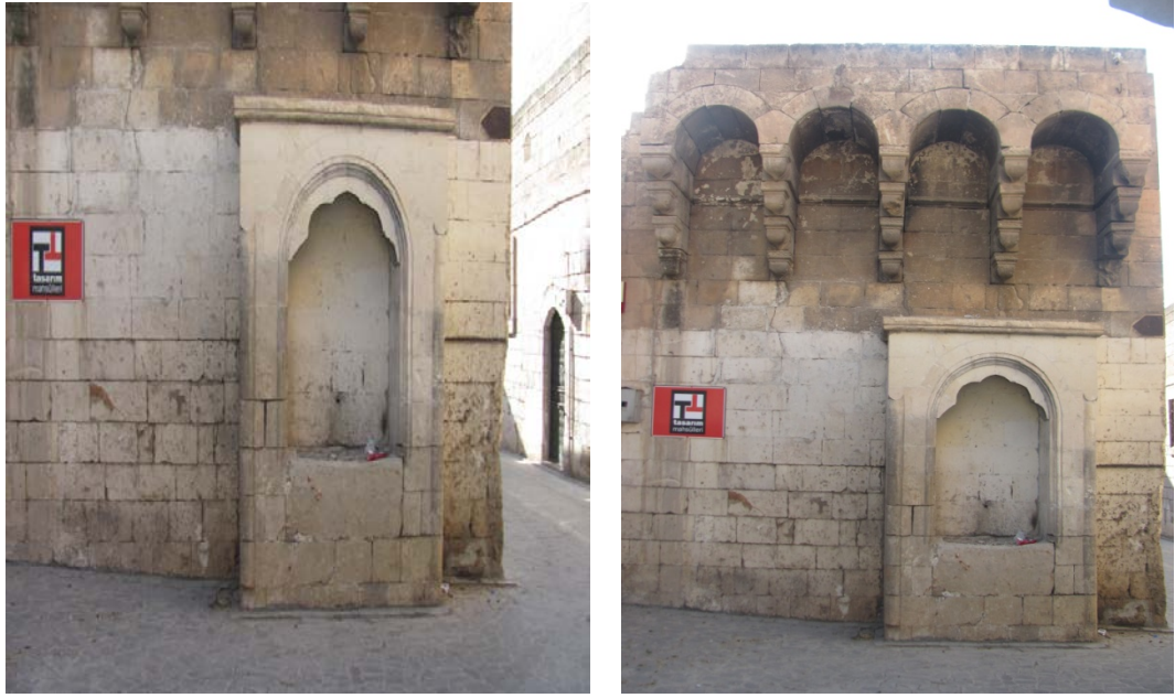
Şekil 3.37. Ebeler Sokak Çeşmesi Yeni Görünümleri
