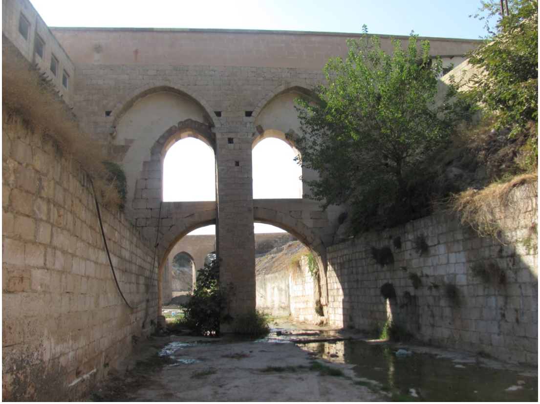
Şekil 3.85. Karakoyun Su Kemerinin Arka Cephe Görünümü
