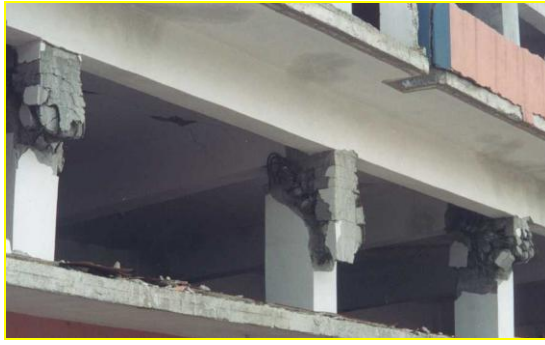
Şekil 5.5 Yapılar Üzerinde Kısa Kolon Oluşumu
