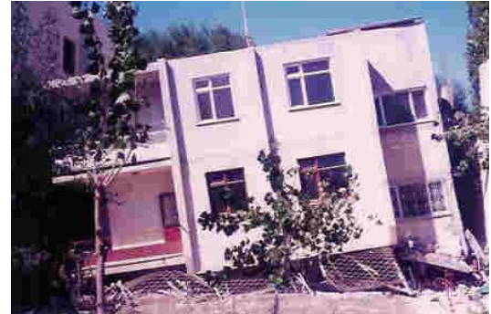
Şekil 5.6 Yapılar Üzerinde Yumuşak Kat Oluşumu
