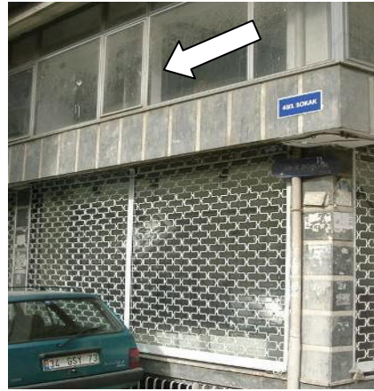
Şekil 5.4 Kolon Eksiltilmesi
