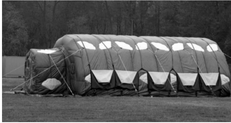
Şekil 8.3. Yarı Silindir Şekli Şişirilebilir Yapı Örneği (Seedhouse 2009)
