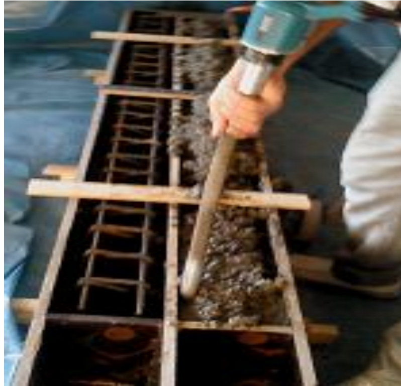
Şekil 4. 5. Betonarme kirişlerde betonun sıkıştırılması
