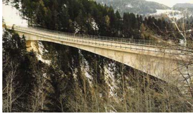
Şekil 1. 7. Sinigo ve Avelengo şehirleri arasında inşa edilen köprü, İtalya (El Zareef, 2010).
