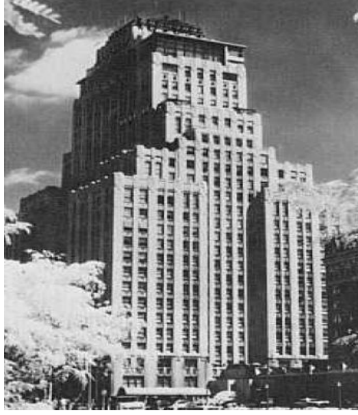
Şekil 1. 2. Hafif beton ile üretilen bir bina Park Plaza Otel, St. Louis (Anonymous, 1971).
