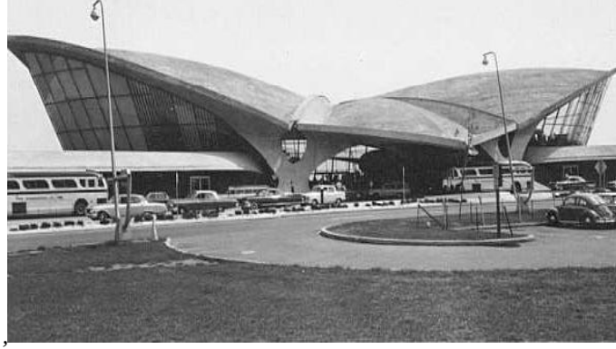
Şekil 1. 6. TWA Terminal, 1960, John F. Kennedy International Airport, Amerika Birleşik Devletleri (Clarke, 1993).
