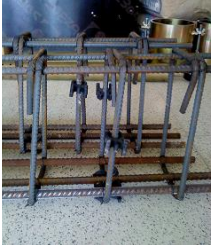
Şekil 4. 2. Betonarme kirişlerin donatı kafesi
