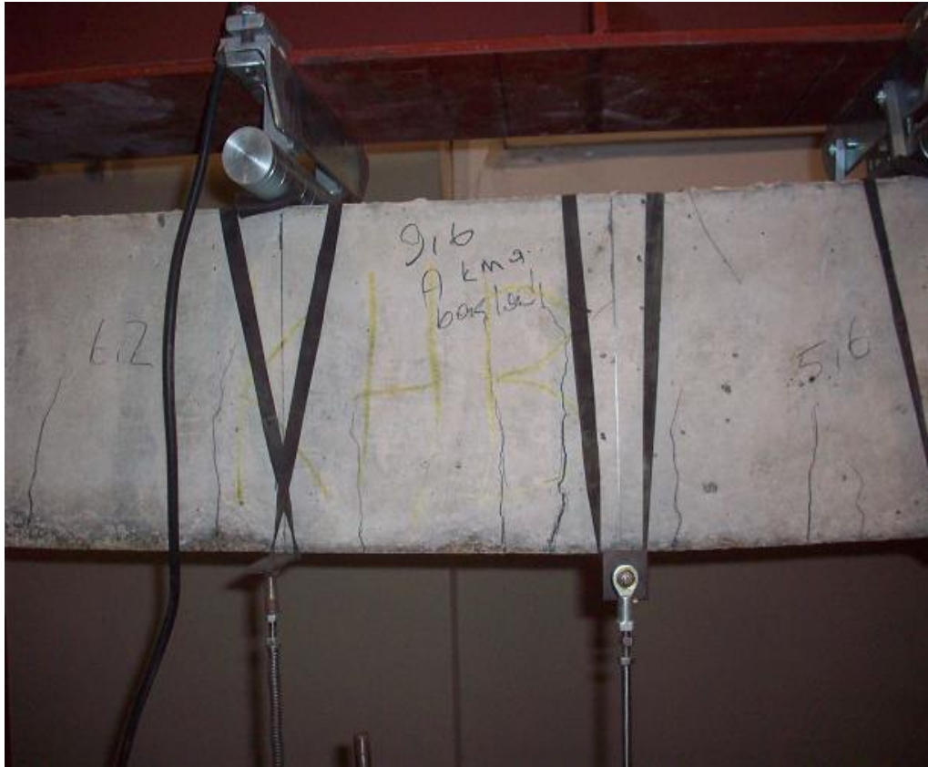
Şekil 5. 13. HB serisi betonarme kirişlerin ilk çatlak yükleri
