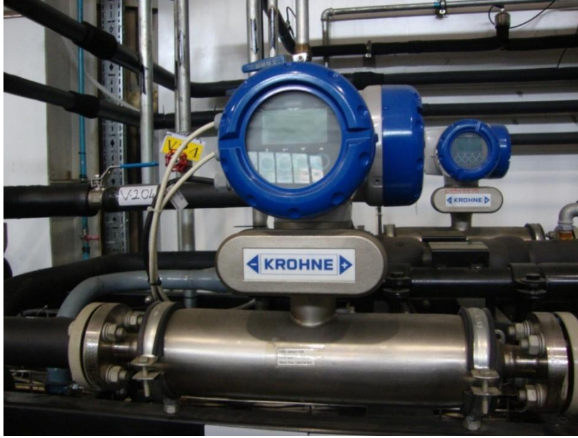
Şekil 5.10 : R744 için debimetre.
