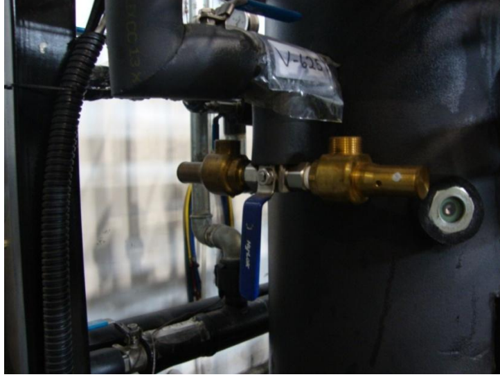
Şekil 5.13 : Likit tankı güvenlik valfi
