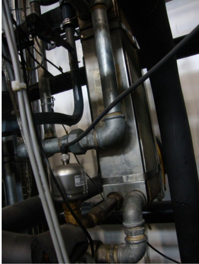
Şekil 5.12 : Su ısıtmalı evaporatör.
