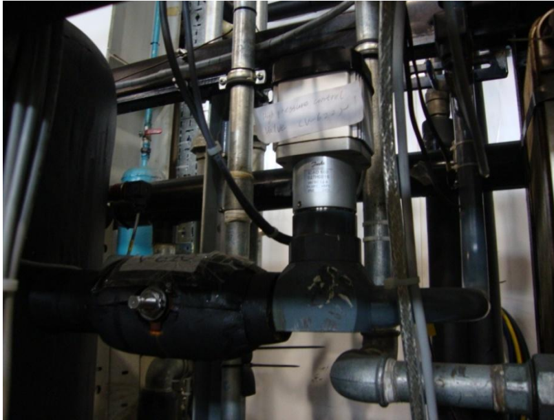
Şekil 5.7 : ICMTS yüksek basınç valfi.
