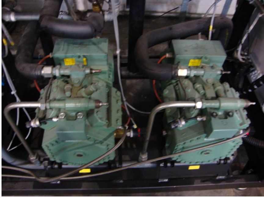
Şekil 5.8 : BITZER transkritik kompresörler.
