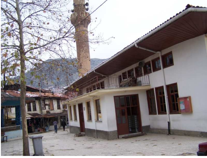
Resim 4.3. Ulu Cami kuzey cephesi ( Seda İnici Arşivi)
