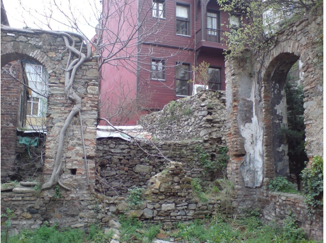
Foto. B.38. Güneybatı Duvarı- İç Mekan
