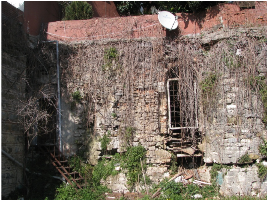
Resim 2.5. 16 ve 17 Parsel Altındaki Tonoz Odalarının Girişleri (Ünal, N., 2011)
