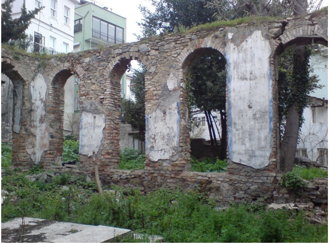
Foto. B.43. Kuzeydoğu Duvarı- İç Mekan
