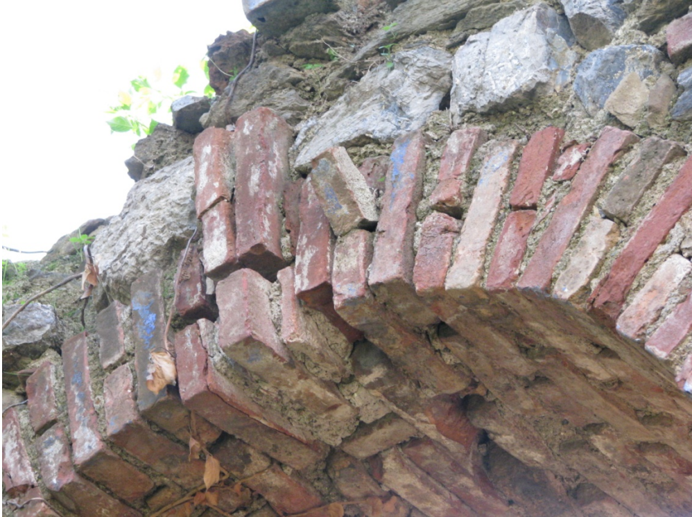
Foto. B.52. Kuzeydoğu Cephesi- Pencere Kemerı Detayı
