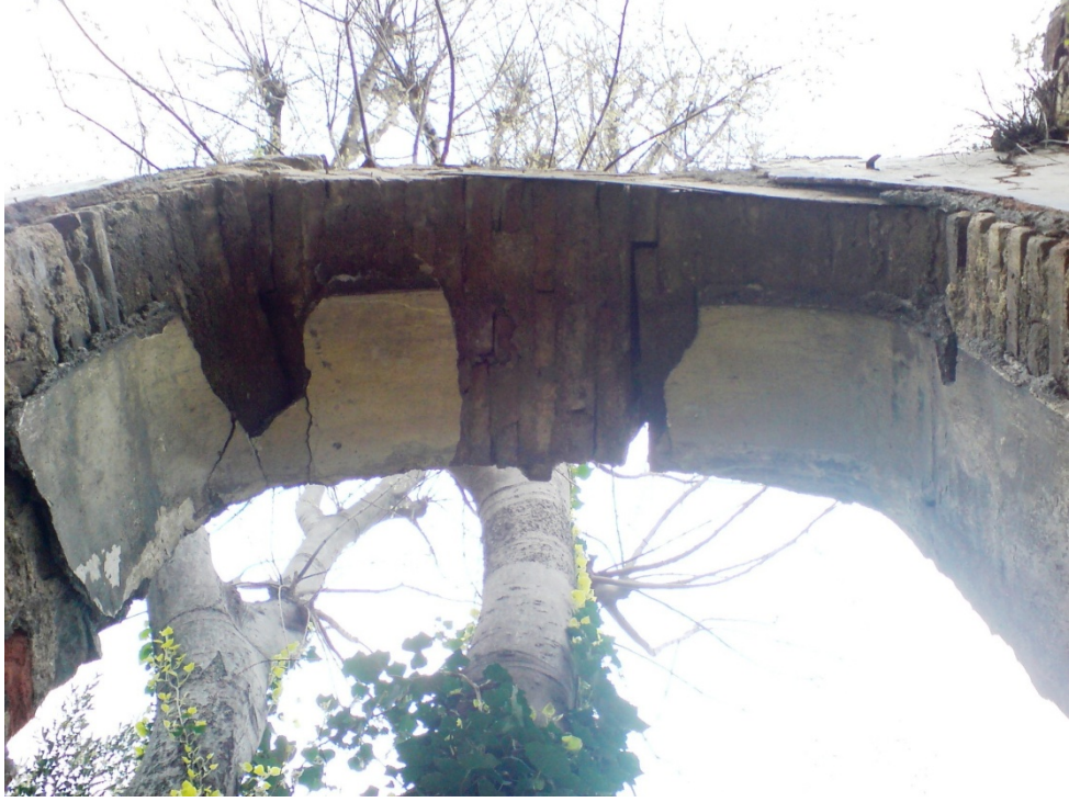
Foto. B.53. Kuzeydoğu Cephesi- Pencere Kemerı Detayı
