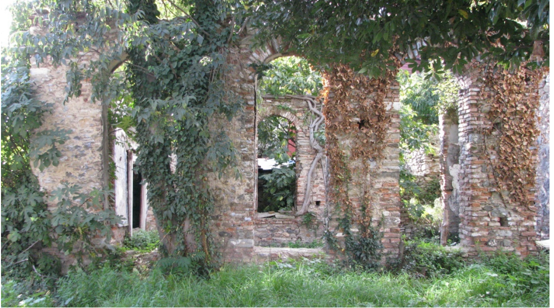
Foto. B.32. Kuzeydoğu Cephesi
