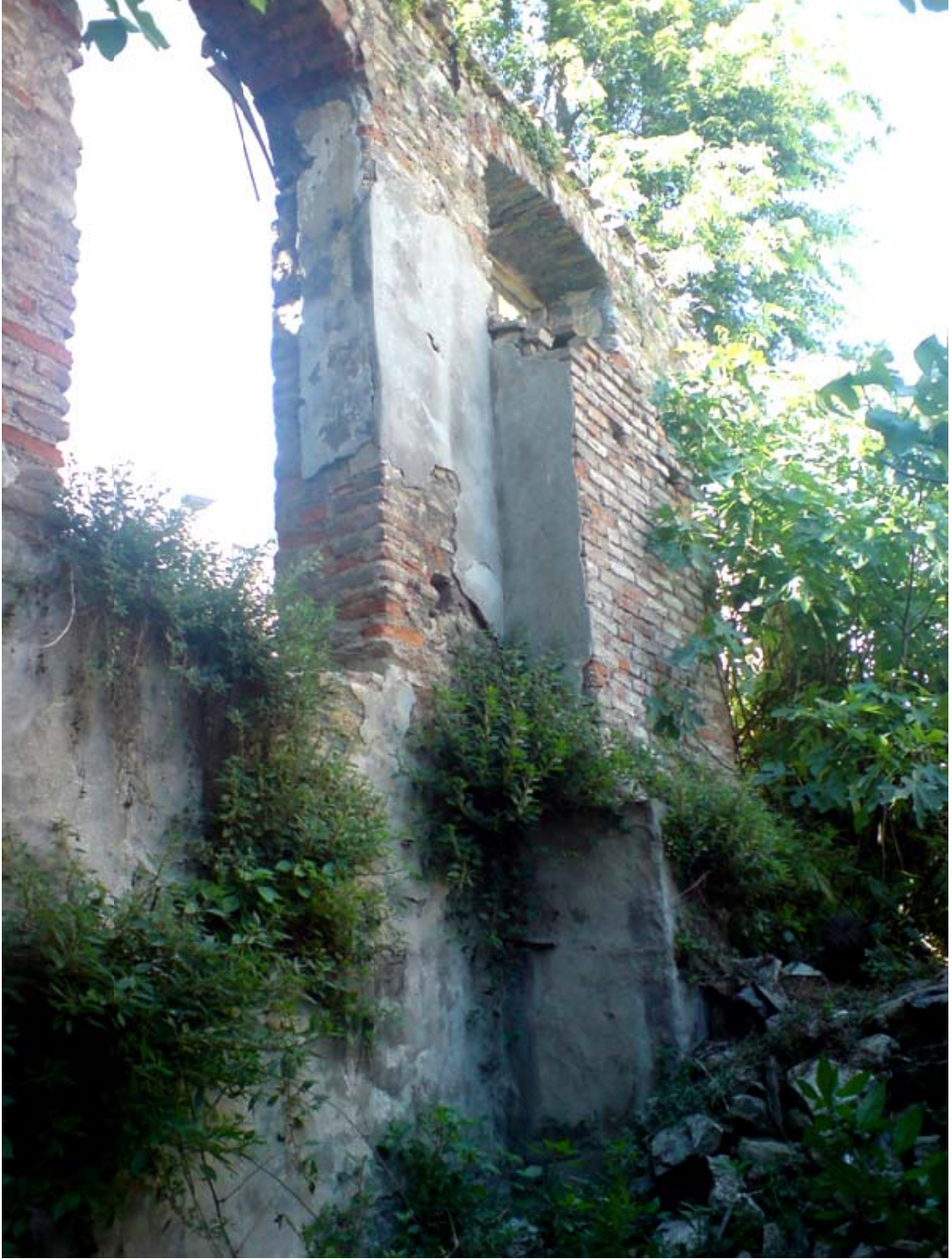
Foto. B.36. Güneydoğu Cephesi
