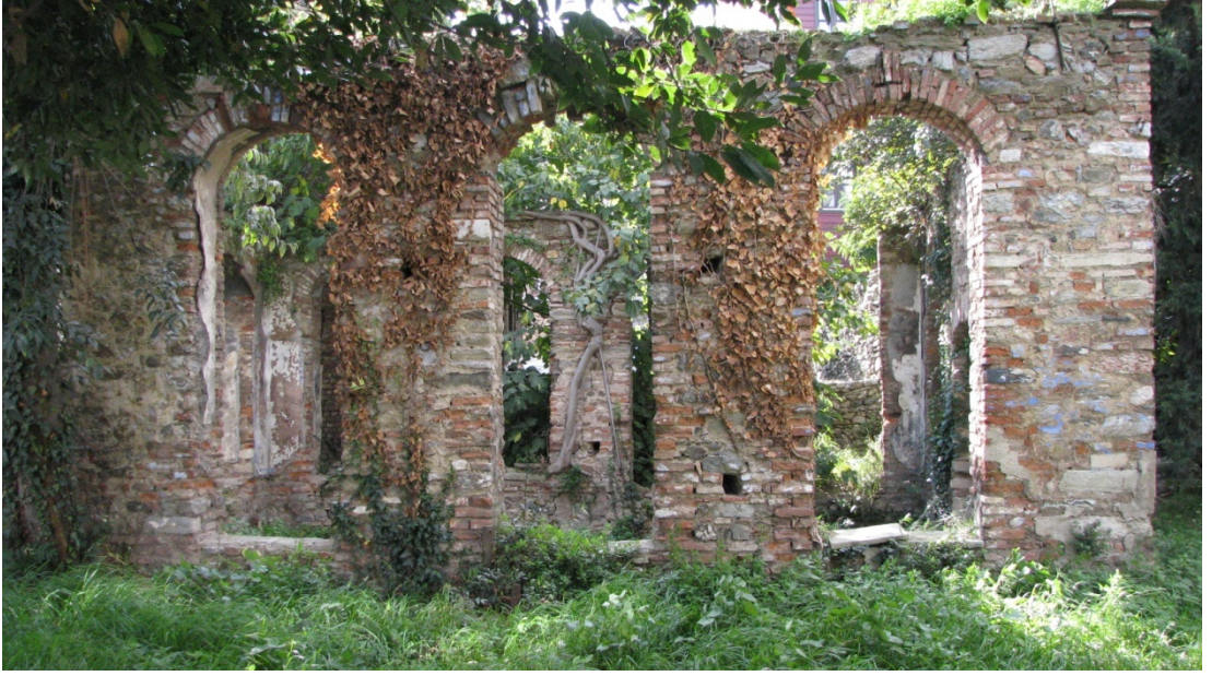
Foto. B.31. Kuzeydoğu Cephesi
