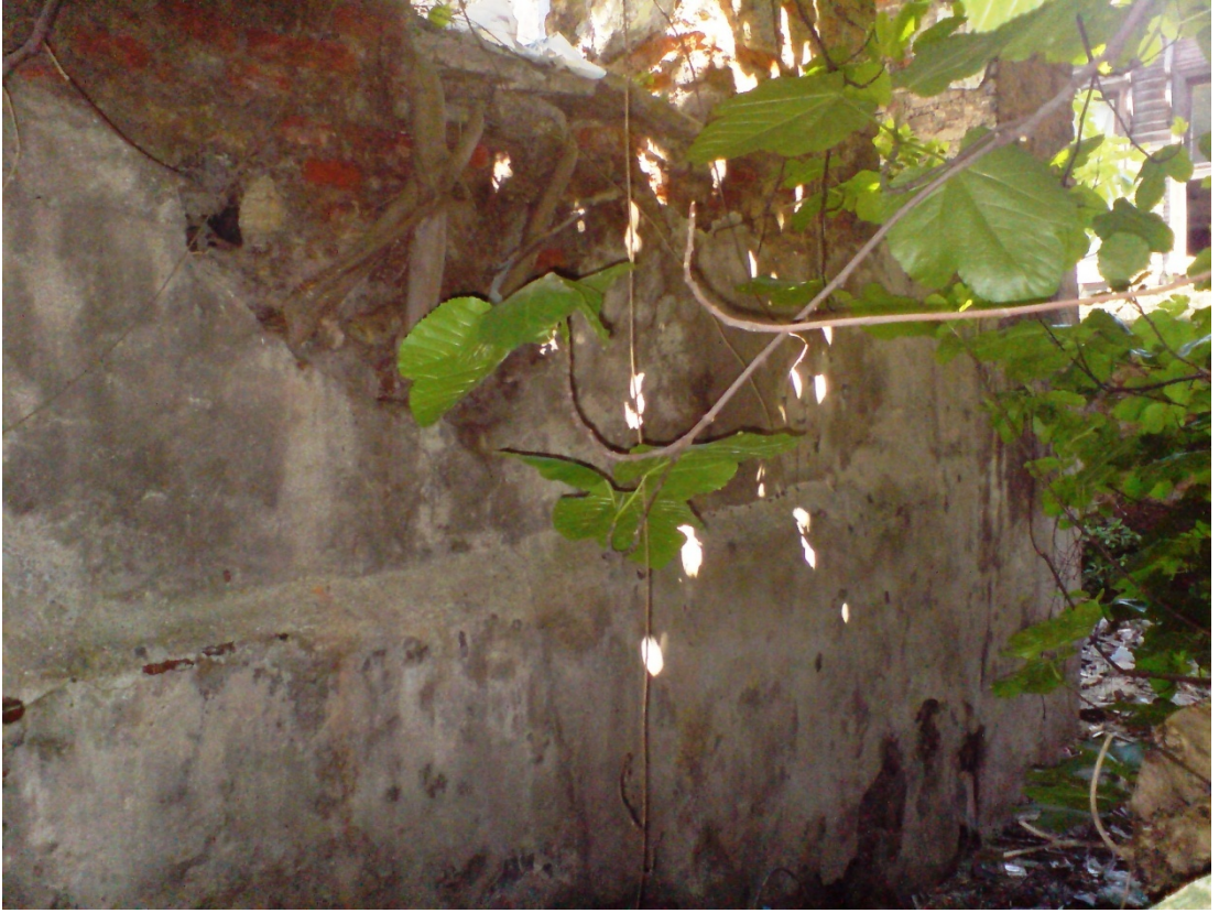
Foto. B.35. Güneybatı Cephesi
