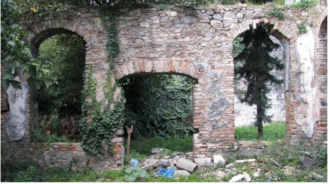
Foto. B.45. Kuzeybatı Duvarı- İç Mekan
