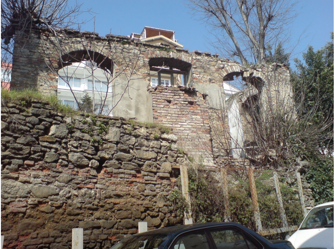
Foto. B.12. Güneydoğu Cephesi
