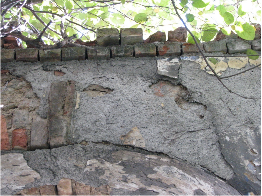
Foto. B.27. Kuzeybatı Cephesi- Detay
