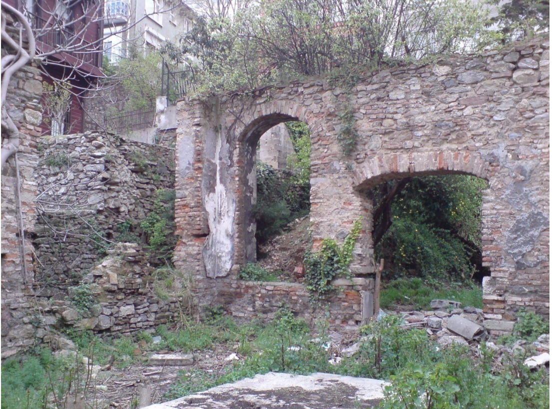
Foto. B.46. Kuzeybatı Duvarı- İç Mekan
