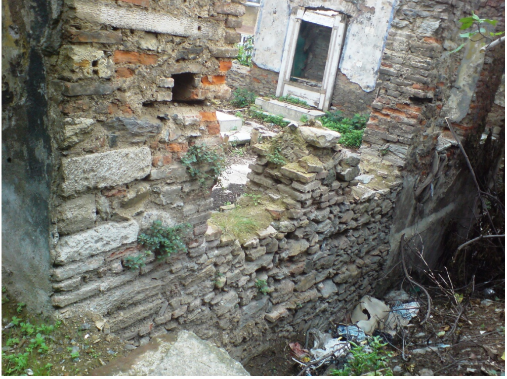
Foto. B.49. Önceleri Azara'nın Yash Olduğu Sinagog Duvarı
