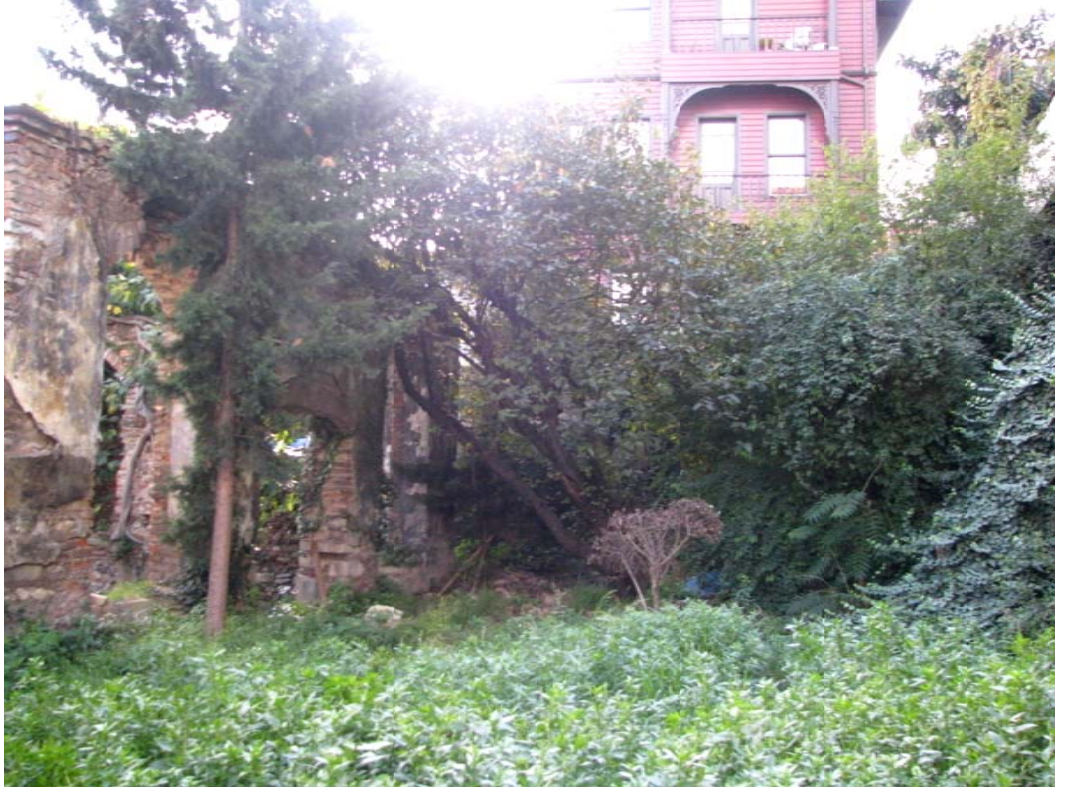
Foto. B.18. Avlu- Sinagog Giriş Cephesine Bakış
