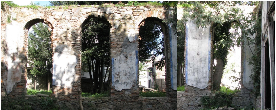
Foto. B.44. Kuzeydoğu Duvarı- İç Mekan
