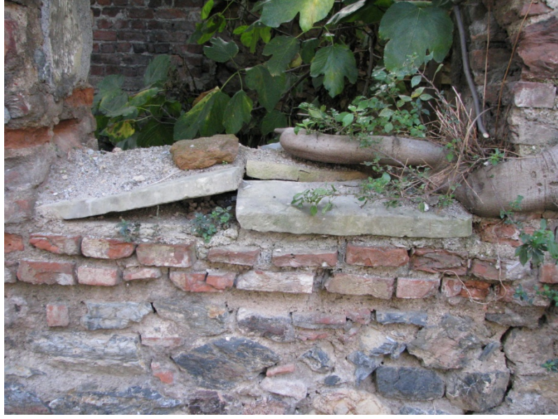
Foto. B.55. Kuzeydoğu Duvarı-İç Mekan, Denizlik Detayı
