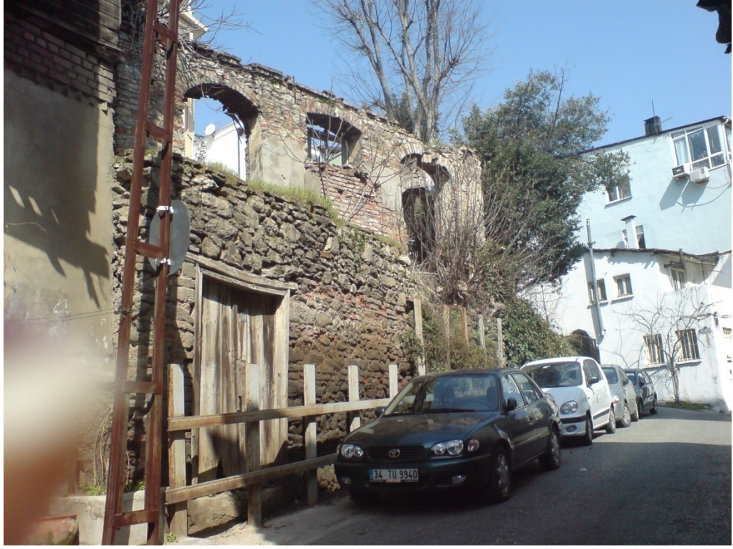
Foto. B.11. Teyyareci Suphi Sokak'tan Giriş- Güneydoğu Cephesi
