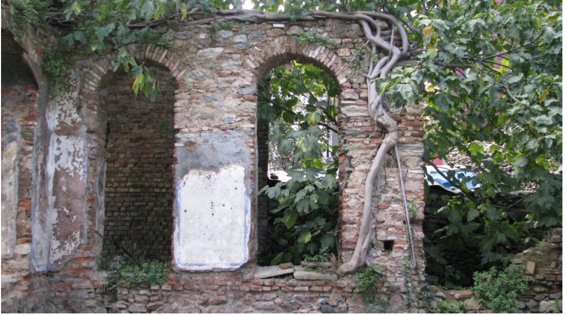
Foto. B.37. Güneybatı Duvarı- İç Mekan
