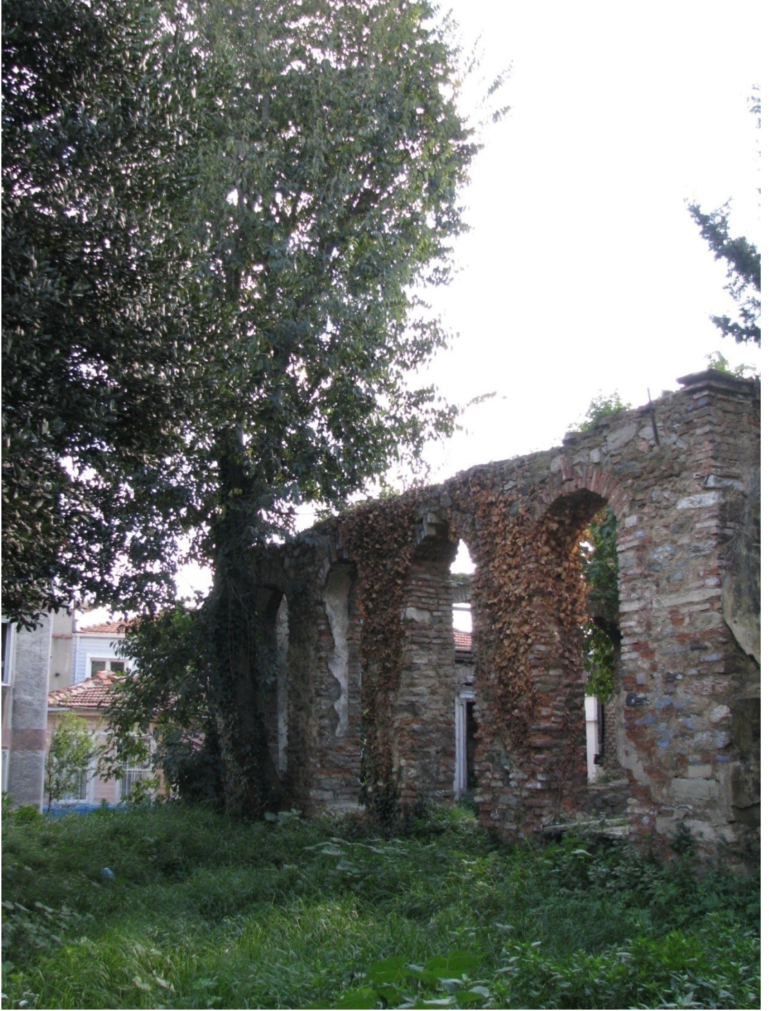
Foto. B.30. Kuzeydoğu Cephesi
