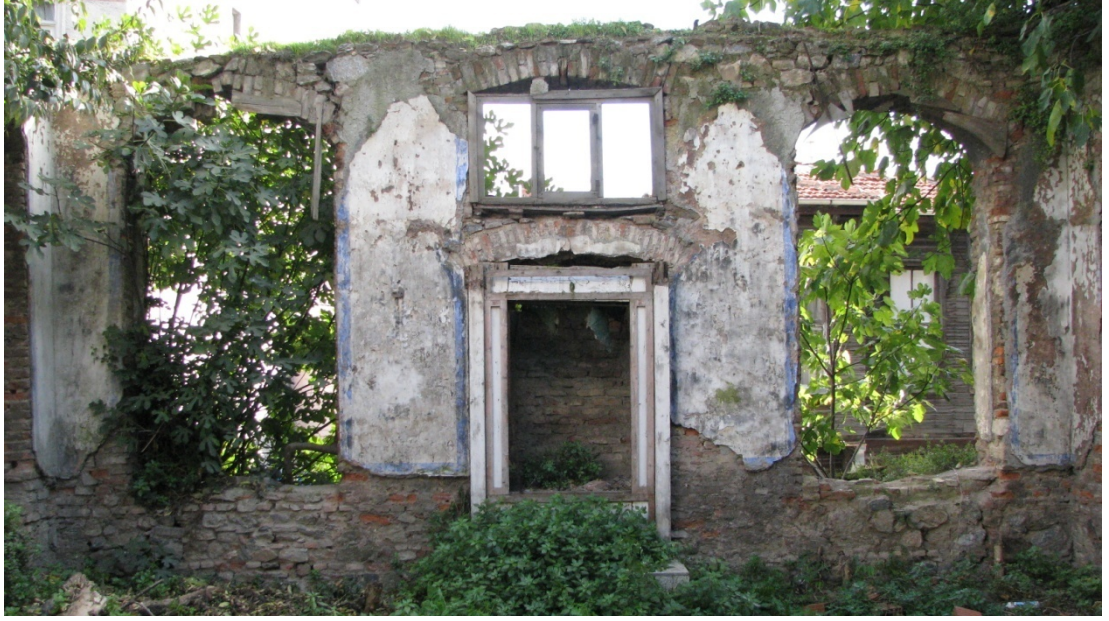
Foto. B.39. Güneydoğu Duvarı (Heikal)- İç Mekan
