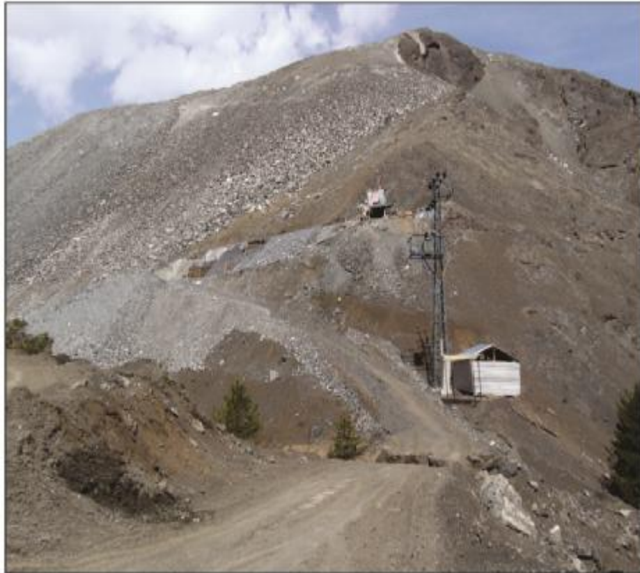
Őekil 4.21. Karaburun Tepe Ocađı Aık İŐletme ve Düz Galeri
