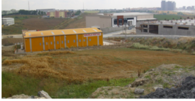
Şekil 4.19: Kayan fabrika binası
