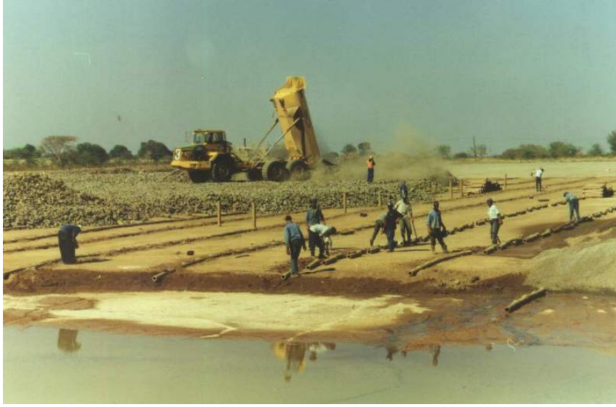
Şekil 2.3. Sulama yöntemiyle yapılan yığın liçi çalışmalarından bir görüntü.
