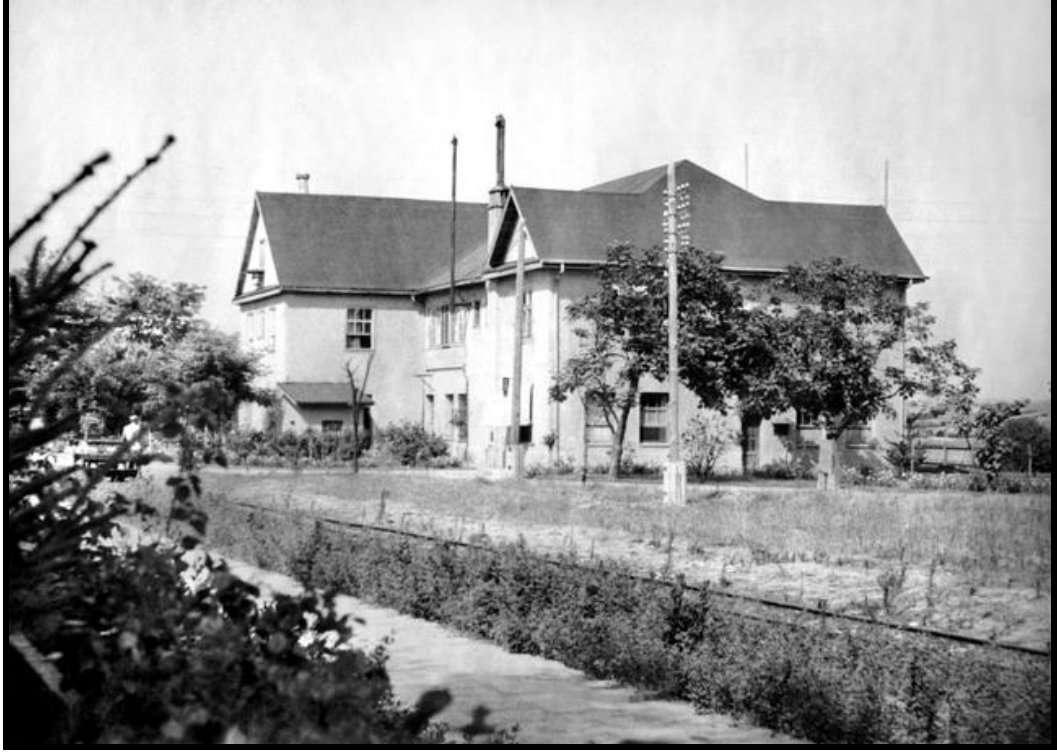
Foto 37. Avrupa mimari tarzına göre inşa edilmiş fabrika alanı içinde bulunan Zingal Şirketi müdüriyet binası (Orman İşletme Arşivi).
