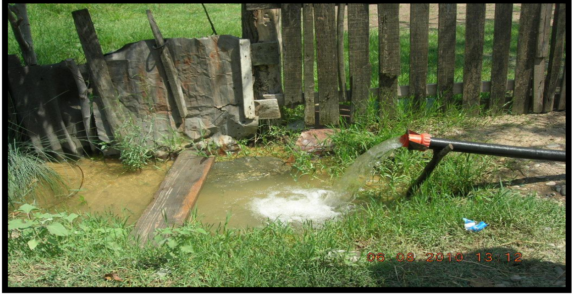
Foto 12. Bafra Ovası Yer Altı Sulama Şebekesinden Bir Görünüm
