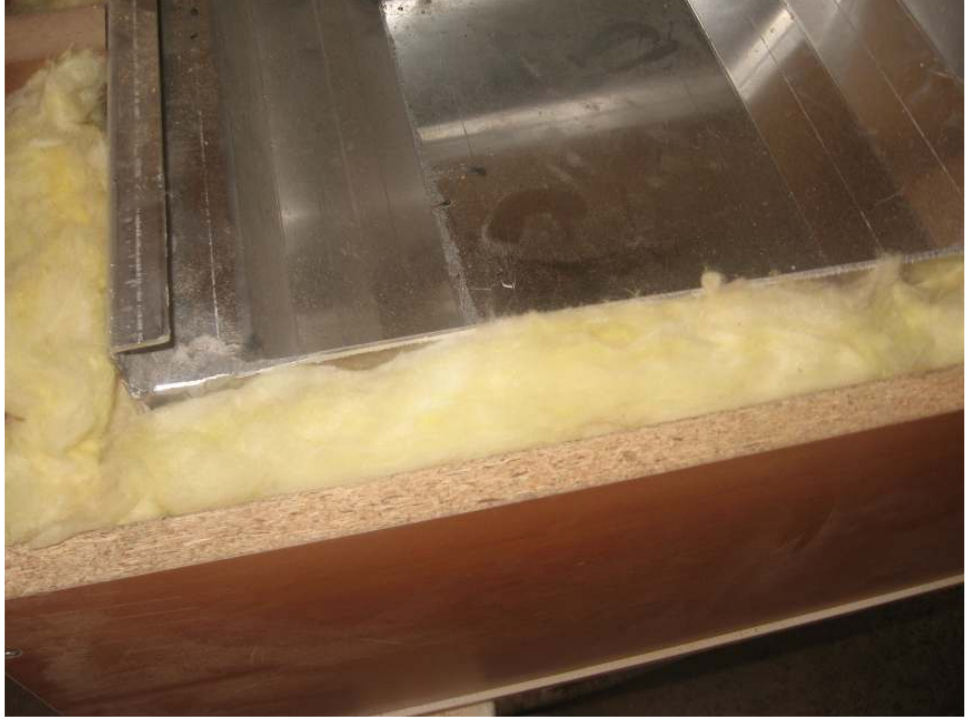
Şekil 34 Cam yün ile yalıtım işleminin yapılması
