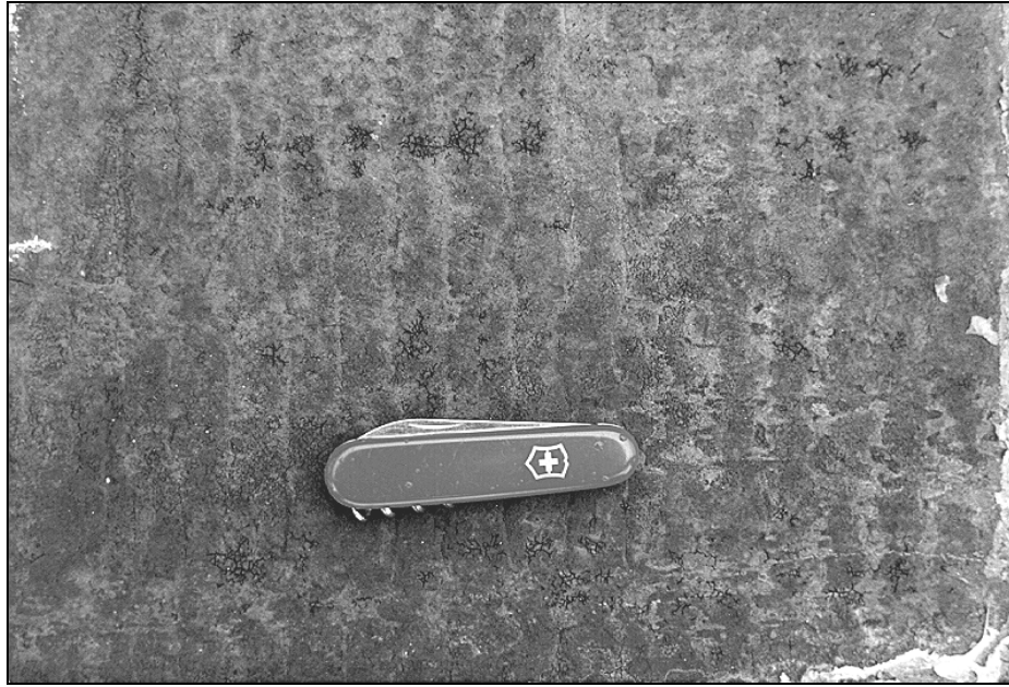
Şekil 6. 6: Slabta yıldız çatlaklı kusuru [ 22]
