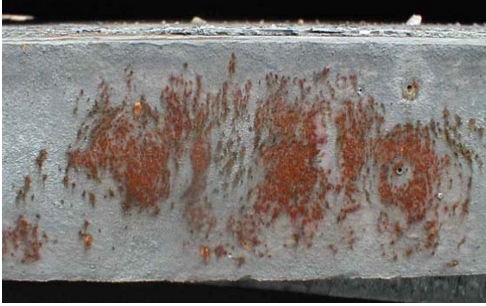
Şekil 6. 7: Slabta gaz boşluğu kusuru [ 22]
