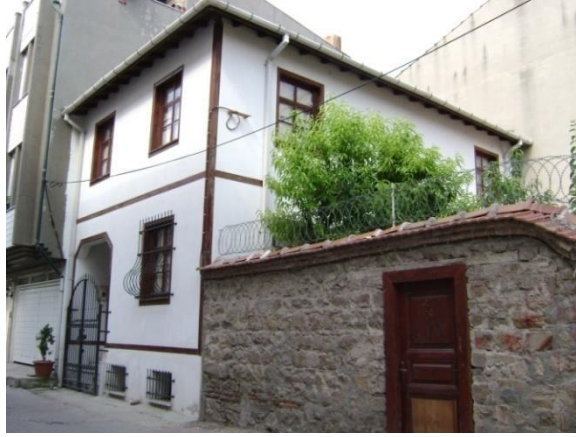
Şekil 5.4. Konut ve bahçenin sokaktan görünüşü
