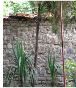
Tuğla örgülü duvar
