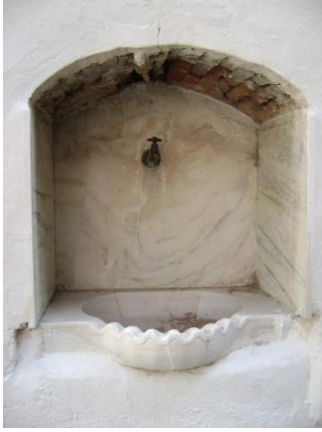
Şekil 5.25. Bahçe duvarındaki çeşme
