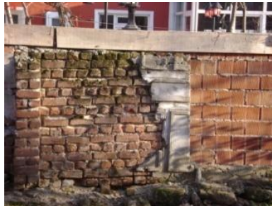
Şekil 5.49 Konutun bahçe duvarı
