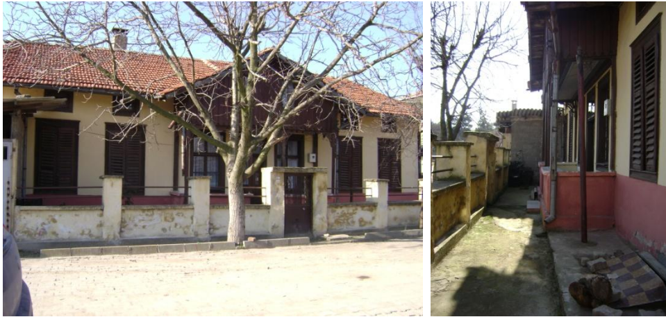
Şekil 5.70. Konutun ve ön bahçenin sokaktan görünümü
