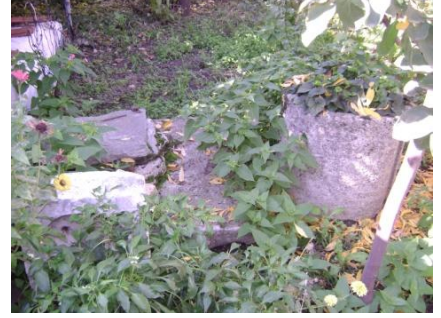
Şekil 5.91. Eskiden kalan kuyunun yeri ve kuyunun zemin üzerindeki kalan beton kısmı
