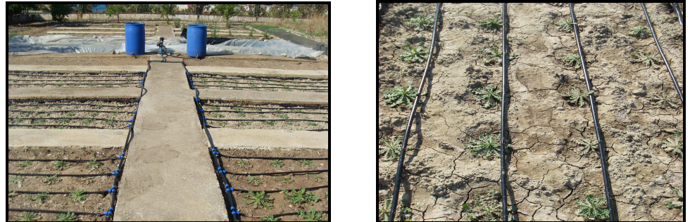
Şekil 3.10. Açık alan parsel denemesi sulama sistemi.
