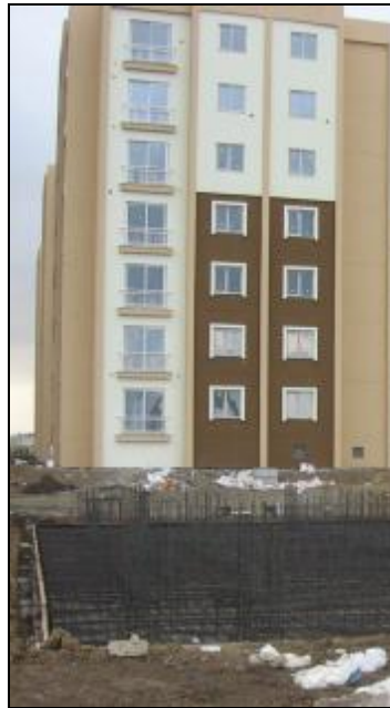
Şekil 4.10. Temeli atılmış ve tamamlanmış üst yapıya ait iki örnek
