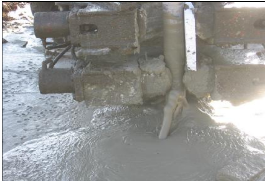
Şekil 4.9. Karışımın zemine enjekte edilmesi
