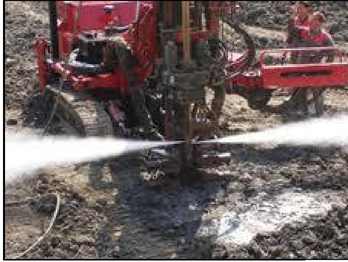
Şekil 1.3. Enjeksiyonun püskürme memelerinden çıkışı ( www.geodata.com.tr )
