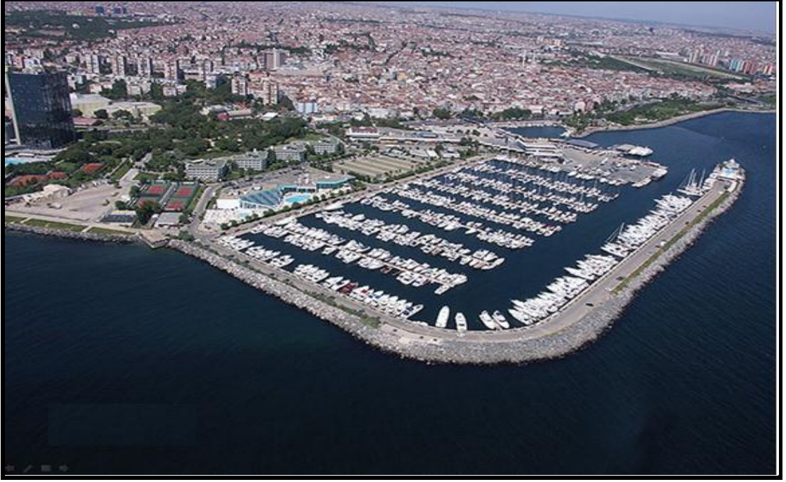
Şekil 2.3: Ataköy Marina görünümü (Altunay, 2009)
