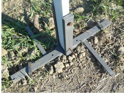
Şekil 3.18. Direklerin toprak üstünde dik olarak durmasını sağlayan ayakların görüntüsü.
