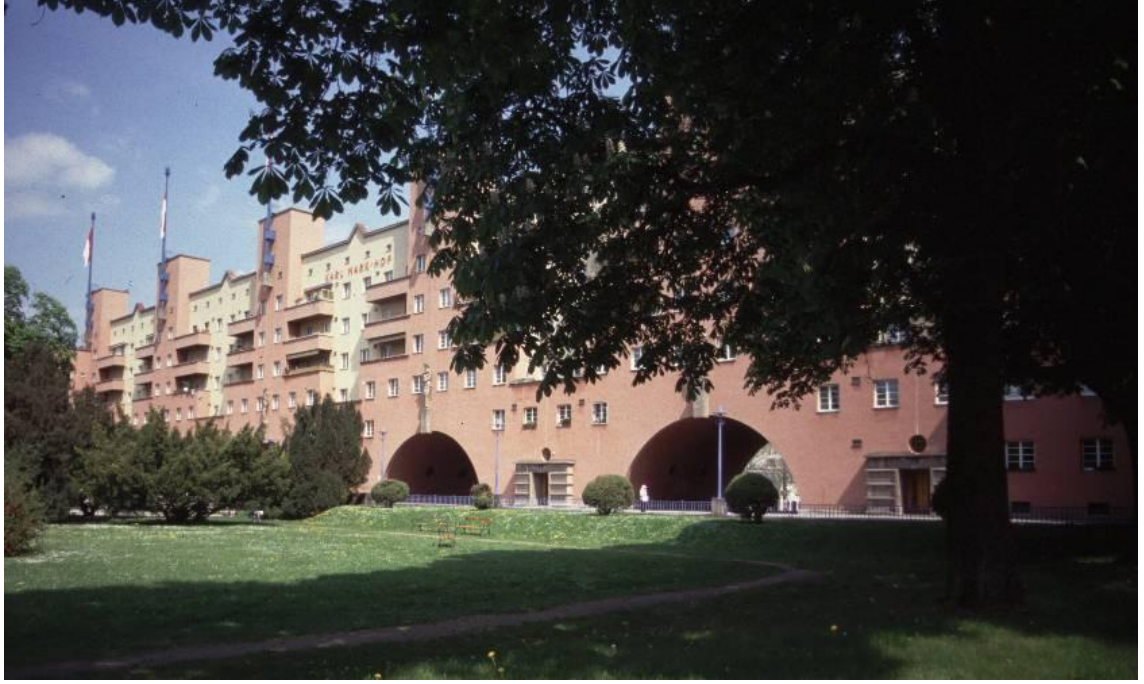
Resim 1.16 Viyana'da bulunan toplu konut örneği, Gemeindebau, 1920 ( http://en.wikipedia.org/wiki/Gemeindebau )
