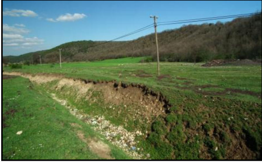
Foto 35. Lineer Erozyon Sahası (Kapanalan)
