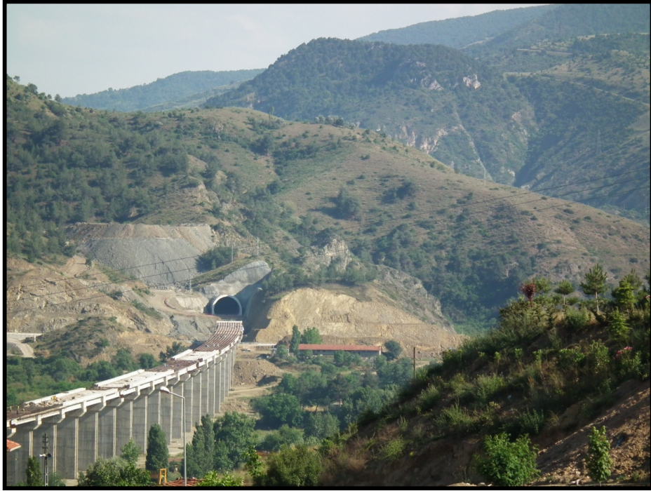
Foto 42. Karasu Çayı Yatağının Üzerinde Yapılan Yüksek Hızlı Tren Yolu (Küplü)
