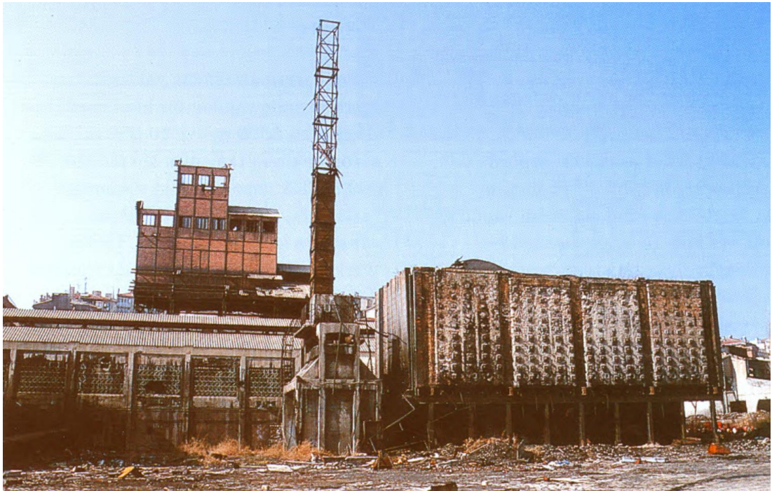
EK 3. Şekil 3. 20:Sağda Picard, solda eski yatık hazneli Hovine fırınlarını içeren yapı. Tanyeli, G. Ve Aslan, D. (2001), 'Kadıköy-Hasanpaşa Gazhanesi, Arredamento Mimarlık Sayı:2001/09, sayfa105-107.
