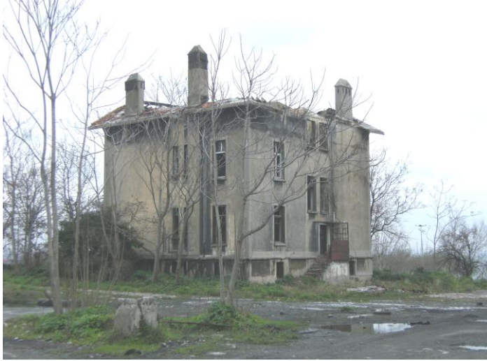
EK 4. Şekil 4. 26: Lojman binası arka cephesini gösteren fotoğraf. (Fot: Arzu Yoldemir, 2010)
