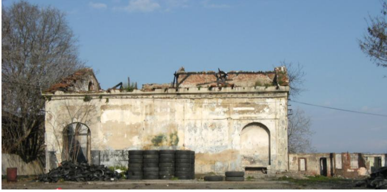
EK 4. Şekil 4. 29: Malzeme ambarı önden görünüşü. (Fot: Arzu Yoldemir, 2010)
