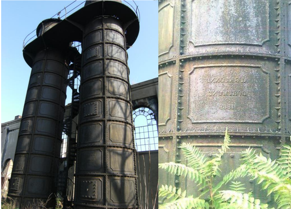
EK 4. Şekil 4. 20: Şekil İki bina arasında yer alan denetim kulesi fotoğrafı ve detay (Fot: Arzu Yoldemir, 2010)
