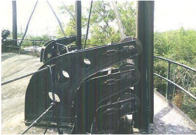
EK 4. Şekil 4. 8: Gazometrenin teleskopik sisteminden detay. (Anıtlar Kurulu Arşivi, fot: 2000)
