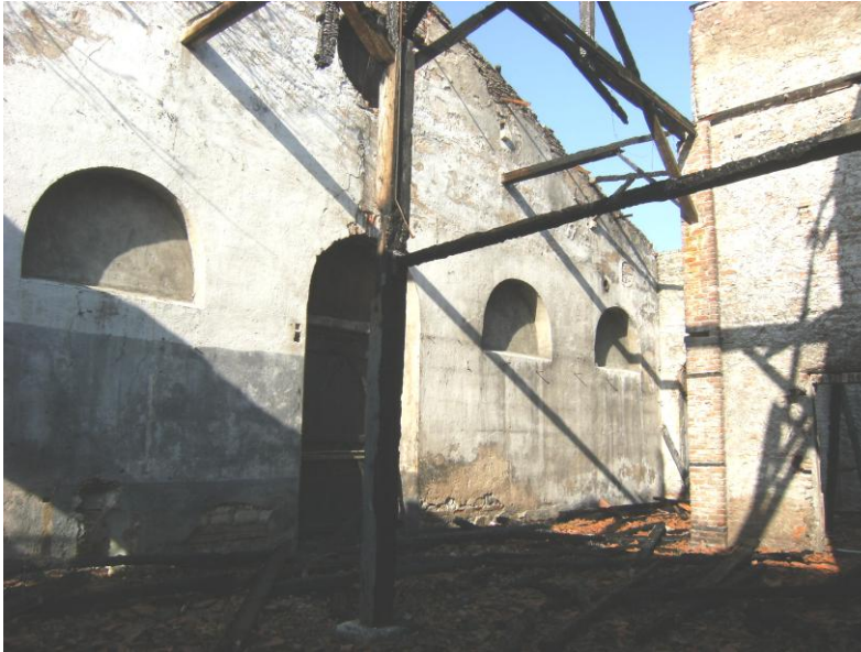
EK 4. Şekil 4. 30: Malzeme ambarı içinden fotoğraf. (Fot: Arzu Yoldemir, 2010)
