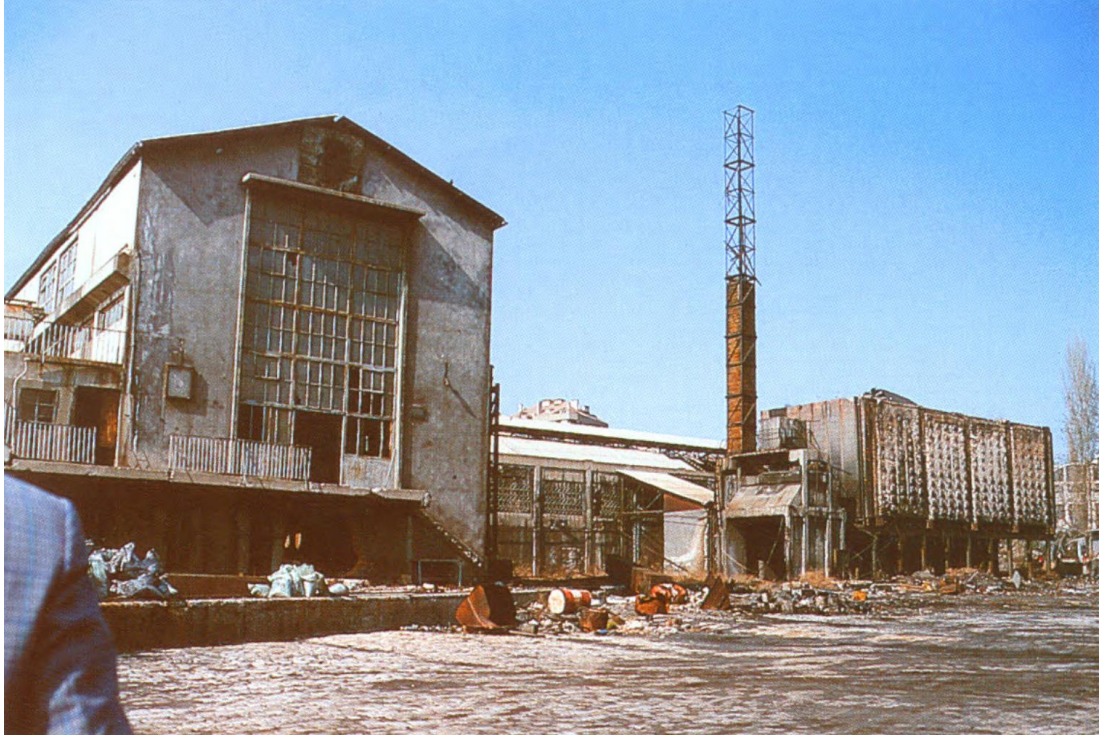
EK 3. Şekil 3. 19:Hasanpaşa Gazhanesi 1994'teki sökümünden sonra, sağda Picard düşey kamaralı fırını altyapısı. Solda Picard ile birlikte inşa edilmiş gaz temizleme tesisi. Tanyeli, G. Ve Aslan, D. (2001), 'Kadıköy-Hasanpaşa Gazhanesi, Arredamento Mimarlık Sayı:2001/09, sayfa105-107.
