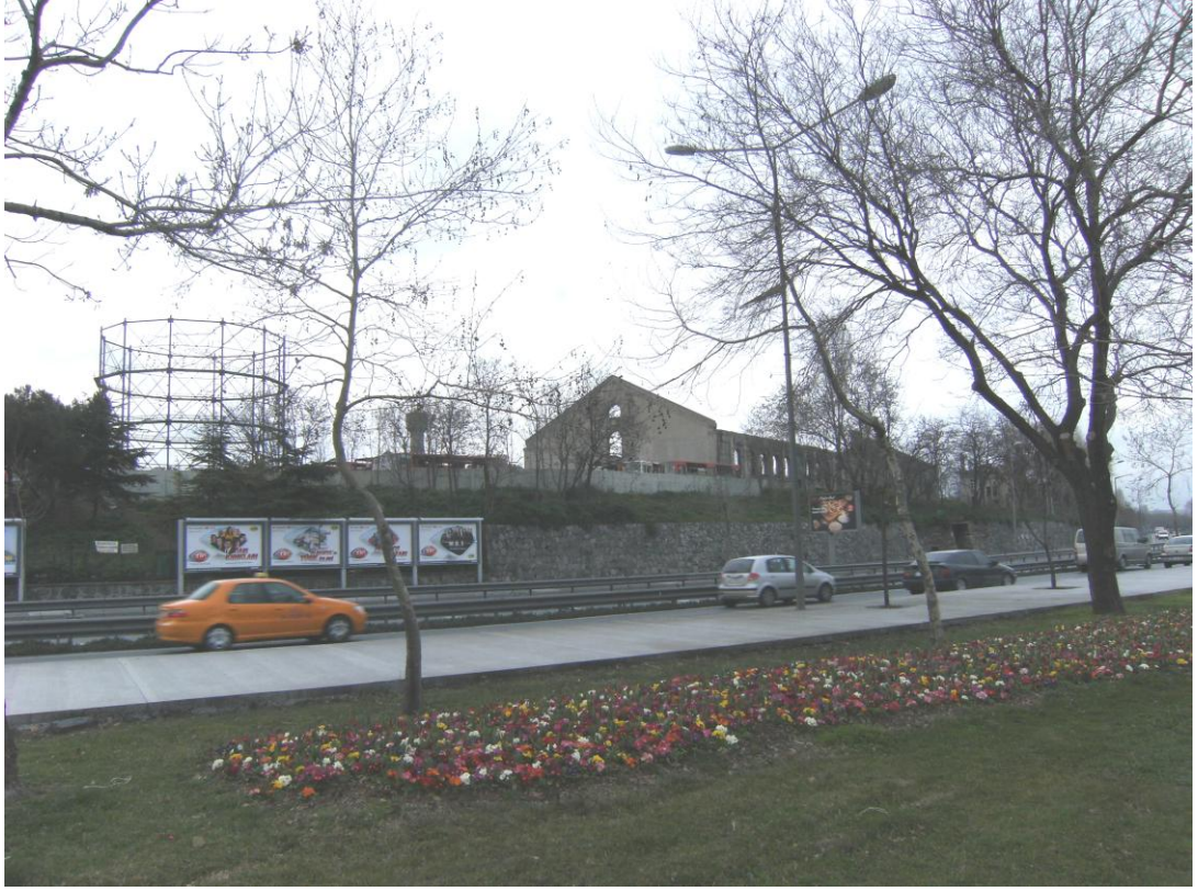
EK 4. Şekil 4. 33: Yedikule Havagazi Santrali sahil yolundan görünüşü. Büyük bir araziye sahip ve denize paralel konumlanmış, binalarıyla şiirsel bir görüntü sergilemektedir. (Fot: Arzu Yoldemir, 2010)
