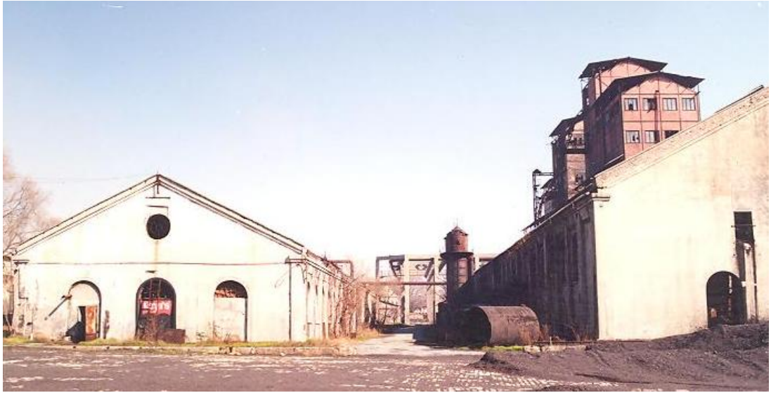
EK 4. Şekil 4. 14: Sağda Transportör WD Fırınlarnı bulunduđu bina, solda Epuratör dairesi, makine ve kazan dairesinin içinde yer aldığı bina görölmektedir. (Anıtlar Kurulu Arşivi, fot: 2000)
