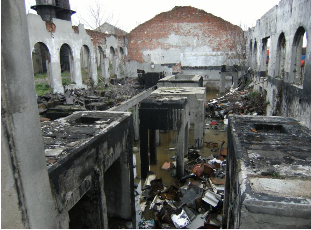
EK 4. Şekil 4. 15: Makine ve kazan dairesi bölümünün içinin 2010 yılındaki durumu. (Fot: Arzu Yoldemir, 2010)
