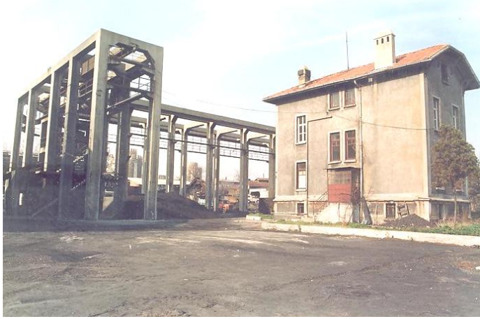
EK 4. Şekil 4. 25: Solda kok nakil tesisatı ve sağda lojman binasına ait fotoğraf. (Anıtlar Kurulu Arşivi. Fot:2000)
