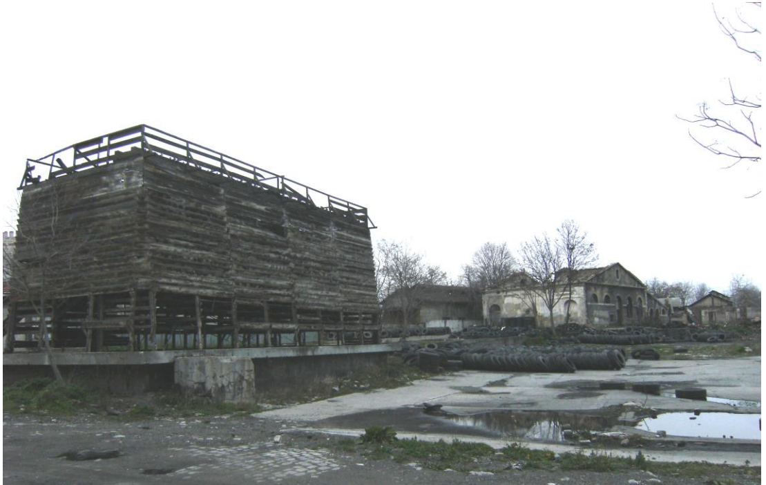
EK 4. Şekil 4. 22: Soğutma ünitesi 2010 yılına ait fotoğrafı. (Fot: Arzu Yoldemir)
