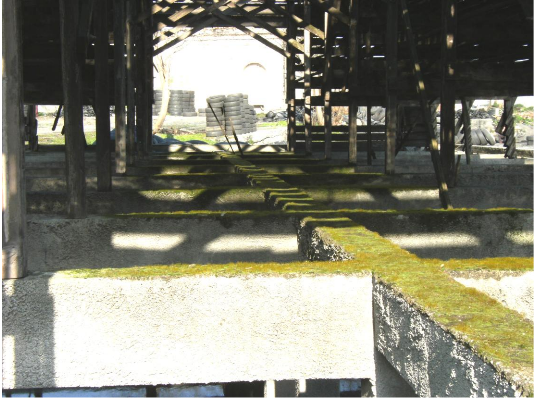
EK 4. Şekil 4. 24: Soğutma ünitesi damıtma ve filtreleme bölümlerine ait detay fotoğrafı. (Fot: Arzu Yoldemir, 2010)
