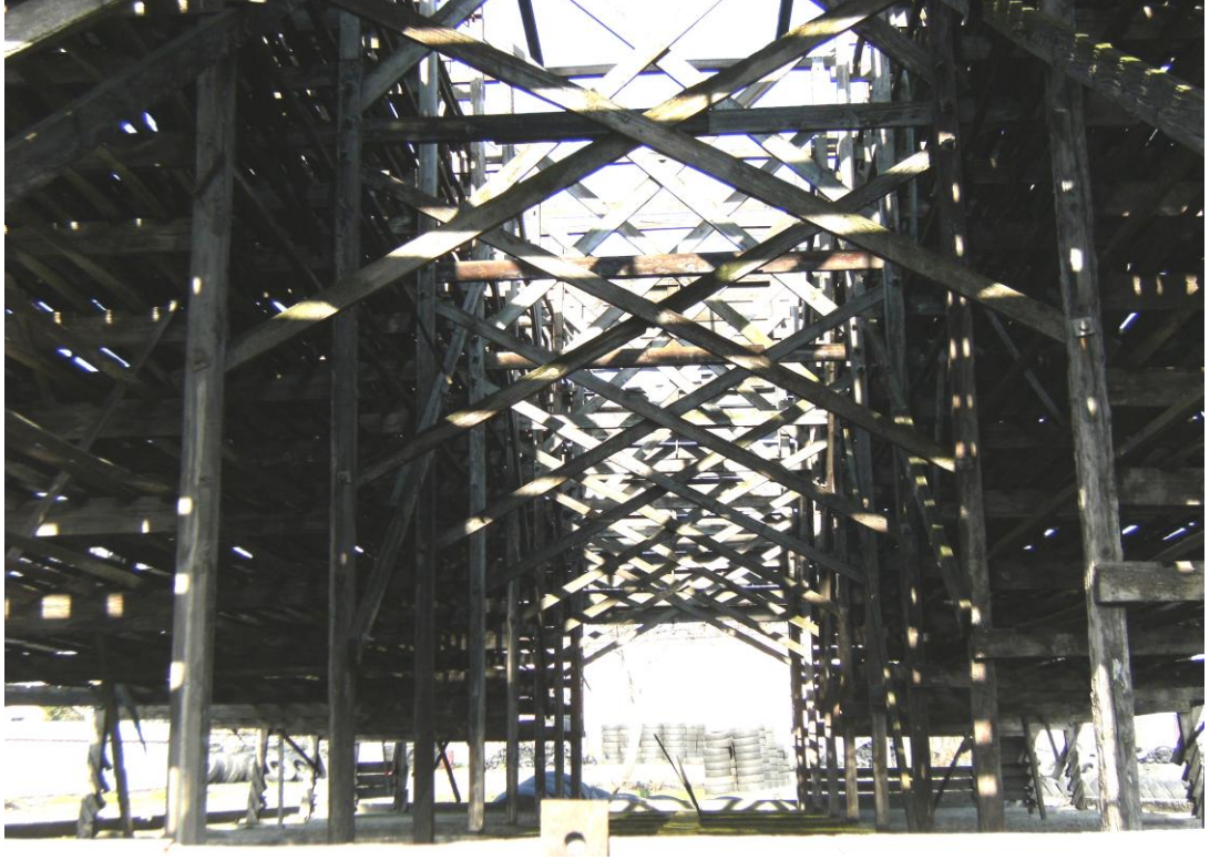
EK 4. Şekil 4. 23: Soğutma ünitesi iç konstrüksiyon detayını gösteren fotoğraf. (Fot: Arzu Yoldemir, 2010)
