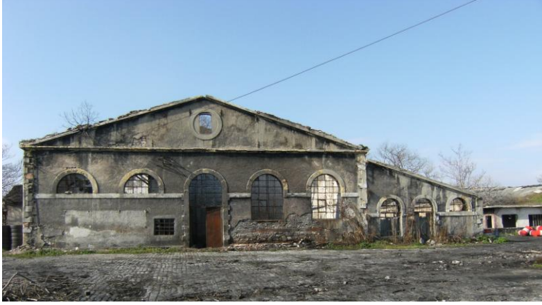
EK 4. Şekil 4. 28:Malzeme ambarı önden görünüşü. (Fot: Arzu Yoldemir, 2010)
