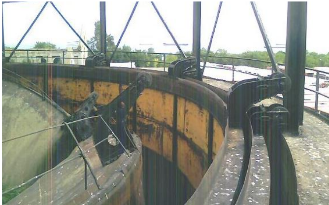
EK 4. Şekil 4. 9: Gazometrenin teleskopik sisteminden detay. (Anıtlar Kurulu Arşivi, fot: 2000)
