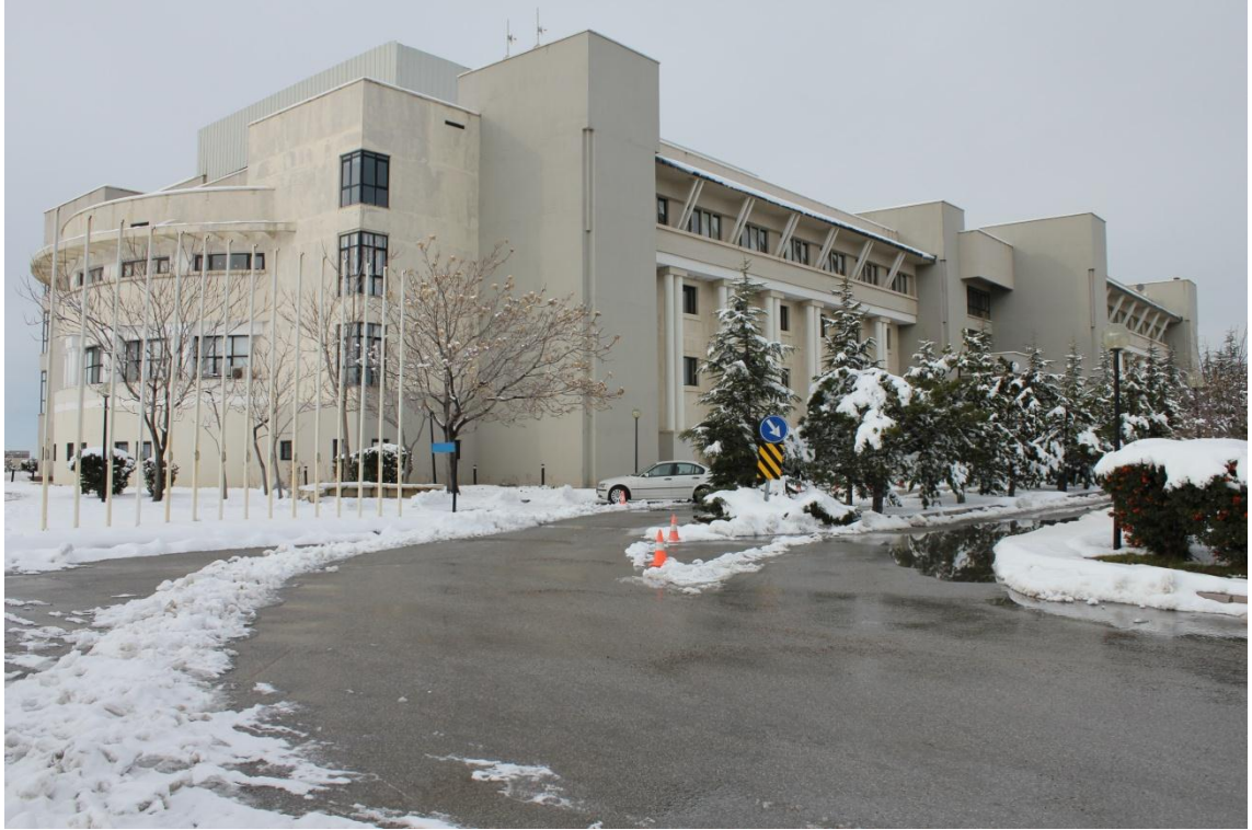
Resim 2: MSSF Binasına güney doğu yönünden bakış.
