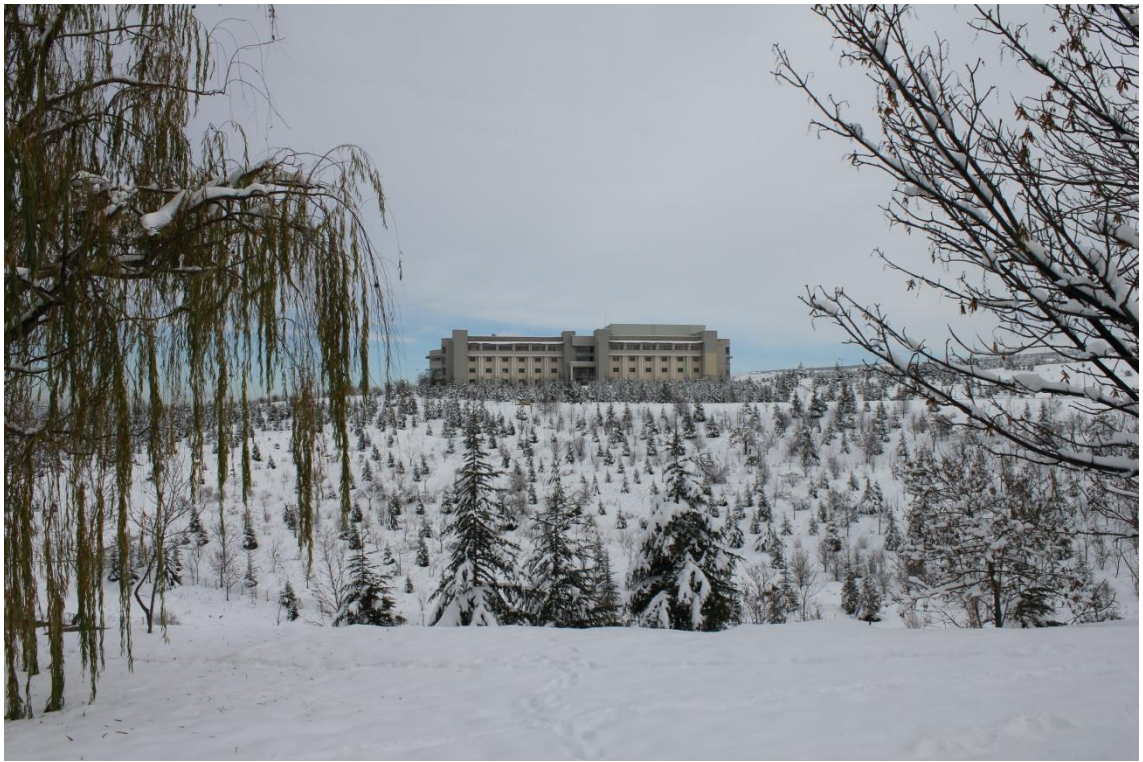
Resim 1: MSSF Binasına batı yönünden bakış.
