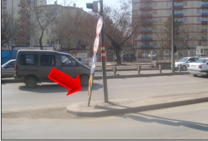
Resim 6.36. Standartlara uygun olarak montajı yapılmadığı için tehlike yaratan yaratan trafik levhası (1) [Dilek, 2010]
