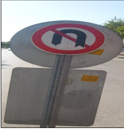
Resim 6.40. Boyutları uygun olmayan trafik levhası (1) [Dilek, 2010]
