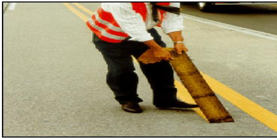
Resim 5.3. Yol bandının sökülmesi [Kalyoncuoğlu, 2007]
