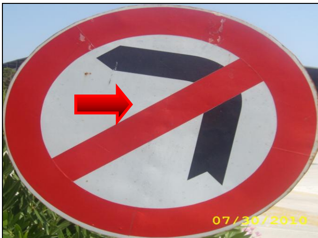
Resim 6.31. Reflektif malzeme kullanılmamış ve uygun olmayan trafik levhası [Dilek, 2010]
