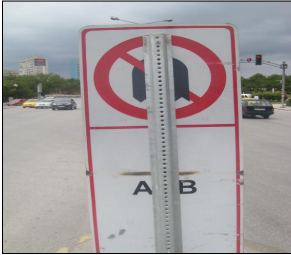
Resim 6.45. Boyutları uygun olmayan trafik levhası (6) [Dilek, 2010]
