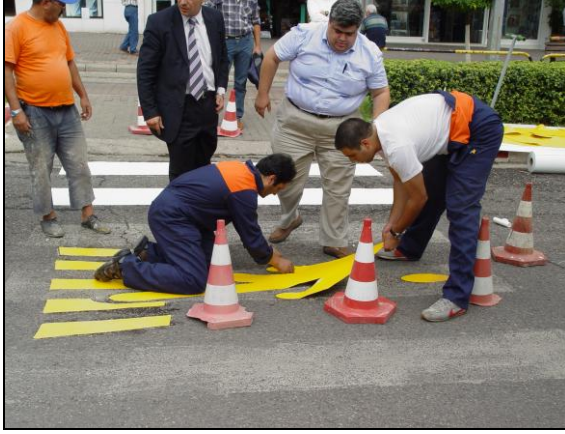
Resim 5.5. Yol bantlarının uygulama aşaması (2) [Kalyoncuoğlu, 2007]
