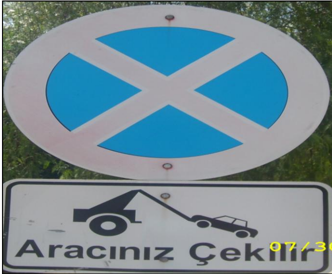
Resim 6.29. Reflektif malzeme kullanılmamış trafik levhası [Dilek, 2010]
