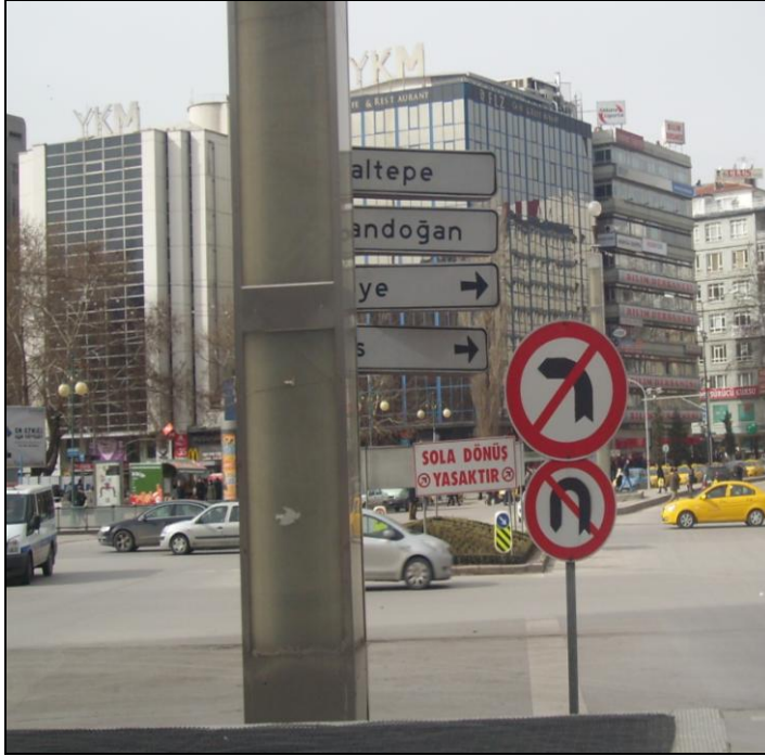
Resim 6.44. Boyutları uygun olmayan trafik levhası (5) [Dilek, 2010]
