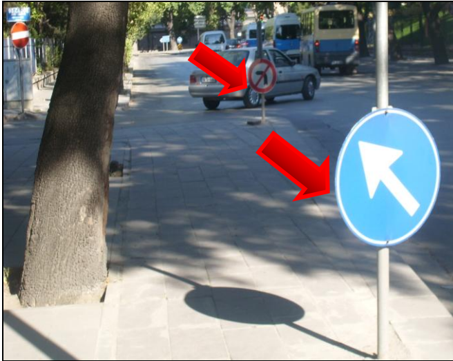
Resim 6.37. Standartlara uygun olarak montajı yapılmadığı için tehlike yaratan trafik levhası (2) [Dilek, 2010]
