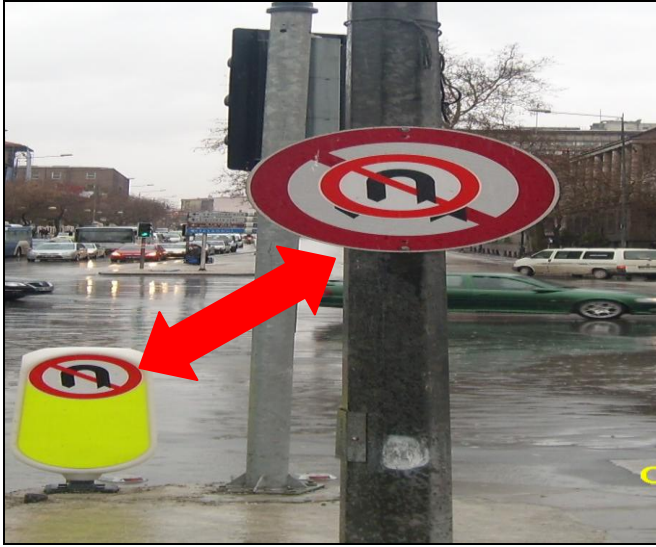
Resim 6.43. Boyutları uygun olmayan trafik levhası (4) [Dilek, 2010]
