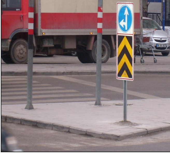
Resim 6.42. Boyutları uygun olmayan trafik levhası (3) [Dilek, 2010]
