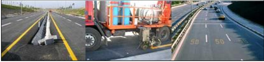
Resim 5.10. Termoplastik yol çizgi boyaalarının uygulanması ve görünümü [Dilek, 2010]
