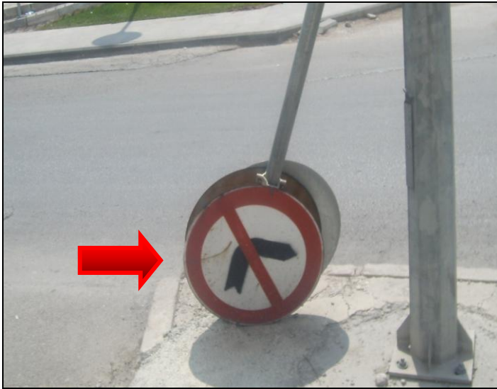
Resim 6.39. Standartlara uygun olarak montajı yapılmadığı için tehlike yaratan trafik levhası (4) [Dilek, 2010]
