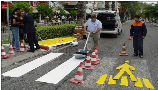
Resim 5.4. Yol bantlarının uygulama aşaması (1) [Kalyoncuoğlu, 2007]
