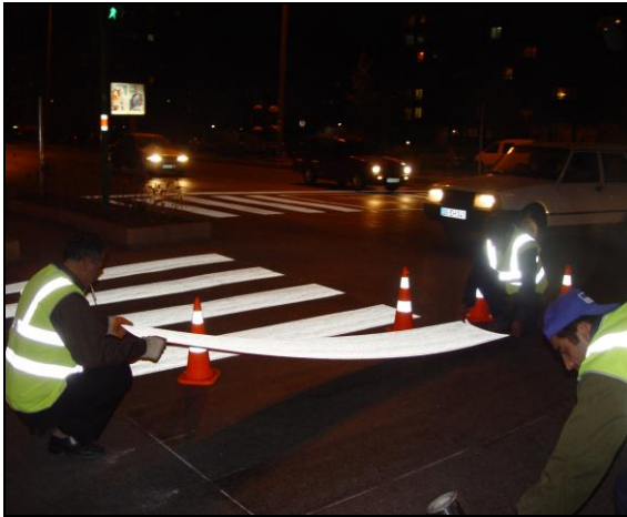
Resim 5.7. Yol bantlarının uygulama aşaması (4) [Kalyoncuoğlu, 2007]
