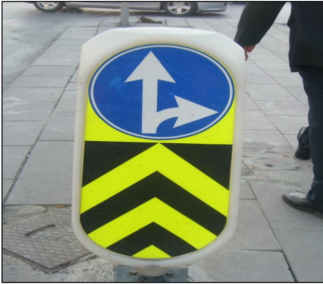
Resim 6.41. Boyutları uygun olmayan trafik levhası (2) [Dilek, 2010]
