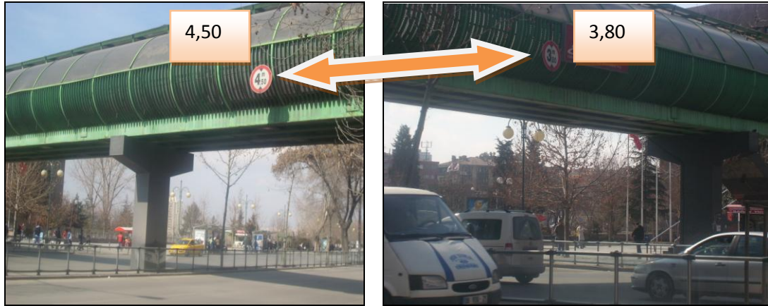
Resim 6.60. Yol yapı yüksekliklerinin yanlış gösterilmesi (Sihhiye) [Dilek, 2010]
