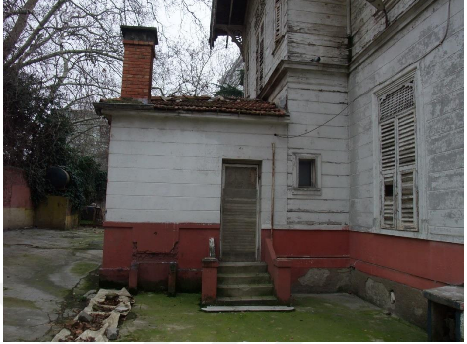
Şekil B.2.5 (Gezeryan Köşkü kuzeybatı cephesi) (Gökçınar, 2014)
