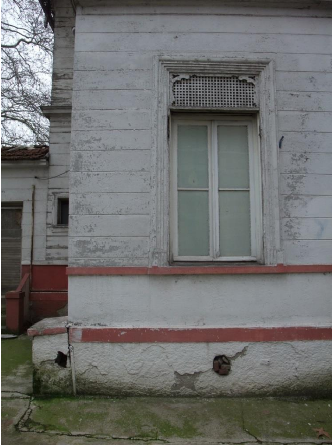
Şekil B.2.4 (Gezeryan Köşkü kuzeybatı cephesi) (Gökçınar, 2014)
