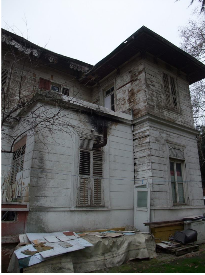
Şekil B.2.11 (Gezeryan Köşkü güneydoğu cephesi) (Gökçınar, 2014)
