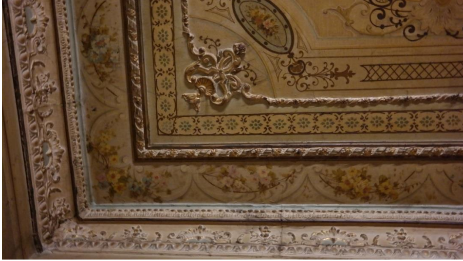
Şekil 3.10 : Kabartma bezemeler-kornişler (Z03 mekanı) (Gökçınar, 2014).
