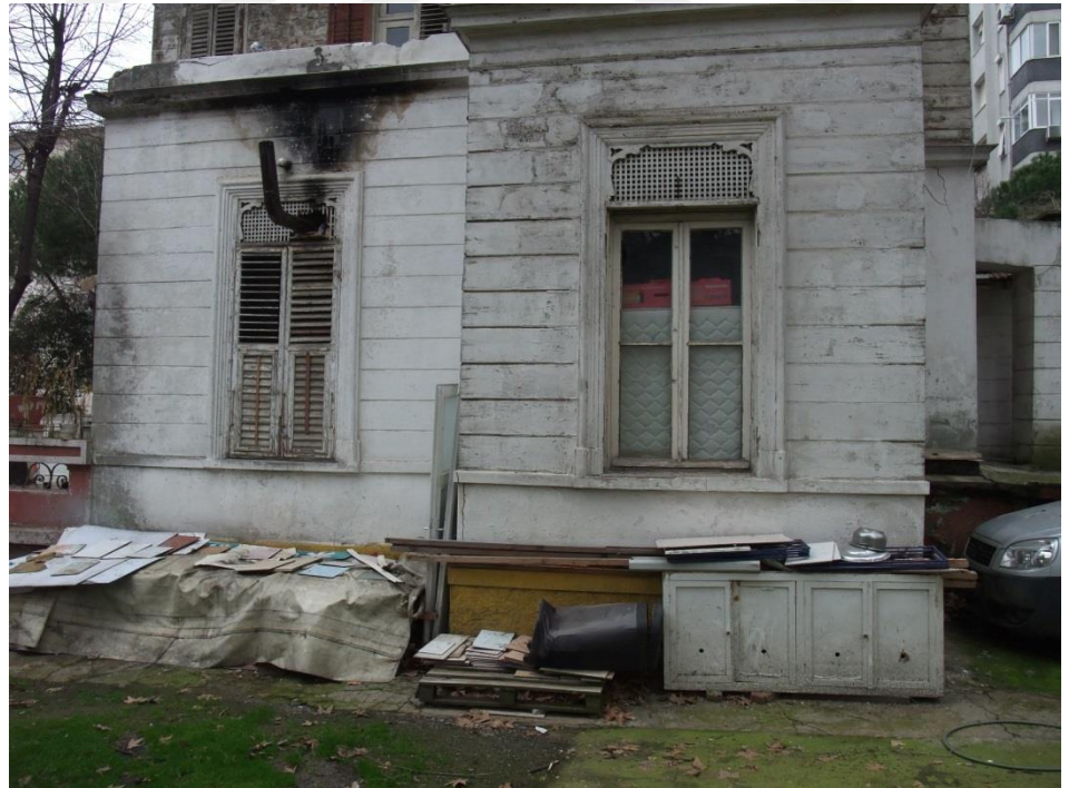
Şekil B.2.10 (Gezeryan Köşkü güneydoğu cephesi) (Gökçınar, 2014)
