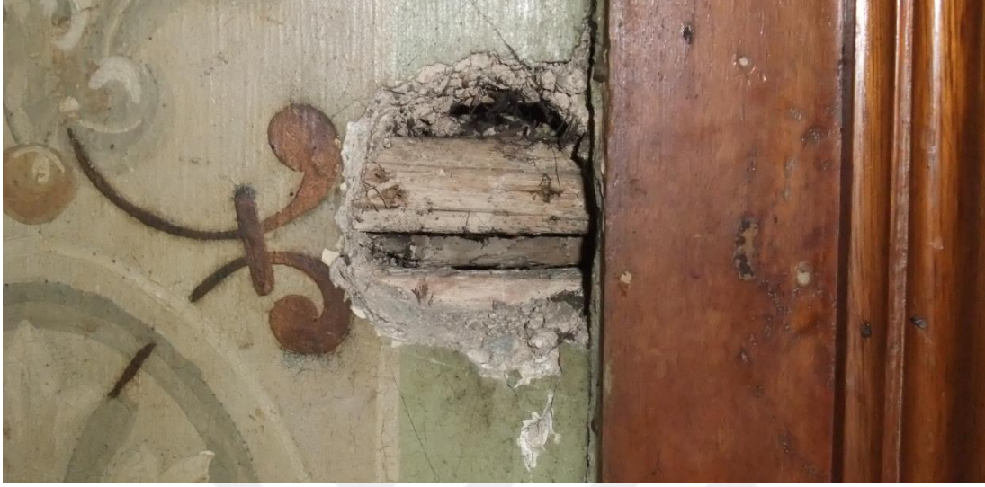
Şekil 3.7 : Gezeryan Köşkü – Ahşap karkas duvarlar (Gökçınar, 2014).
