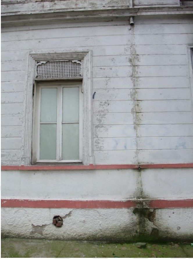
Şekil B.2.3(Gezeryan Köşkü kuzeybatı cephesi) (Gökçınar, 2014)
