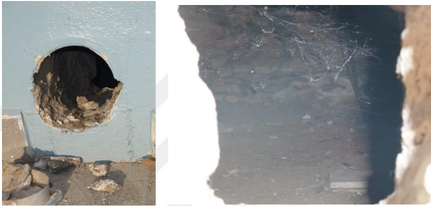
Şekil 3.6 : Kabasakal Mehmet Paşa Harem Köşkü havalandırma boşluğu (Gökçınar,2014).
