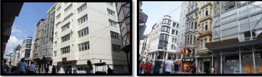
Şekil 4.48. İstiklal Caddesi'nde restorasyon geiren yeni binaların, eski bina karakteriyle uyumsuz grnm (Orijinal 2016)
