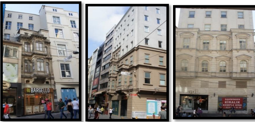
Şekil 4.46.İstiklal Caddesi'nde restorasyon ile değişen bina cepheleri ve kat yükseklikleri
