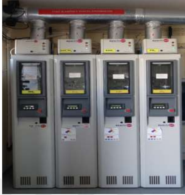
Şekil 3.35 MOCVD büyütmelerinde hidrit kaynağı olarak kullanılan Arsin, fosfin, amonyak ve n tipi katkılama için kullanılan silan gazlarının yer aldığı kabinetler.
