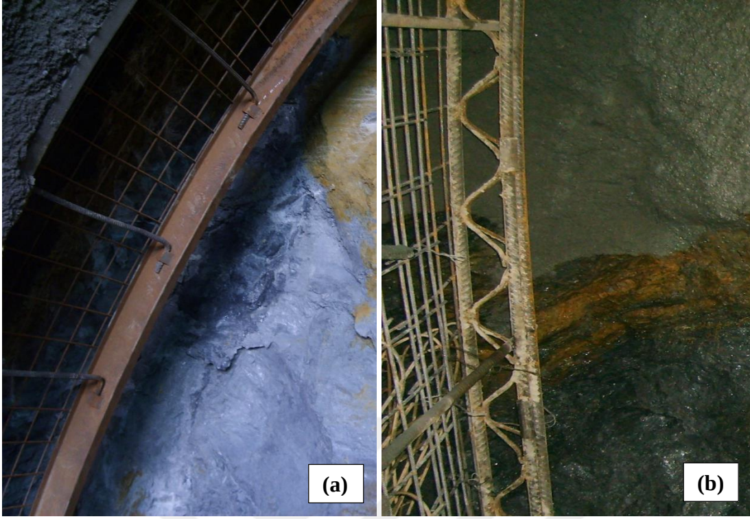
Şekil 4.2 : (a) I profil çelik iksa. (b) Kafes iksa.
