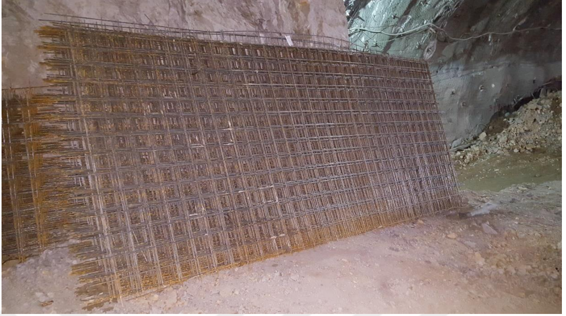
Şekil 4.1 : Hasır çelikler.
