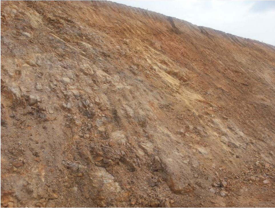
Şekil 7.12 : Tünel çevresinde gözlemlenen kumtaşı-silttaşı.
