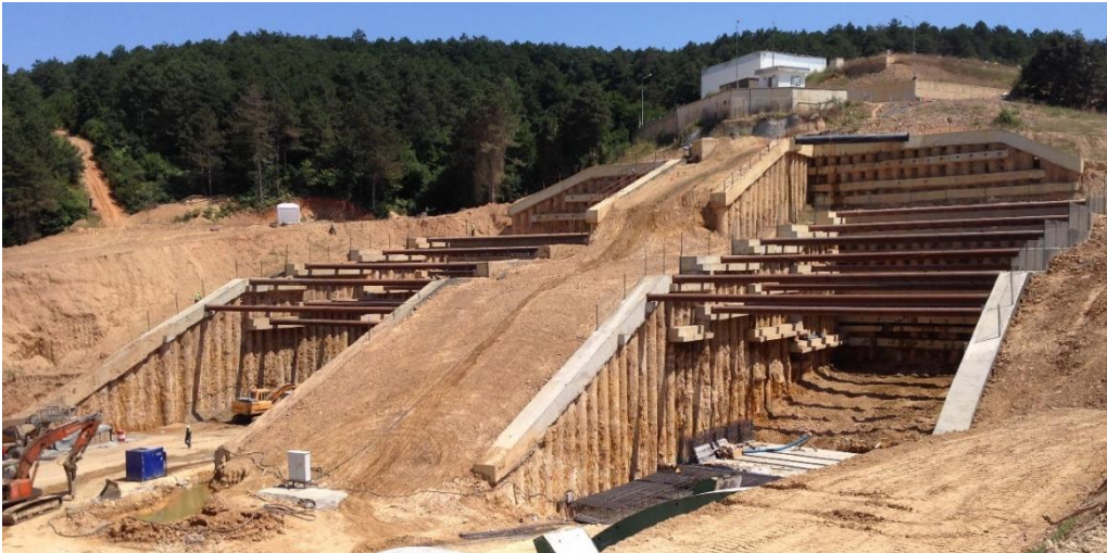
Şekil 7.35 : Çamlık Tüneli giriş portalinden İSKİ su deposunun görünüşü.
