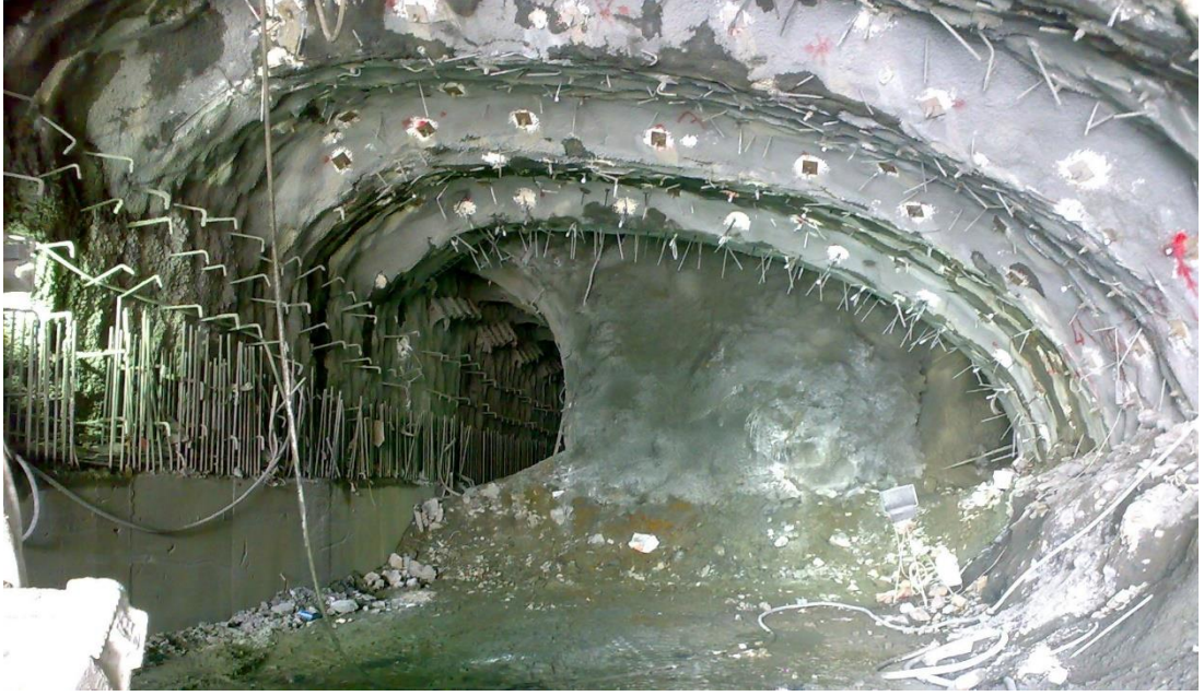
Şekil 3.2 : Hasdal Tünelinde açılan pilot tünel.
