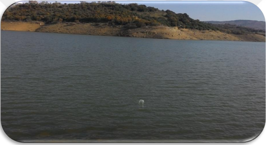
Şekil 3.3. Bayramiç Baraj suyu alımı esnasındaki görüntü
