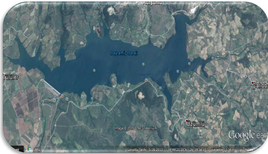
ekil 3.10. Bayrami barajı uydu grnts
