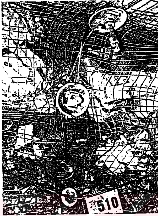
Şekil 3.37. Tabanyolunda bileşik kaya saplamalarının çelik hasır ile birlikte uygulaması.
