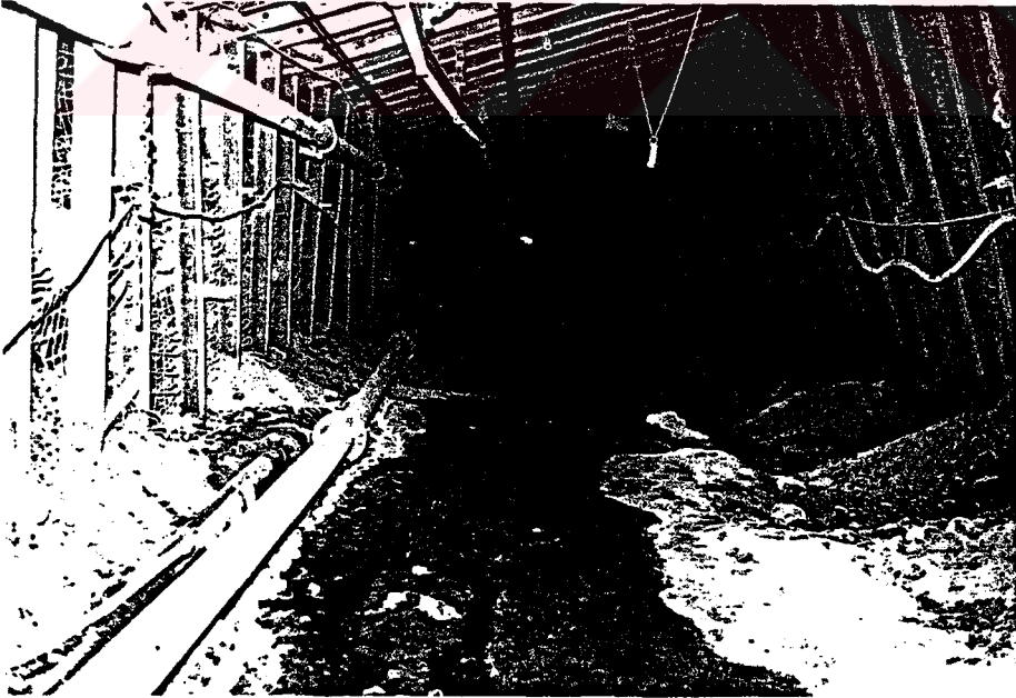
Şekil 4.11. O.A.L.'de tabanyolunun açıklık kesiti ve tabanyolu tahkimatı.
