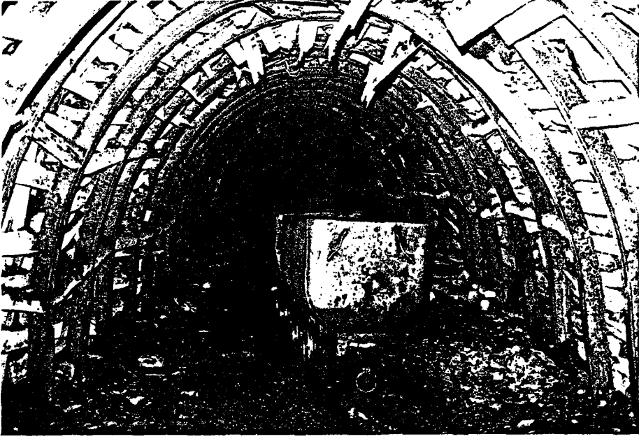
Şekil 4.5. Ayağın önünde tabanyolu tahkimatının durumu.
