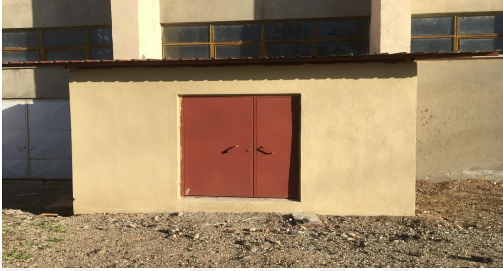
Şekil 4.19. Elektronik atıklar ve piller gibi atıklar için geçici depo alanı
