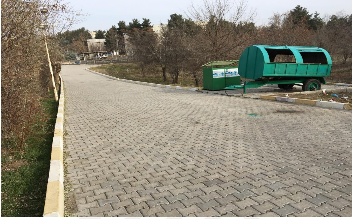
Şekil 4.3. Dicle Üniversitesi Lojmanlarına ait atık toplama noktası
