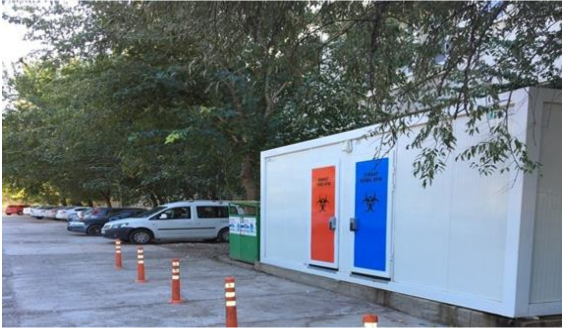
Şekil 4.21. Tıbbi atık deposu
