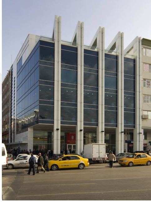
Şekil 2. 57 Ziraat Bankası Kadıköy Şubesi [36]
