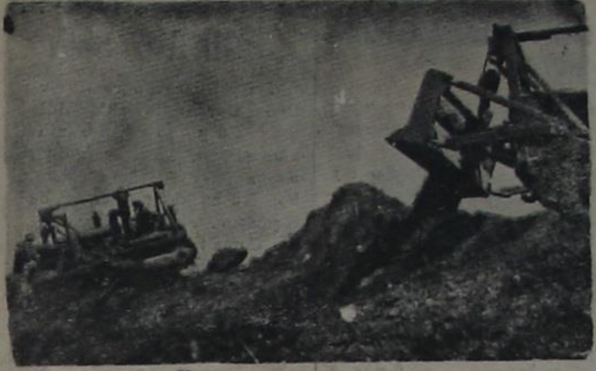
Karataş yolu inşa edilirken
