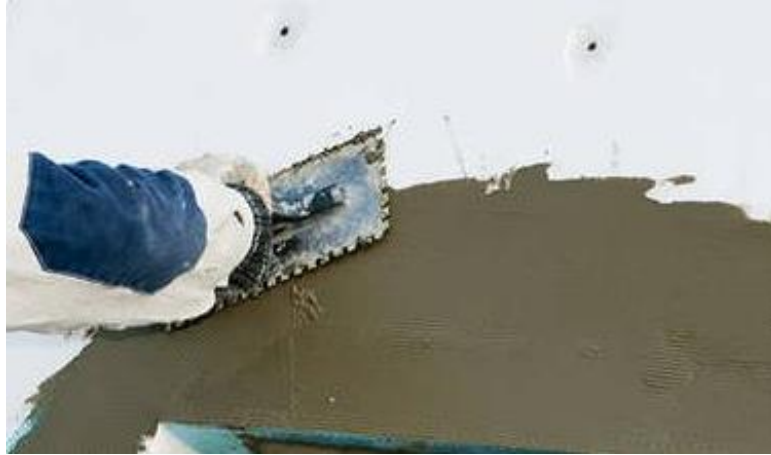
Şekil 2.4. Isı yalıtım malzemesinin üzerine uygulanan sıva çalışması
