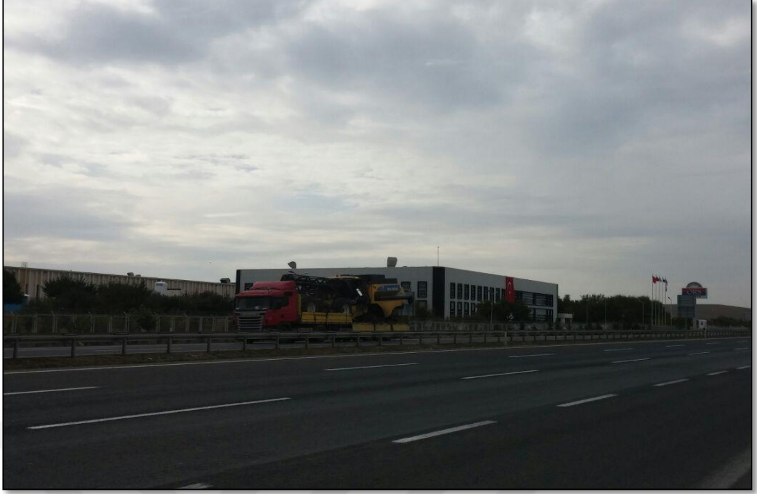
Foto 32: Ankara Asfaltı Kenarında Bulunan ORS Fabrikası Genel Görünümü
