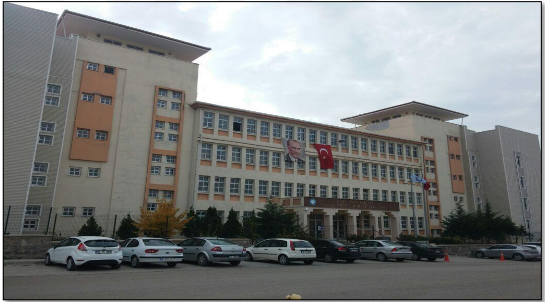
Foto 16: Gazi Üniversitesi Fen-Edebiyat Fakültesi Binası
