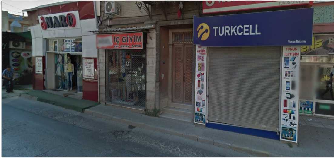
Şekil 4.72 Uğur Mumcu Caddesi'ndeki dar kaldırımın görünümü (Kişisel arşiv, 2013)
