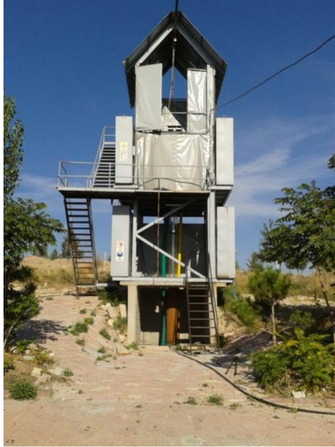
Şekil 3.1. Pompa deneme tesisi
