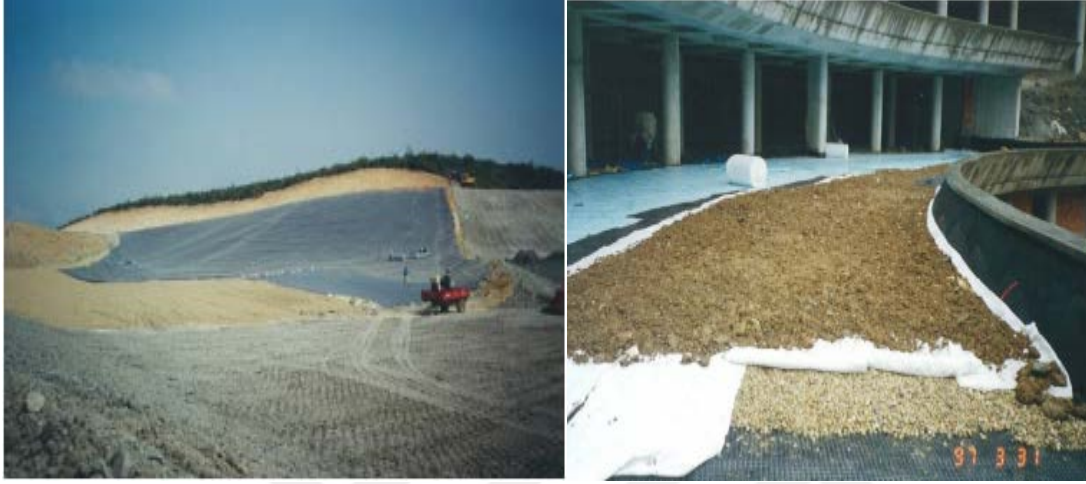
Şekil 1.3. Jeotekstil örnekleri (Kemerburgaz Katı Atık Sahası, konutlar için ayırma-drenaj-filtrasyon fonksiyonu ) [6]
