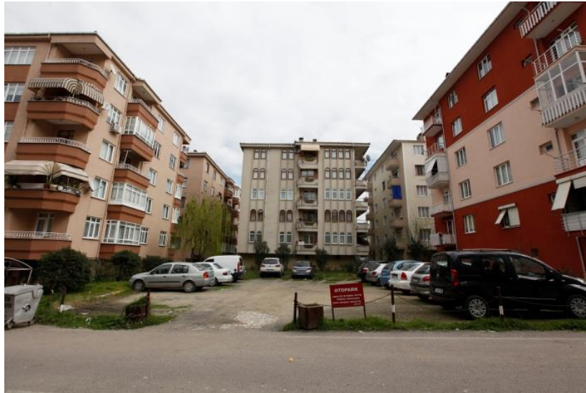
Şekil 5.11. Yıkılan binalardan arda kalan alanların kullanımı
