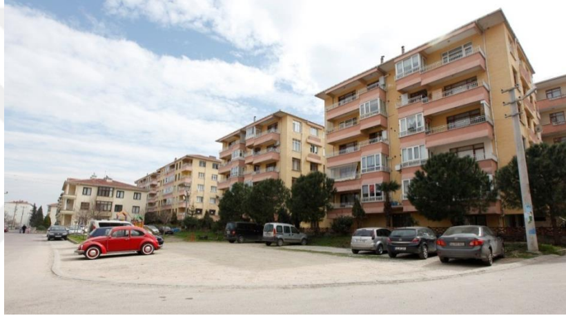
Şekil 5.10. Yıkılan binalardan arda kalan alanlar
