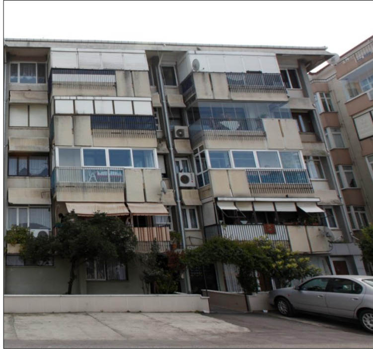
Şekil 5.47. Yüzbaşılar Mahallesi'nde ağır cephe yükleri yapısal risk unsuru barındıran yapı örneği
