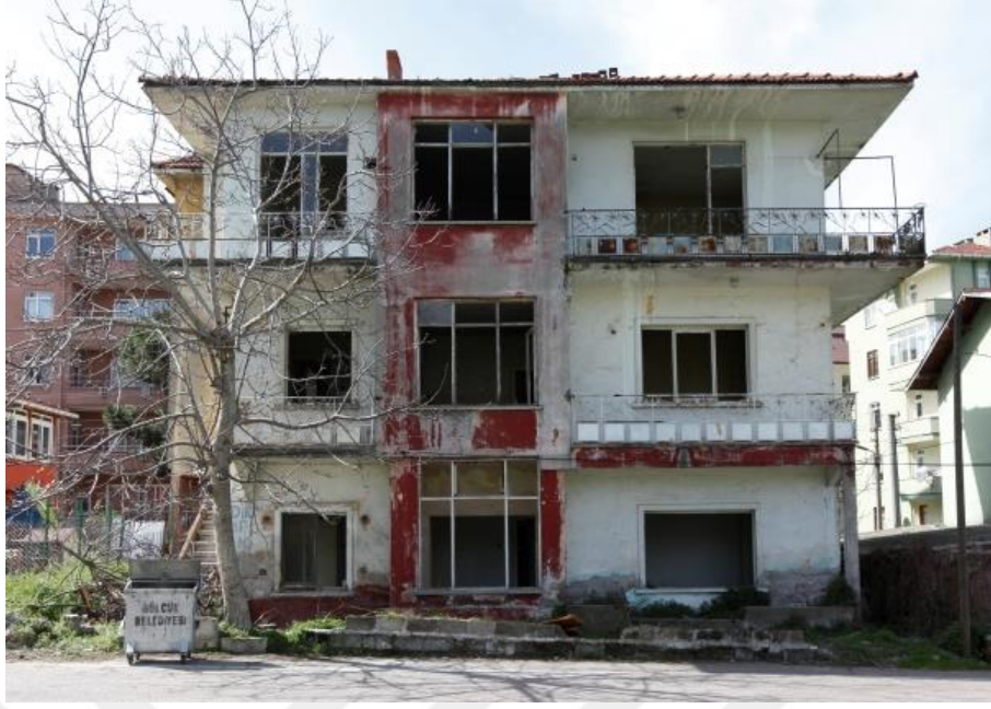
Şekil 5.28. Alanda yığma yapı örnekleri ve duvar boşluğu ve duvar boşluk düzeni durumları
