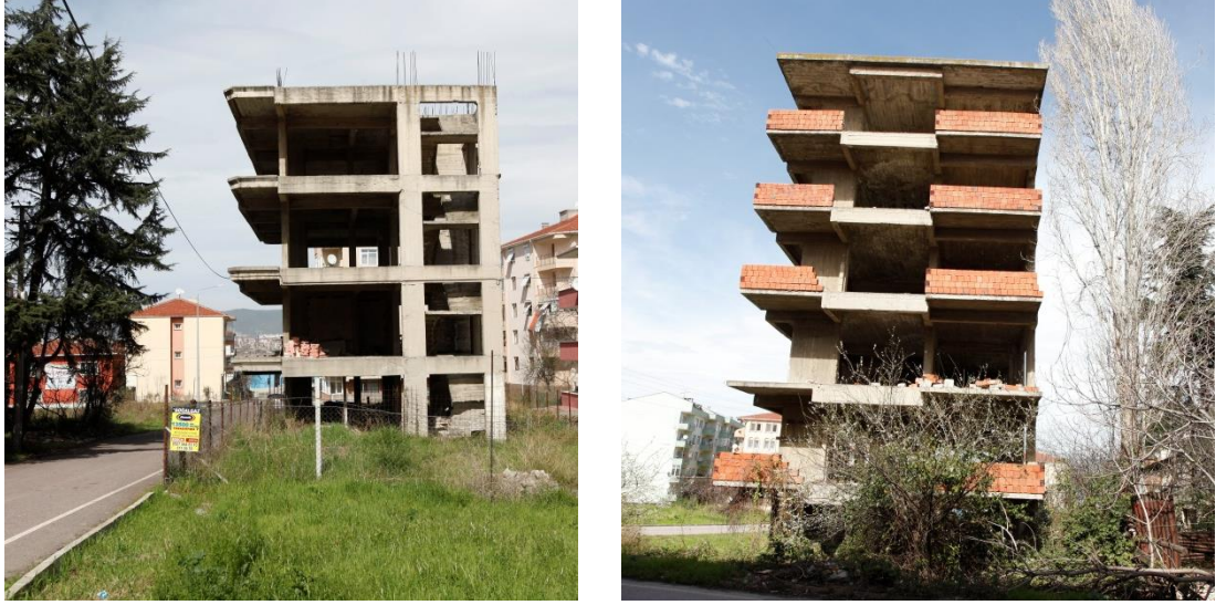
Şekil 5.15. 1999 Marmara Depremi’nden sonra yapımına devam edilmeyen güvenlik önlemi alınmayan yapılar
