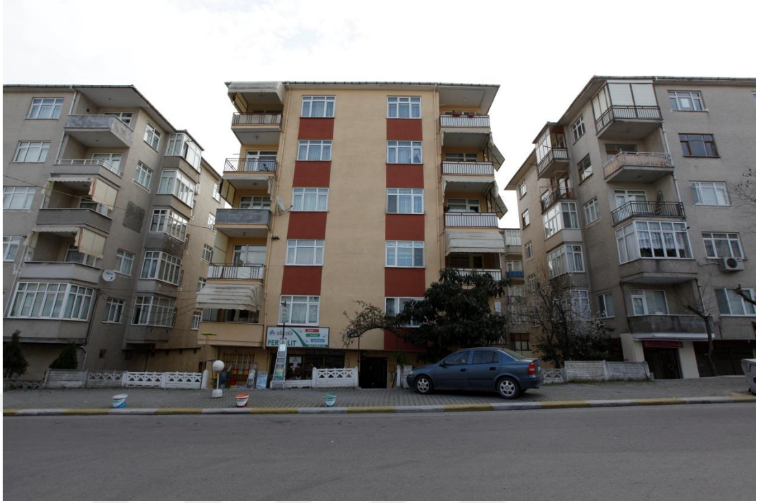
Şekil 5.19. 1975 Deprem Yönetmeliğine bağlı olarak üretilmiş örnek yapılar
