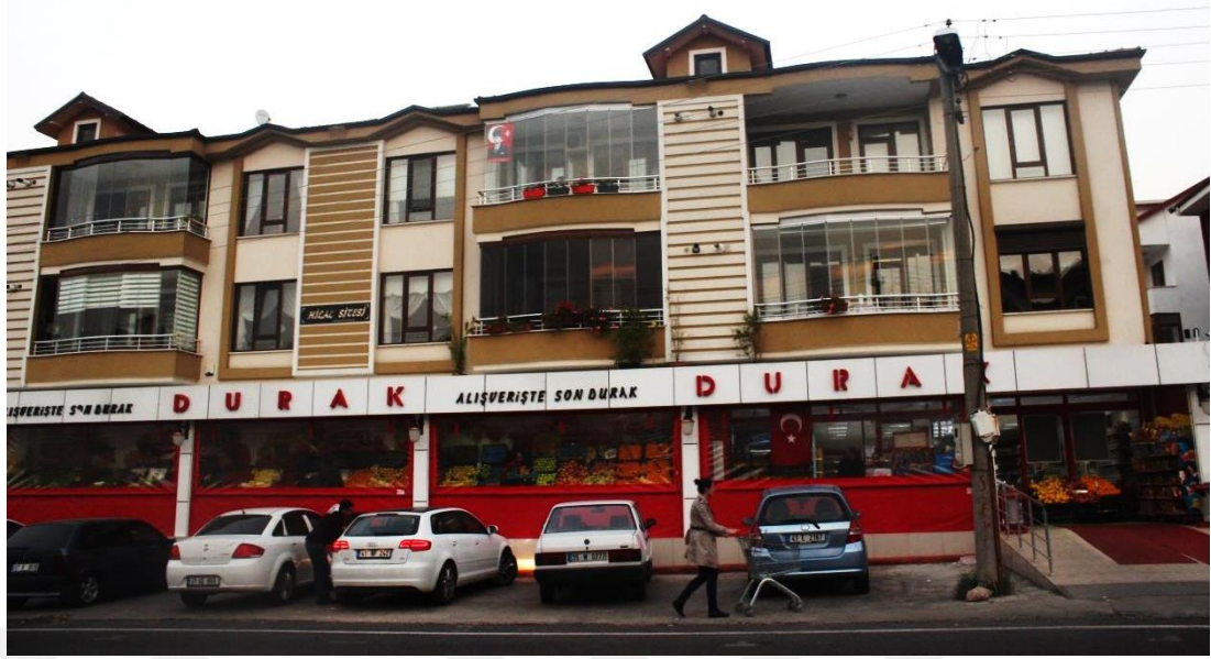
Şekil 5.31. Yüzbaşılar Mahallesi “yumuşak kat-zayıf kat” yapısal risk unsuru barındıran yapı örneği
