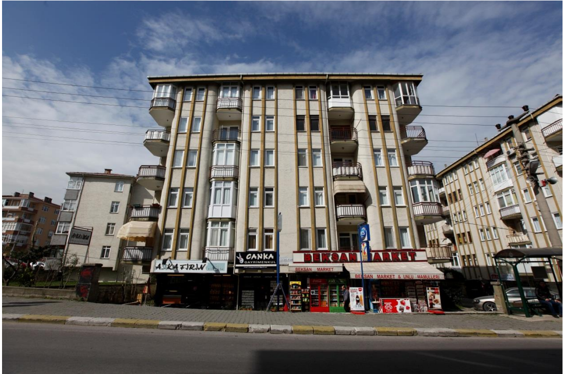
Şekil 5.45. Yüzbaşılar Mahallesi'nde fonksiyona bağlı ikincil riskleri barındıran yapı örneği
