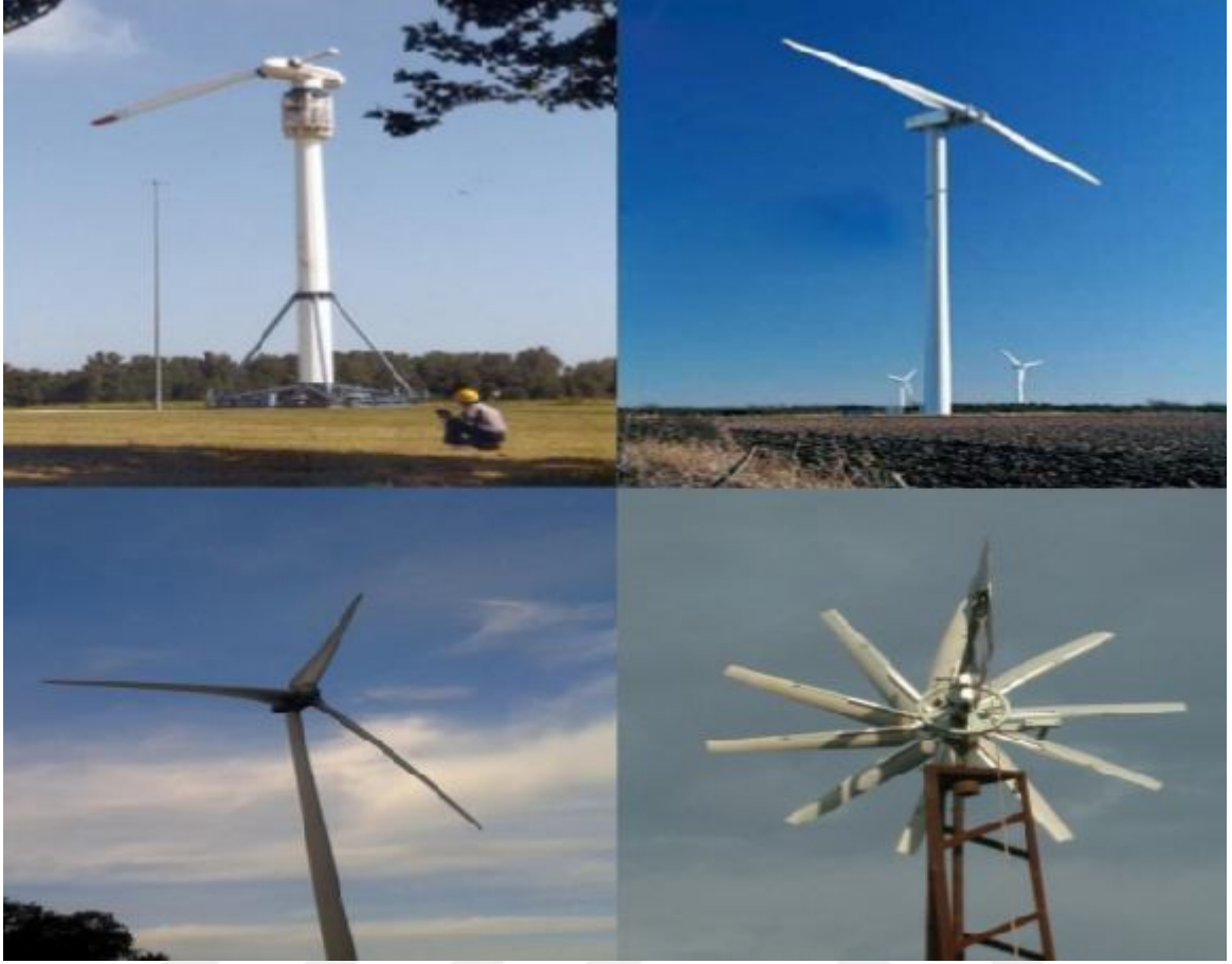
Şekil 5.4. Pervane sayılarına göre rüzgâr türbinleri
