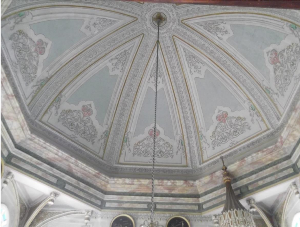
Şekil 3.24 Teşvikiye Camisi'nin kubbe eteğinin iç görünüşü
