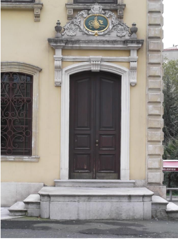
Şekil 3. 2 Hünkâr Kasrı Batı Girişi
