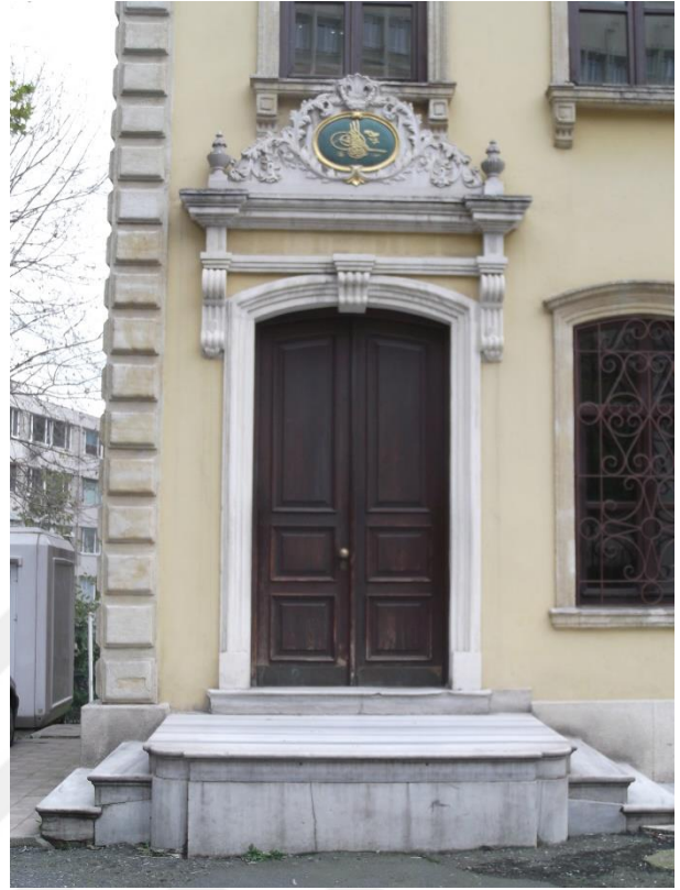
Şekil 3. 3 Hünkâr Kasrı Doğu Girişi
